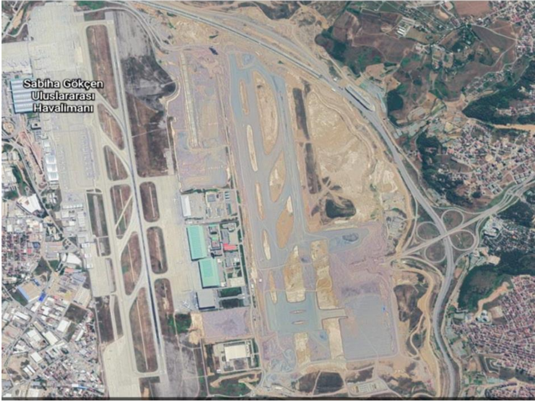
Şekil 3.3. Sağ tarafta birinci pist ve sol tarafta yapılmakta olan ikinci pist (Google Earth, 2020)
