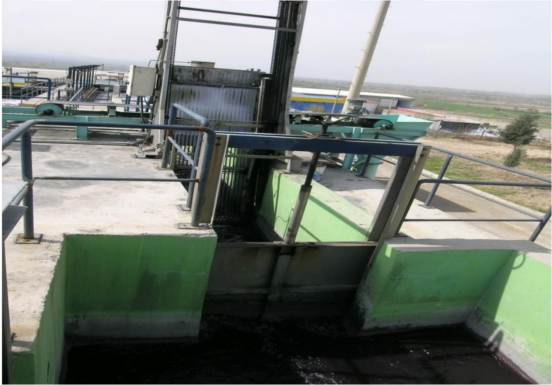
Şekil 3.5. Giriş yapısı ve kaba ızgara.
