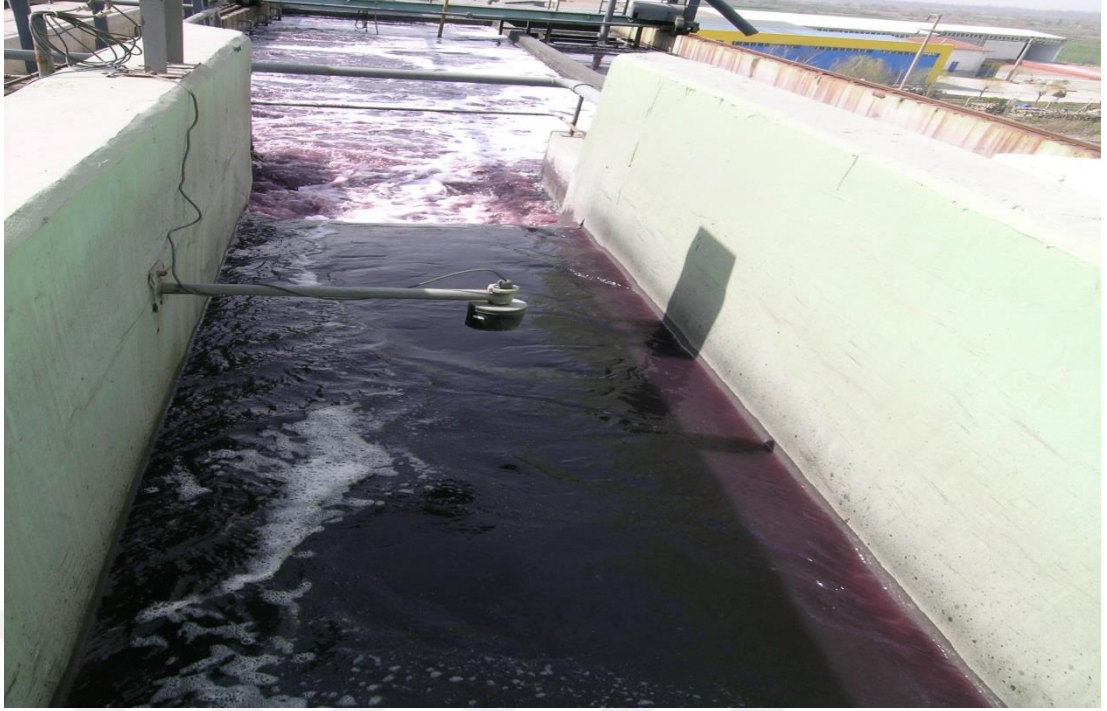
Şekil 3.6. Parshal savağı ve debimetre.
