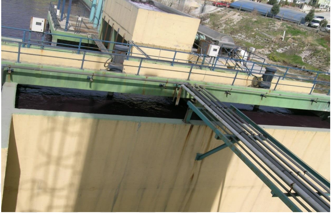
Şekil 3.9. Hızlı karıştırıcılar.
