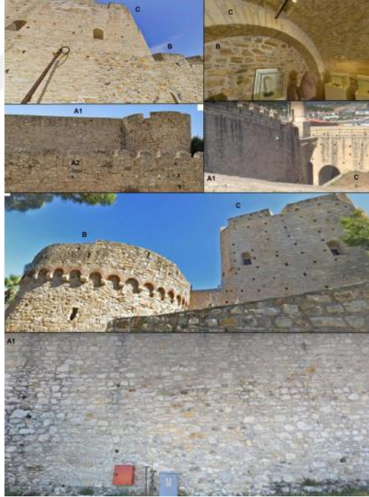
Resim 116: Çeşme Kalesi. Farklı Duvar İşçiliklerinden Örnekler.
