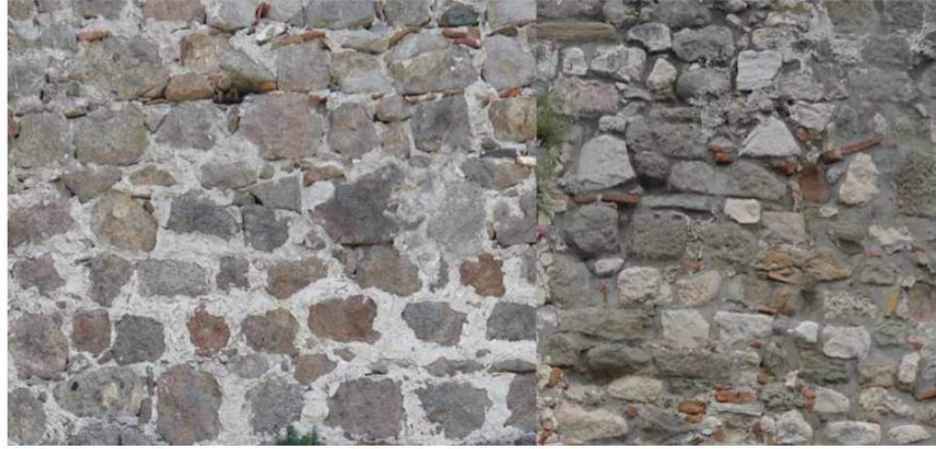
Resim 34: Güzelhisar ve Amasra Kalelerinin Konstrüksiyon Teknikleri.
