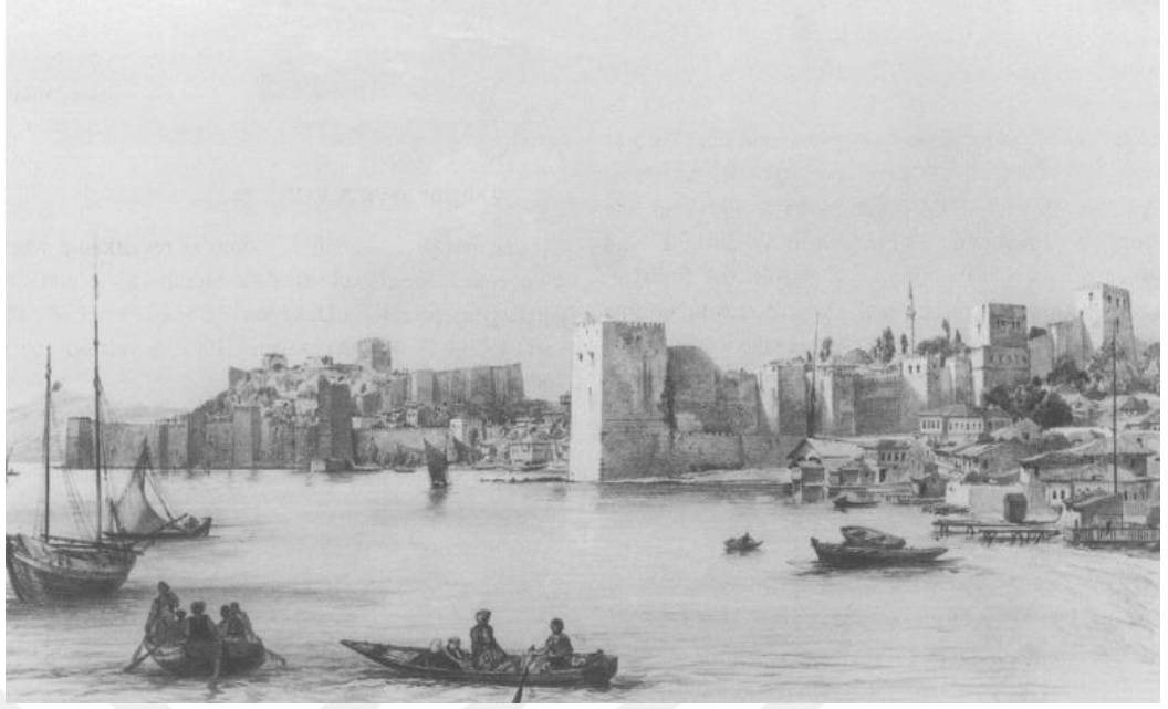
Resim 35: Sinop Kalesi'nin Güney ve Doğu Duvarlarının Limandan Görünümü.
