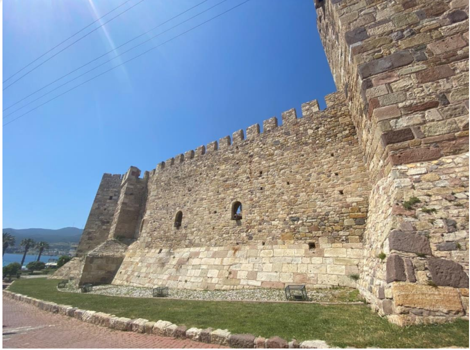
Resim 76: Çandarlı Kalesi. Güney cephe. Farklı duvar teknikleri. Fotoğraf: Batuhan Servet Gürkan.
