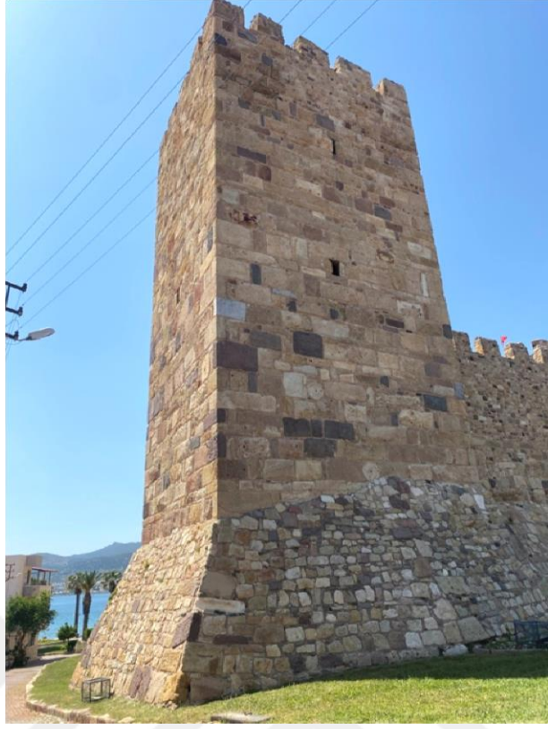
Resim 76: Çandarlı Kalesi. Güney cephe. Farklı duvar teknikleri. Fotoğraf: Batuhan Servet Gürkan.
