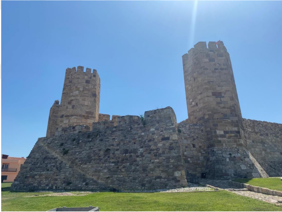
Resim 70: Çandarlı Kalesi. Doğu cephe. Fotoğraf: Batuhan Servet Gürkan.
