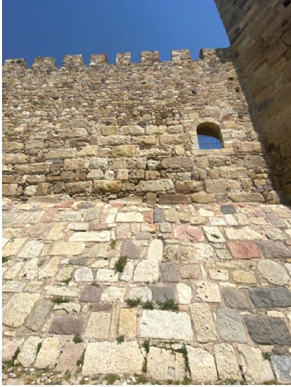
Resim 80: Çandarlı Kalesi. Batı cephe. Farklı duvar teknikleri. Fotoğraf: Batuhan Servet Gürkan.
