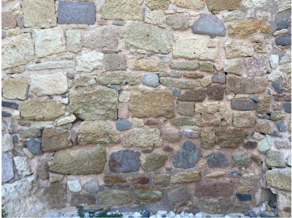
Resim 72: Çandarlı Kalesi. Doğu cephe. Farklı duvar teknikleri. Fotoğraf: Batuhan Servet Gürkan.
