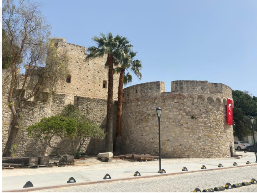
Resim 112: Çeşme Kalesi. Batı cephe. Fotoğraf: Batuhan Servet Gürkan.
