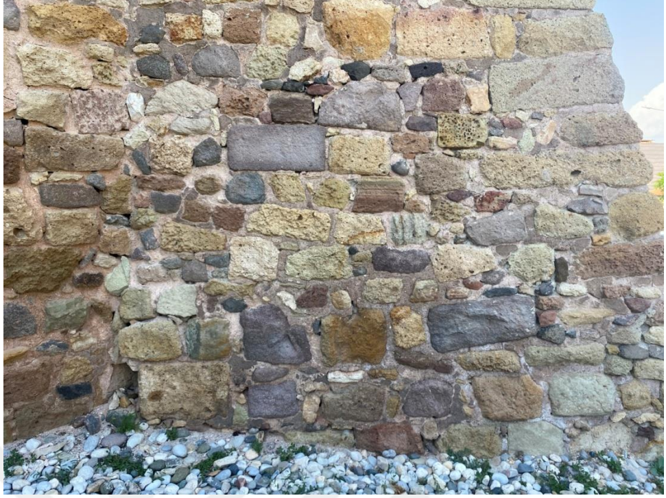
Resim 71: Çandarlı Kalesi. Doğu cephe. Farklı duvar teknikleri. Fotoğraf: Batuhan Servet Gürkan.
