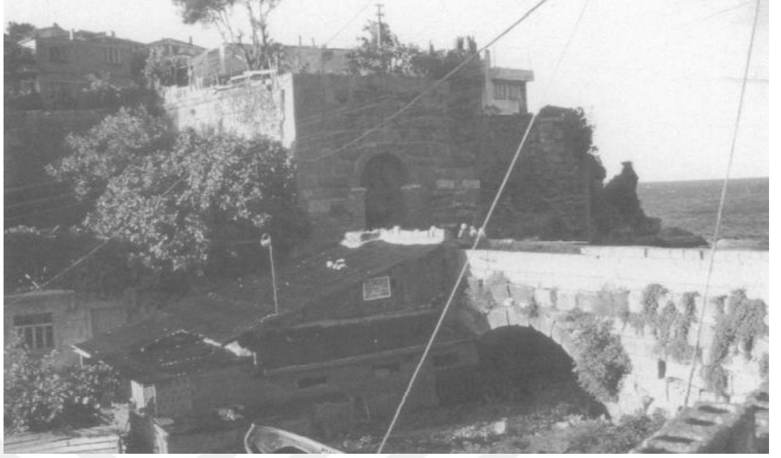
Resim 29: Amasra. Boztepe Kapısı'nın (Karanlık Kapı) Güneybatıdan Görünüşü.
