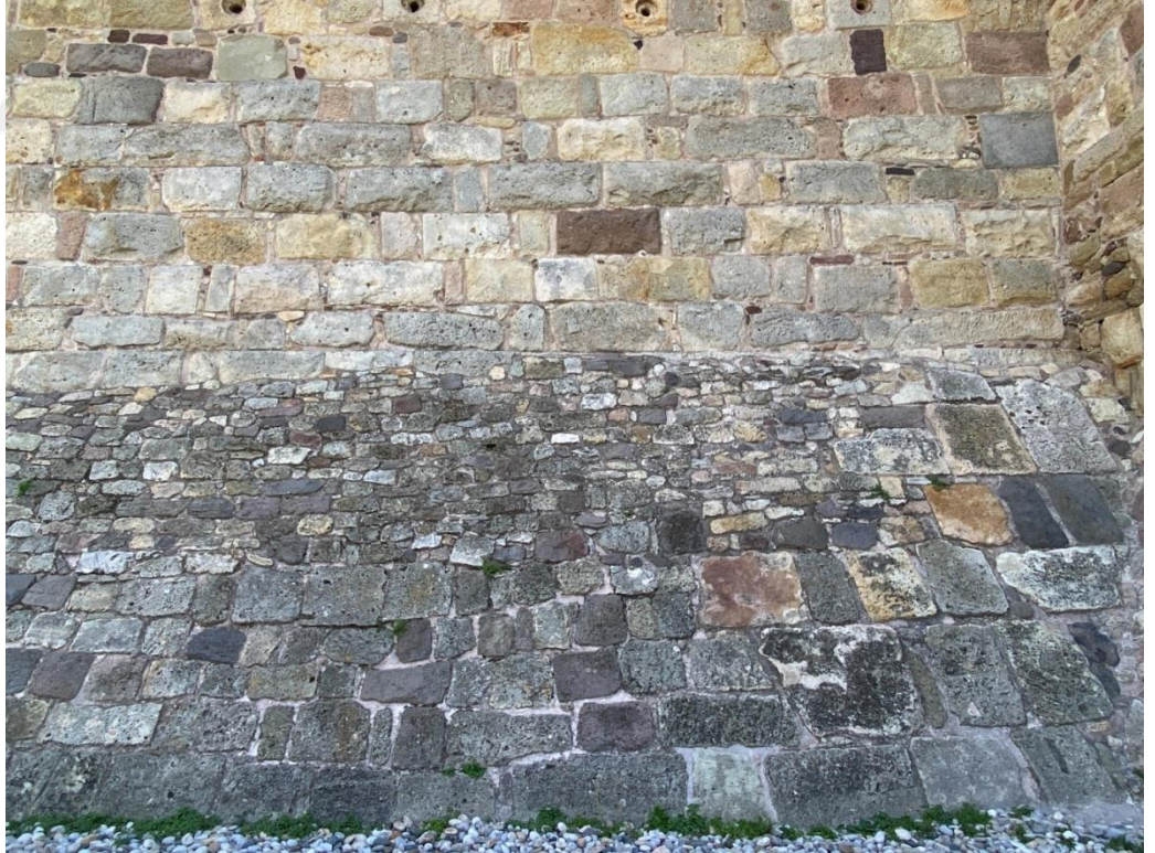
Resim 83: Çandarlı Kalesi. Kuzey cephe. Farklı duvar teknikleri. Fotoğraf: Batuhan Servet Gürkan.
