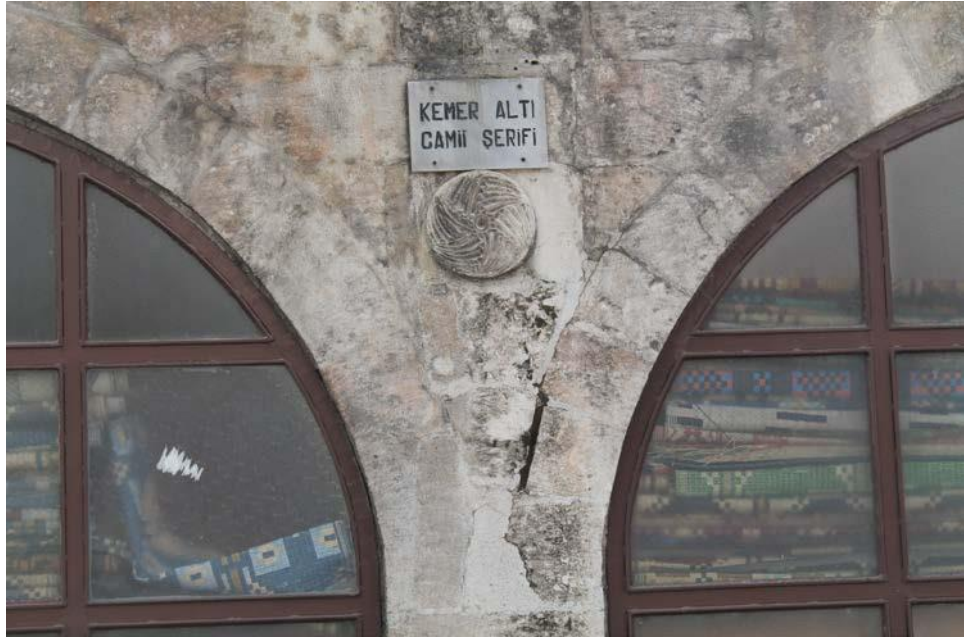
Fotoğraf- 51: Kemeraltı Camii, kuzey cephe
