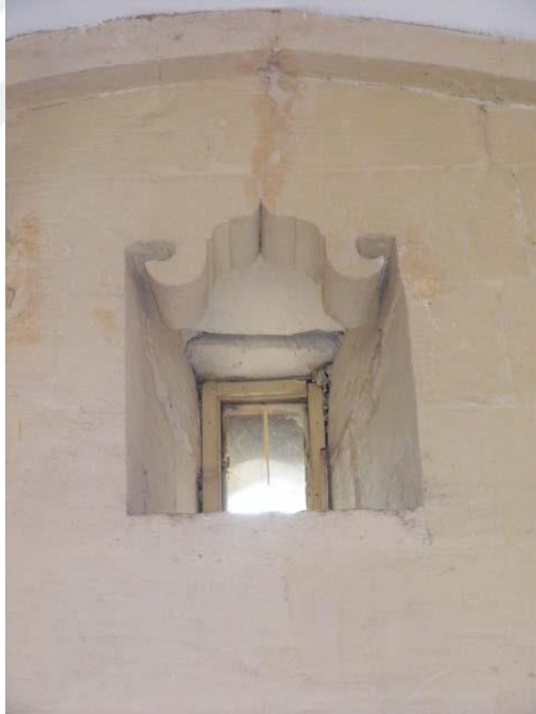
Fotoğraf- 105: Alemdar Mescit, iç mekan pencere
