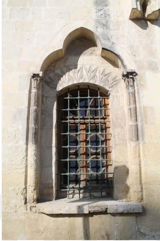
Fotoğraf- 86: Yeni Cami, güney cephe penceresi
