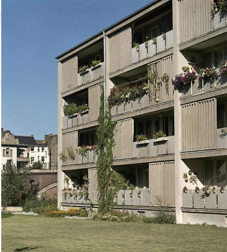
Şekil 5.28. Gotwald Binası Güneydoğu Cephesi, Hansaviertel
