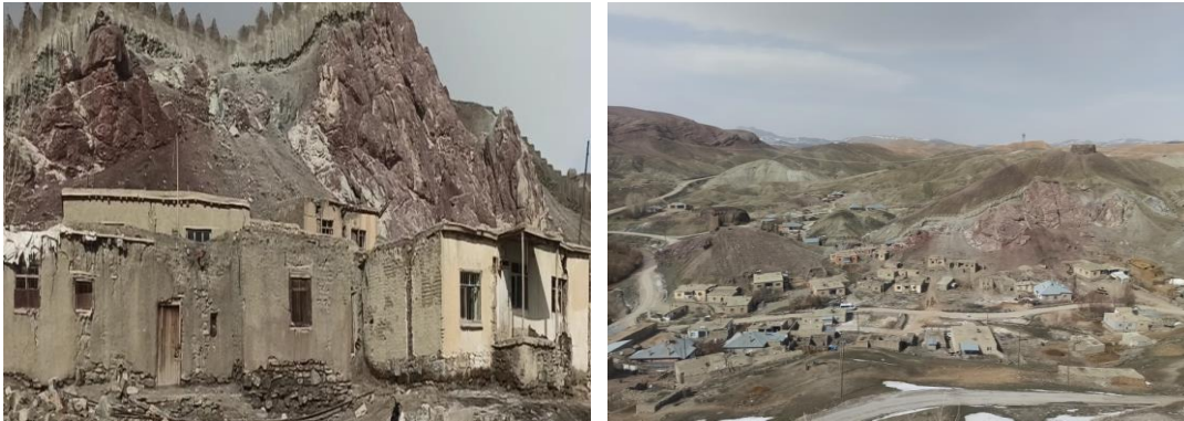
Şekil 5.6. Bölgeleme alanında bulunan geleneksel konutlar.
