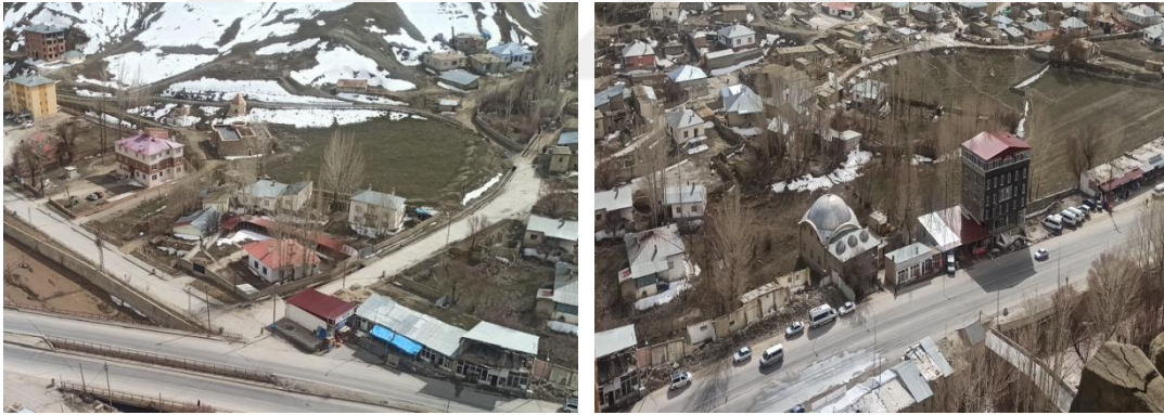
Şekil 5.33. Van-Hakkâri karayolu üzerinde bulunan yapılar.
