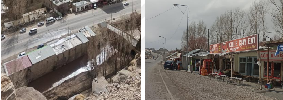
Şekil 5.28. Sel taşkın bölgesinde bulunan dükkânlar.
