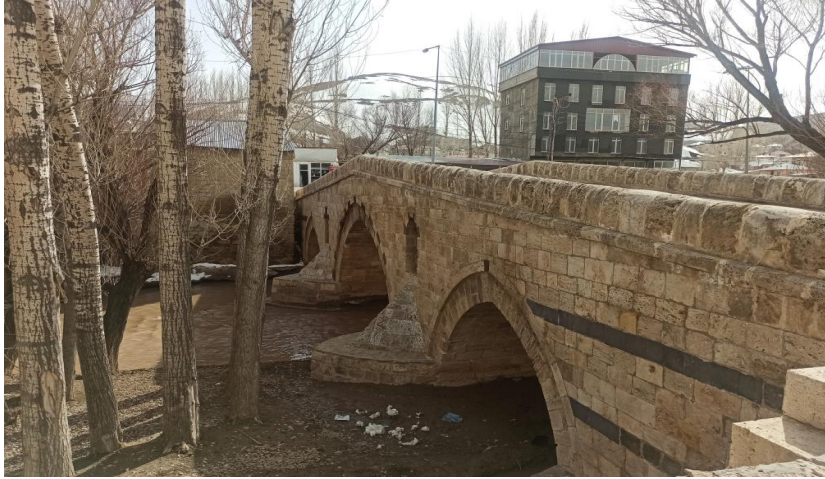
Şekil 4.7. Hoşap Evliya Bey Köprüsü.
