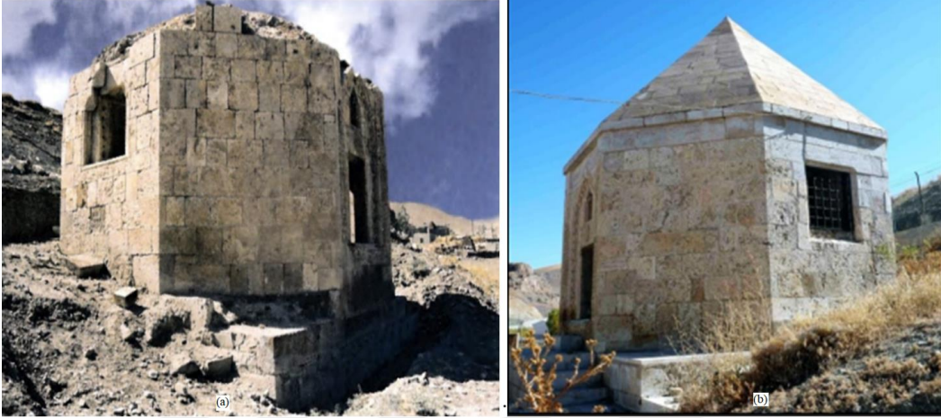
Şekil 4.3. a. Hoşap Süleyman Bey Kümbeti restorasyon öncesi (Top, 1998)., b. Restorasyon sonrası.
