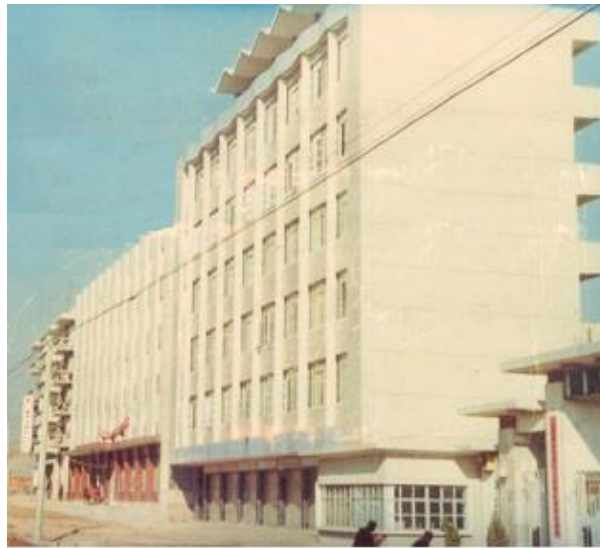
Şekil 2.15 : 6 Katlı ofis ve dükkân binası (Provis ve Van Deventer, 2014).
