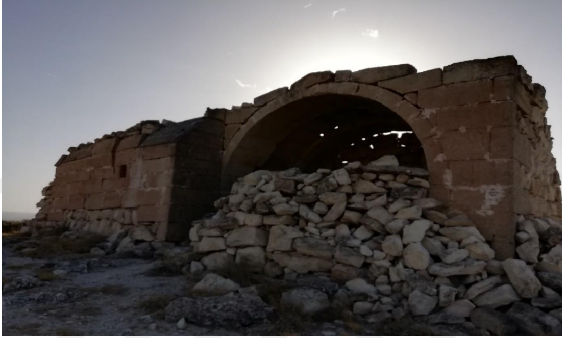
Resim 28: Nevşehir Ürgüp-Aktepe’de Yer Alan Halil Dede Türbesi Genel Görünüş (Şahsi arşiv)
