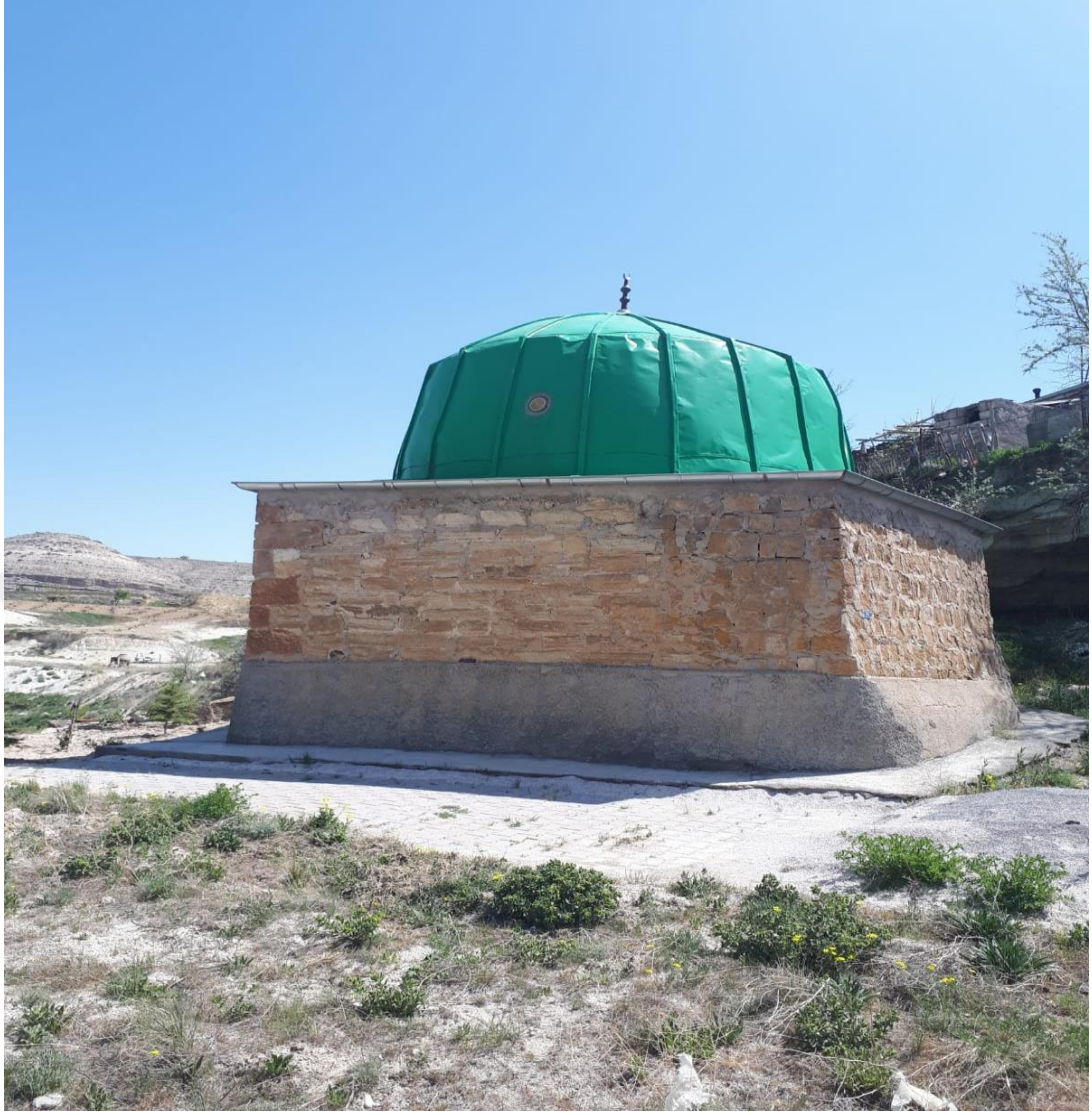
Resim 21: Sofu Dede Türbesi Genel Görünüş (Şahsi arşiv)
