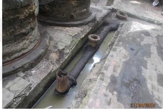
Şekil 4.34 : J Binası çalışmalar sırasında bulunan gaz boruları (Gürsoy Grup Restorasyon, 2015).
