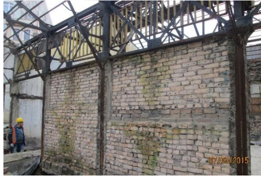
Şekil 4.9 : A Binası restorasyon uygulaması öncesi mevcut taşıyıcı konstrüksiyon (Gürsoy Grup Restorasyon, 2015).
