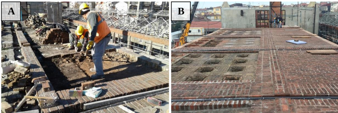
Şekil 4.56 : A ve B: R Binası üst örtü itinalı sökümü ve özgün yapım tekniği ve malzemelerle tamamlama uygulaması (Gürsoy Grup Restorasyon).
