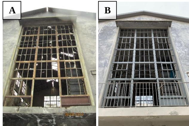
Şekil 4.63 : A ve B: S Binası özgün metal doğramalarda düşük basınçlı kumlama yöntemi ile yüzey temizliği uygulaması (Gürsoy Grup Restorasyon).
