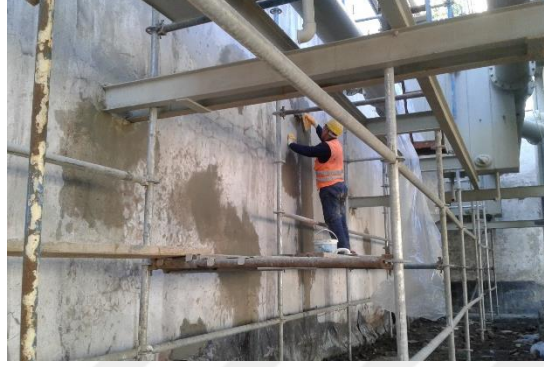
Şekil 4.44 : N Binası özgün sıvalı yüzeylerde sıva tamirâtı (Gürsoy Grup Restorasyon, 2016).
