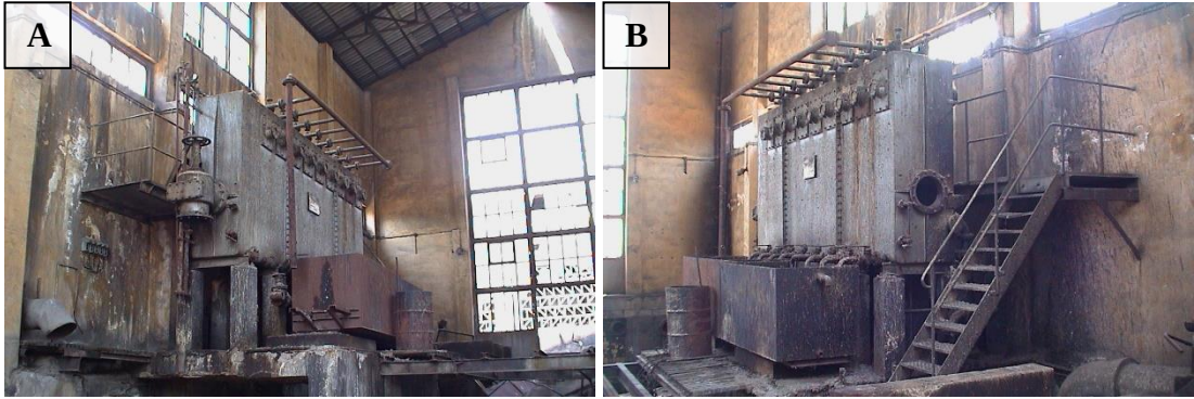
Şekil 4.59 : A ve B: S Binası katran ve amonyak ayırıcı temizleme cihazları (2001).
