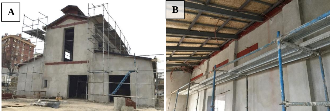
Şekil 4.33 : A ve B: J Binası pencere açıklıklarında güçlendirme uygulaması (Gürsoy Grup Restorasyon, 2015).
