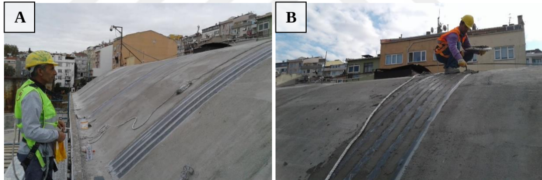
Şekil 4.18 : A ve B: F Binası betonarme tonoz çatısı karbon plakalar ile güçlendirme uygulaması (Gürsoy Grup Restorasyon, 2015).
