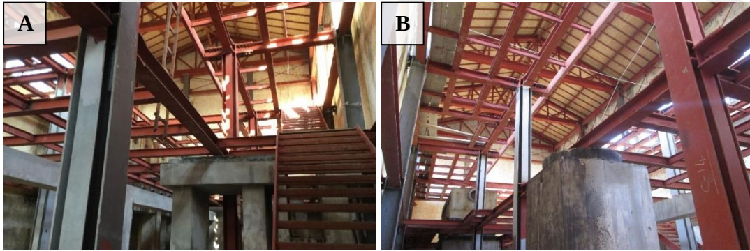
Şekil 4.43 : A ve B: N Binası oluşturulan yeni çelik konstrüksiyon ile güçlendirme uygulaması (Gürsoy Grup Restorasyon, 2016).
