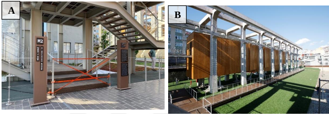
Şekil 4.74 : A: N Binası (2022) ve B: L Binası (Gürsoy Grup Restorasyon, 2021).
