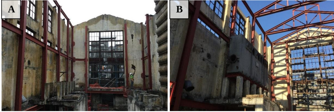
Şekil 4.60 : A ve B: S binası oluşturulan yeni çelik konstrüksiyon ile güçlendirme uygulaması (Gürsoy Grup Restorasyon).
