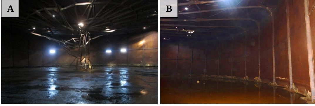
Şekil 4.21 : A ve B: Ga Gazometresi restorasyon uygulaması öncesi cidar içerisindeki özgün konstrüksiyon (Gürsoy Grup Restorasyon, 2014).
