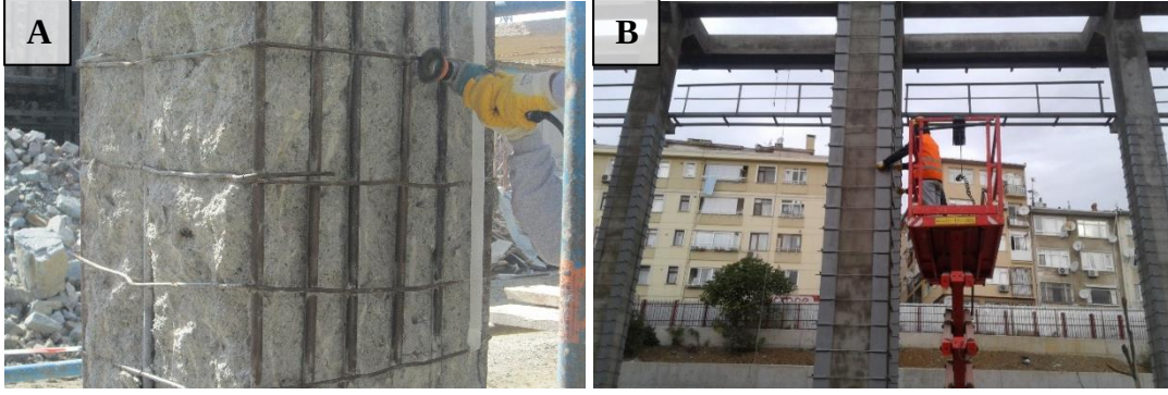
Şekil 4.38 : A: L Binası korozyon onarımı (Gürsoy Grup Restorasyon, 2015) B: L Binası çelik köşebent ve gergi çubukları ile güçlendirme uygulaması (Gürsoy Grup Restorasyon, 2015).
