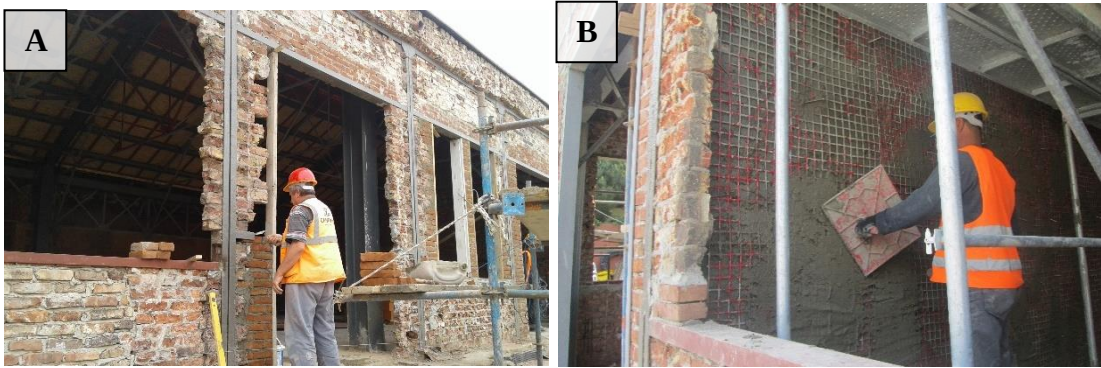
Şekil 4.10 : A ve B: A Binası özgün yapım tekniği ve malzemelerle tamamlama ve cam elyaf ile güçlendirme uygulamaları (Gürsoy Grup Restorasyon, 2015).
