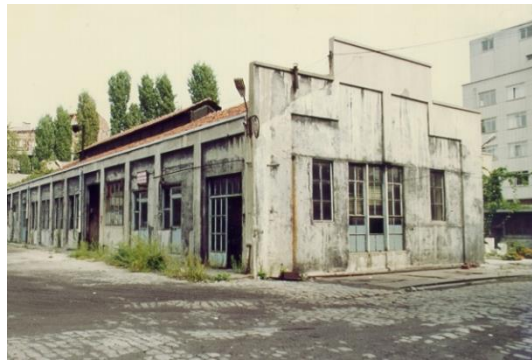
Şekil 4.7 : A Binası (İstanbul I No'lu KTVKK Arşivi, 1994 akt. Tanyeli ve diğ., 2000).
