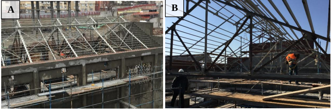
Şekil 4.50 : A ve B: P Binası çatı makasları güçlendirme uygulaması (Gürsoy Grup Restorasyon).
