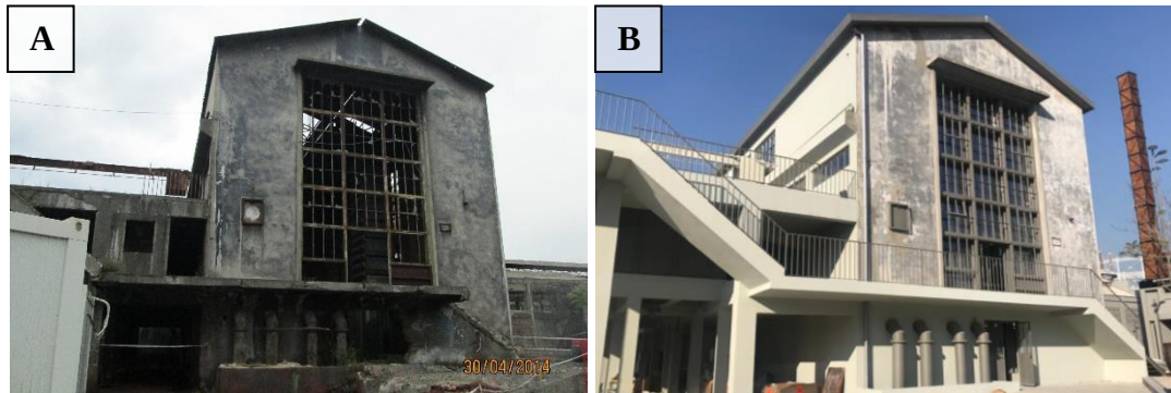
Şekil 4.61 : A: S Binası restorasyon uygulaması öncesi (Gürsoy Grup Restorasyon, 2014) B: S Binası restorasyon uygulaması sonrası (Gürsoy Grup Restorasyon, 2021).
