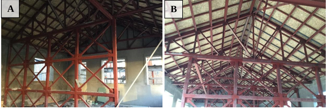
Şekil 4.14 : A ve B: C Binası oluşturulan yeni çelik konstrüksiyon ile güçlendirme uygulaması (Gürsoy Grup Restorasyon, 2015).
