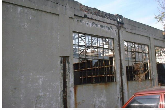
Şekil 4.66 : T Binası restorasyon uygulaması öncesi mevcut taşıyıcı konstrüksiyon (Gürsoy Grup Restorasyon, 2014).
