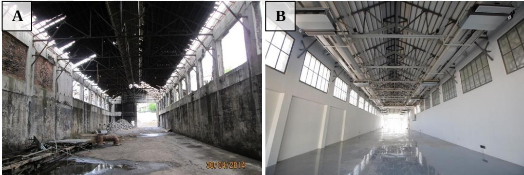
Şekil 4.51 : A: P Binası restorasyon uygulaması öncesi (Gürsoy Grup Restorasyon, 2014) B: P binası restorasyon uygulaması sonrası (Gürsoy Grup Restorasyon, 2021).
