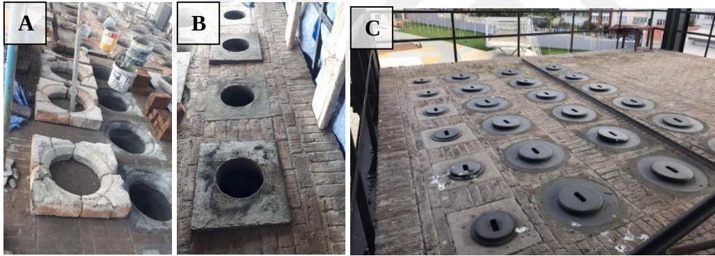
Şekil 4.40 : A, B ve C: M Binası üst örtü özgün yapım tekniği ve malzemelerle tamamlama uygulaması (Gürsoy Grup Restorasyon, 2020).
