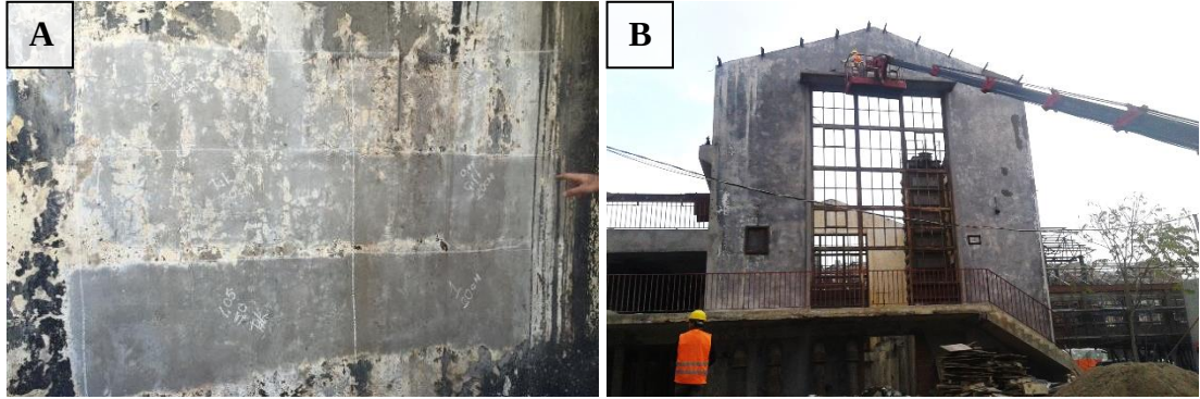
Şekil 4.62 : A ve B: S Binası özgün sıvalı yüzeylerde düşük basınçlı kumlama yöntemi ile yüzey temizliği uygulaması (Gürsoy Grup Restorasyon, 2015).
