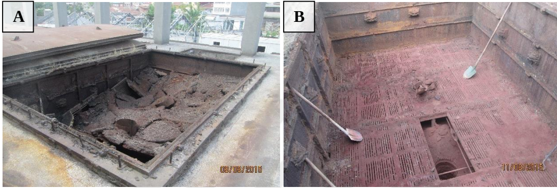
Şekil 4.64 : A ve B: S binası özgün süzgeçlerin hazne temizliği (Gürsoy Grup Restorasyon, 2015).
