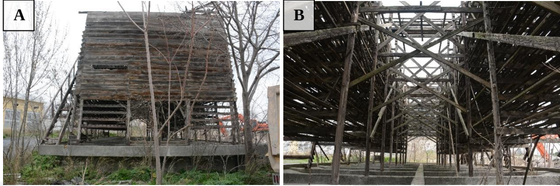
Şekil 4.47 : A ve B: Yedikule Gazhanesi su soğutma kulesi (2017).
