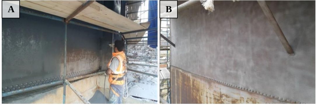
Şekil 4.23 : A ve B: Ga Gazometresi özgün dış cidar düşük basınçlı kumlama yöntemi ile yüzey temizliği uygulaması (Gürsoy Grup Restorasyon, 2016).
