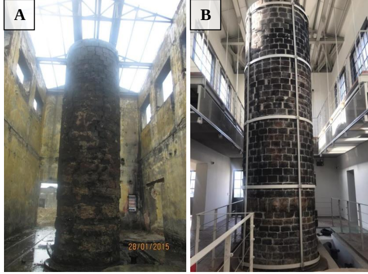
Şekil 4.35 : A: J Binası özgün bacalar (Gürsoy Grup Restorasyon, 2015) B: J Binası özgün bacaların çelik elemanlar ile güçlendirme uygulaması (Gürsoy Grup Restorasyon, 2020).
