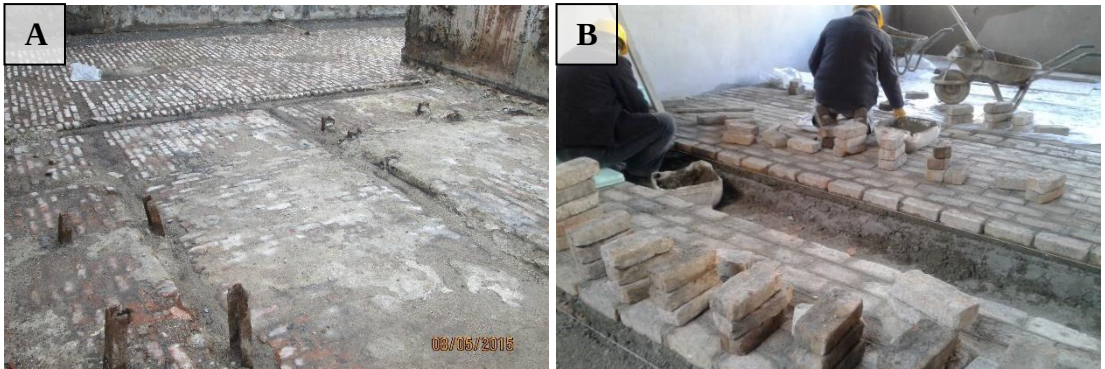
Şekil 4.15 : C Binası özgün tuğla döşemenin itinalı sökümü ve özgün yapım tekniği ve malzemelerle tamamlama uygulaması (Gürsoy Grup Restorasyon, 2015).
