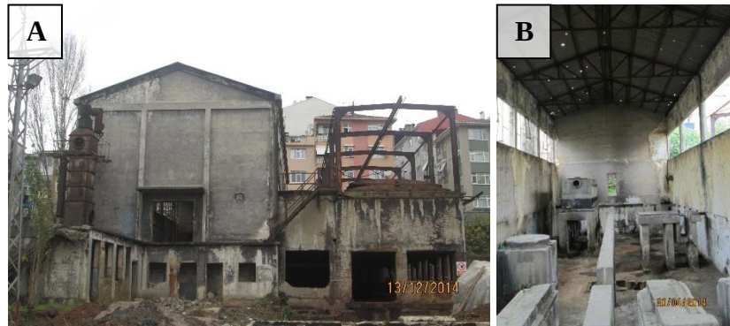
Şekil 4.42 : A ve B: N Binası restorasyon uygulaması öncesi (Gürsoy Grup Restorasyon, 2014).
