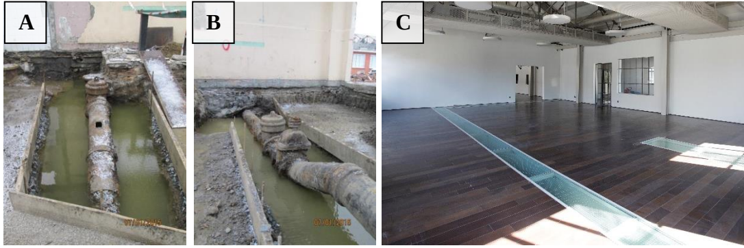
Şekil 4.11 : A ve B: A Binası çalışmalar sırasında bulunan gaz boruları (Gürsoy Grup Restorasyon, 2015) C: A Binası gaz borularının sergilenmesi amacıyla yapılan cam döşeme uygulaması (Gürsoy Grup Restorasyon, 2021).
