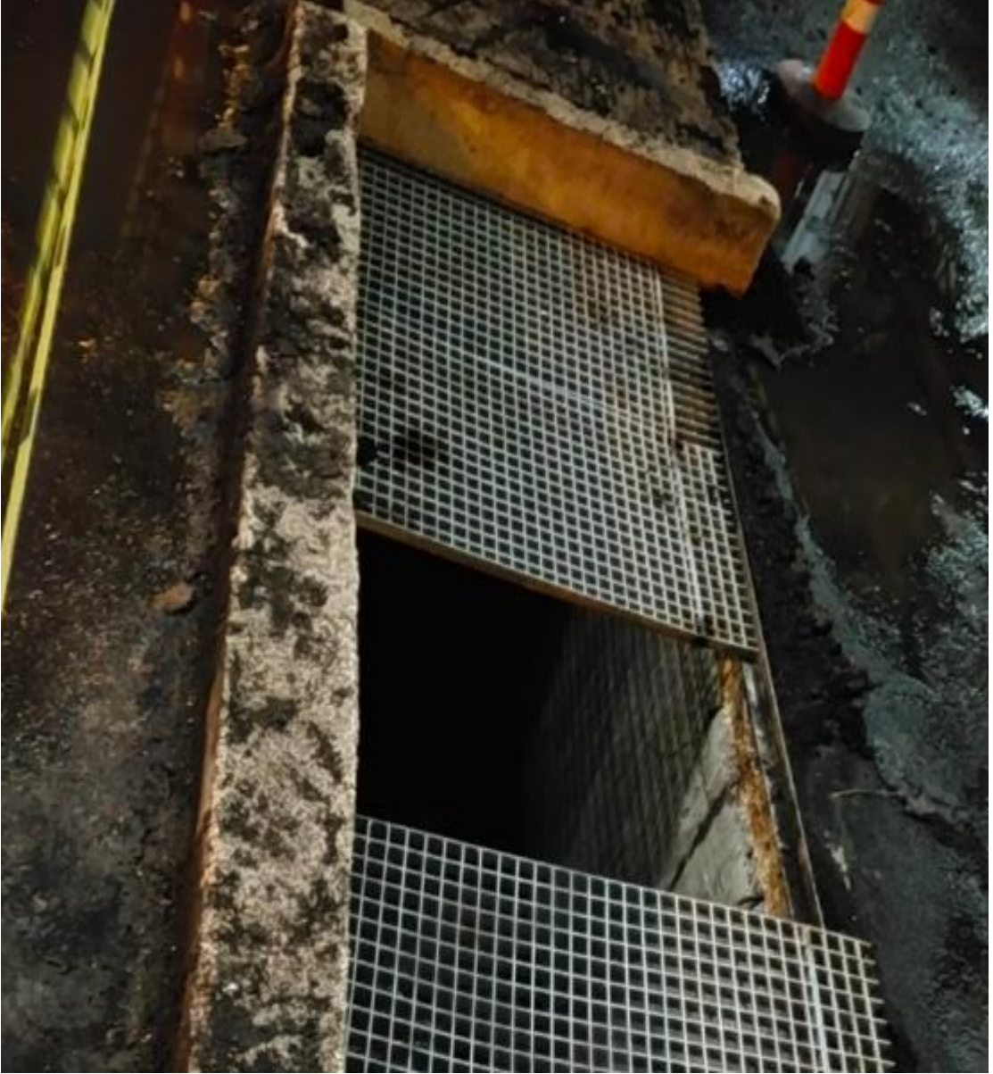
Şekil 3. 28. Açık Zeminlerin İşaretlenmesi
