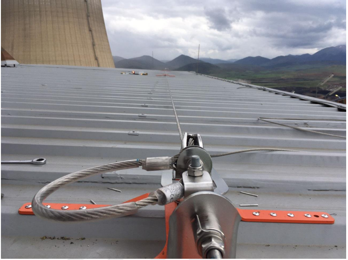
Şekil 3. 21. Yüksekte Çalışanlar İçin Yaşam Hattı
