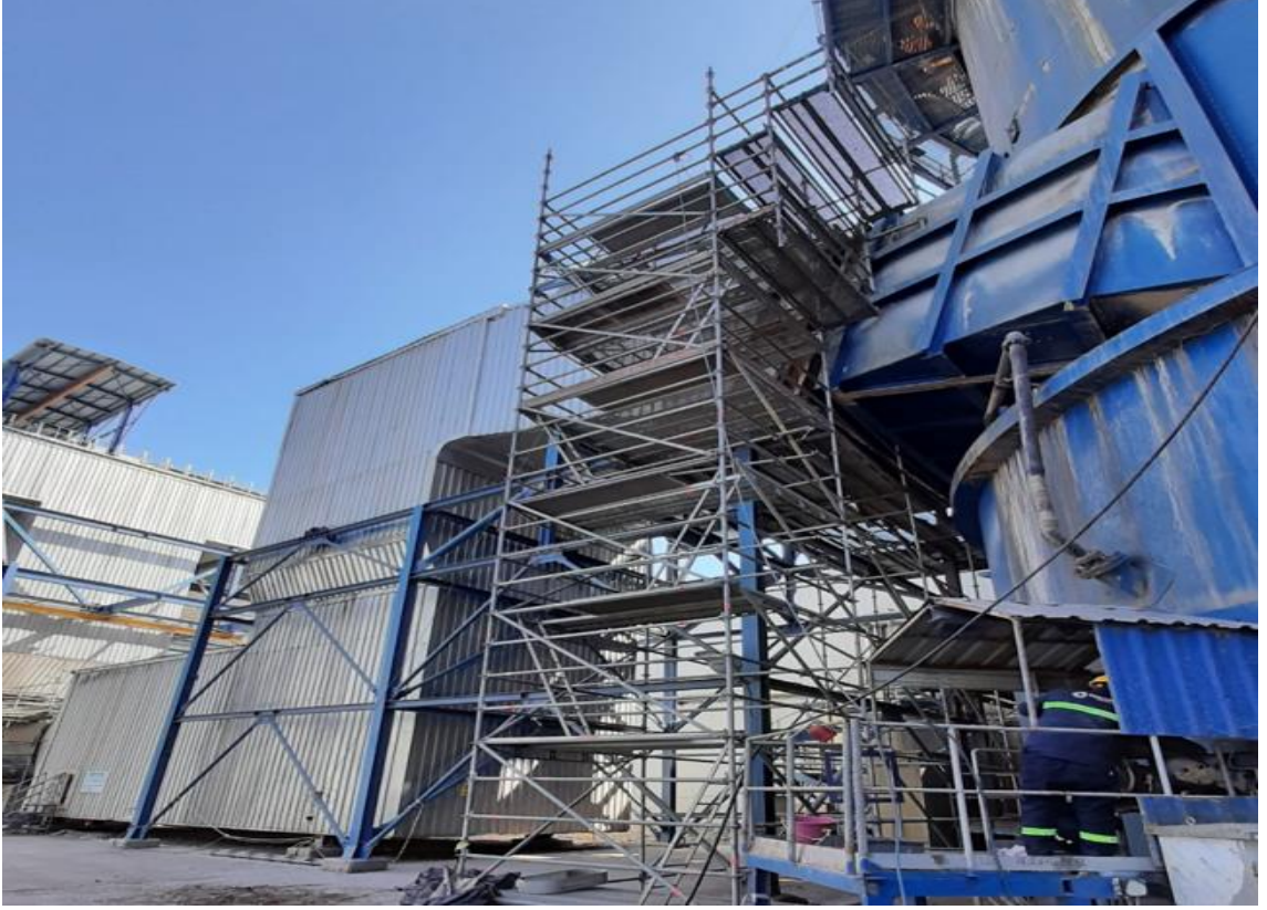
Şekil 3. 24. İskele Bağlantıları
