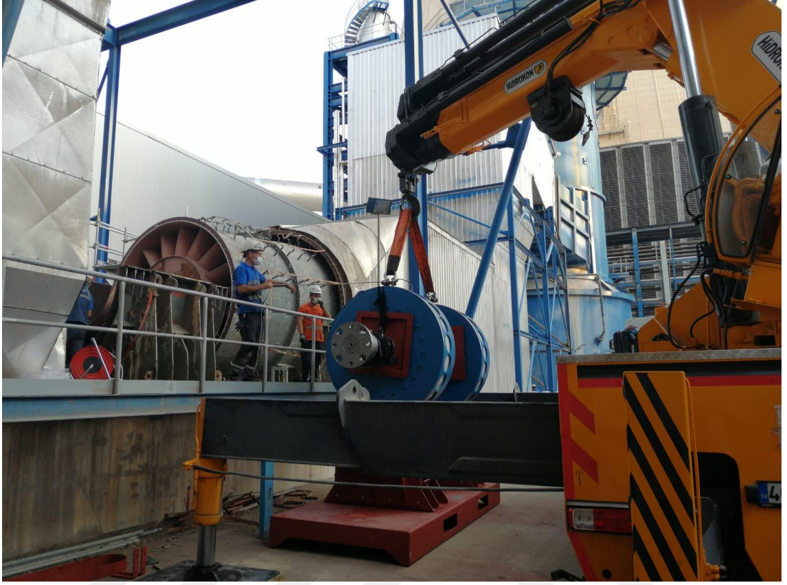
Şekil 3. 41. Vinçle Kaldırma Operasyonları
