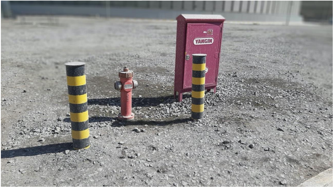
Şekil 3. 19. Hidrant Sistemi
