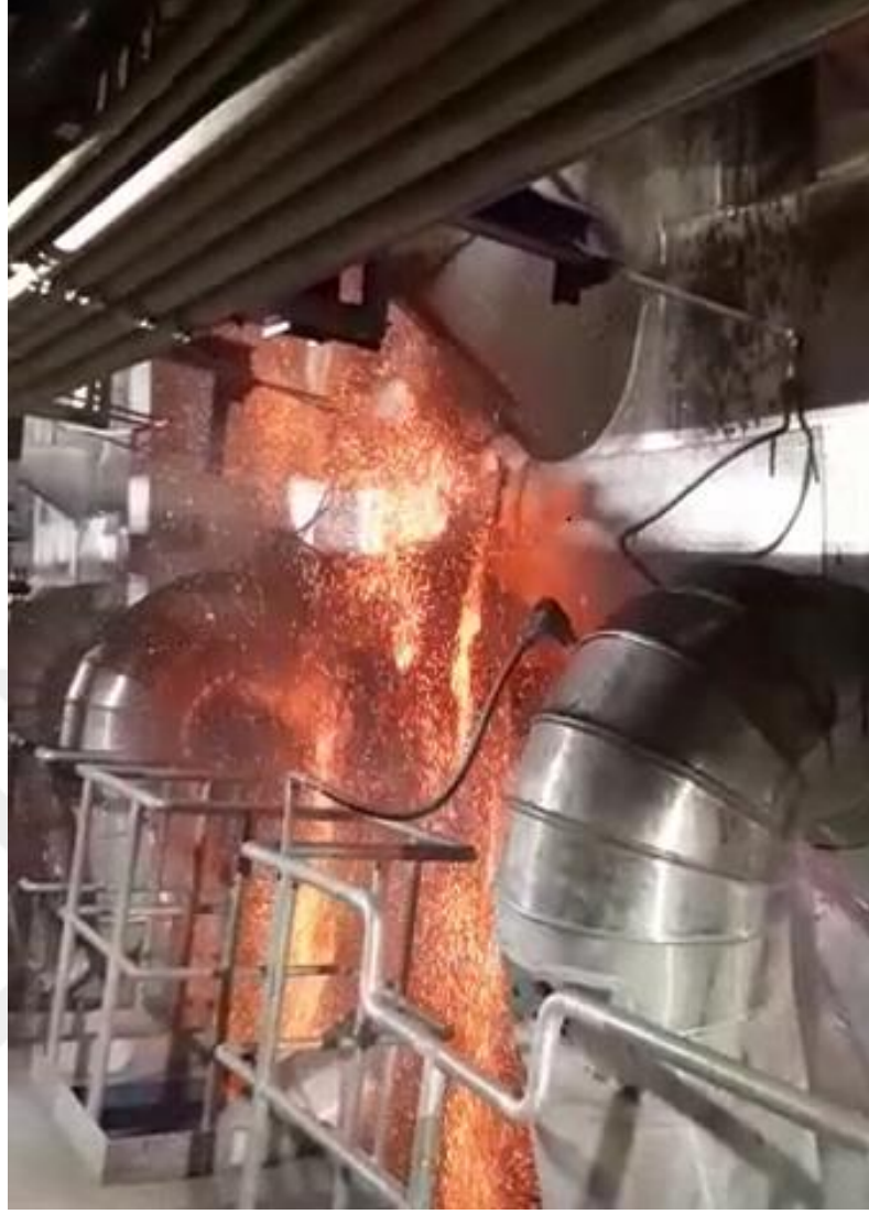
Şekil 3. 42. Kazana Kömür Besleme Hattında Kaçak
