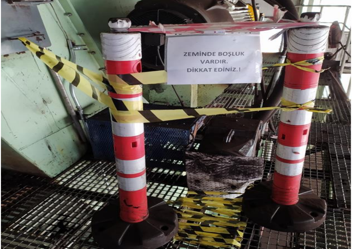
Şekil 3. 33. Zemin Boşlukları İşaretleme ve Uyarı Levhası
