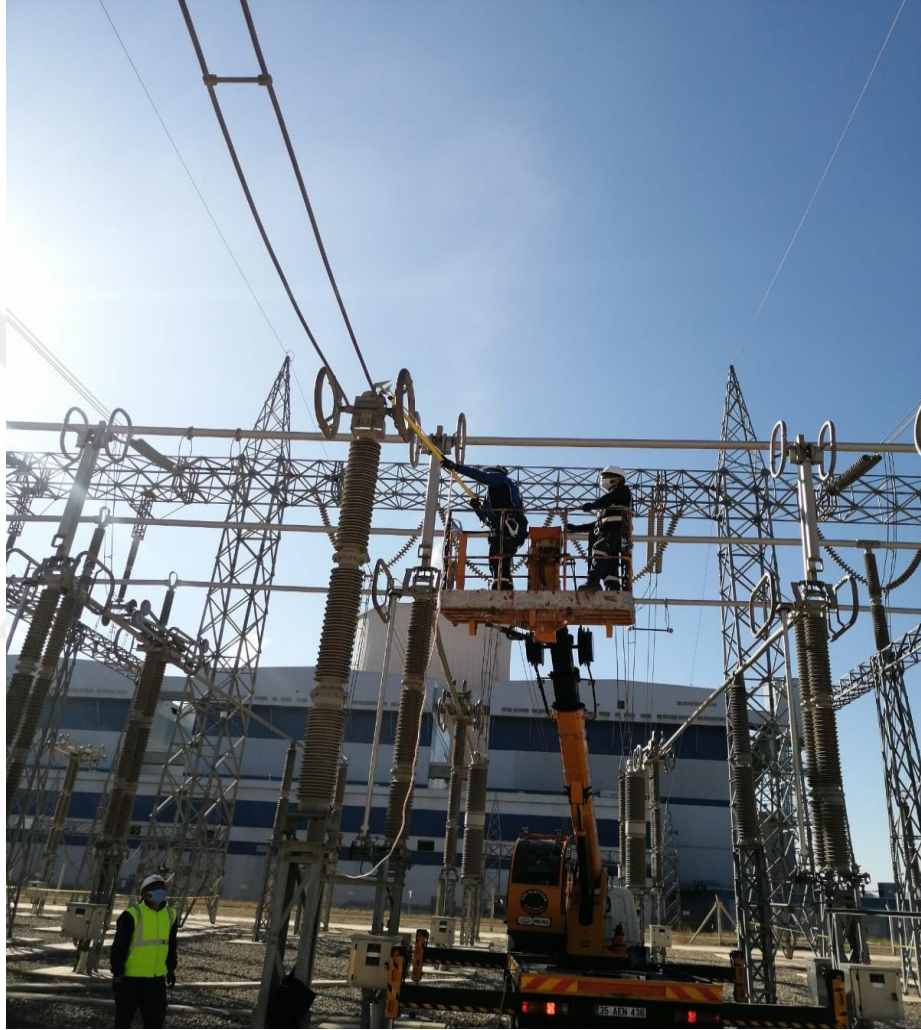
Şekil 3. 36. Yüksek Gerilim Hattında Bakım Çalışması
