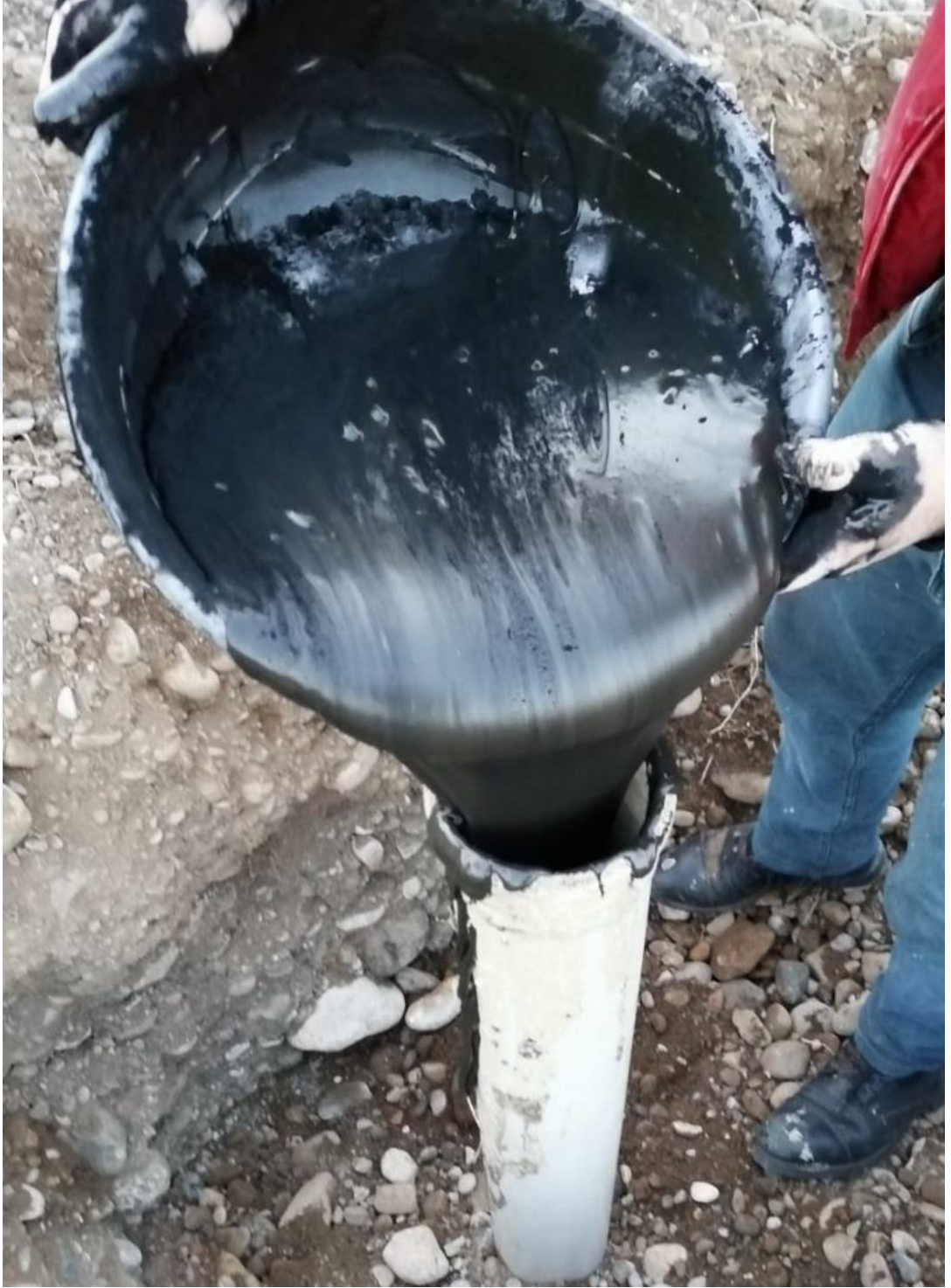
Şekil 4.7. Karbon siyahı direnç düşürücünün koyulması
