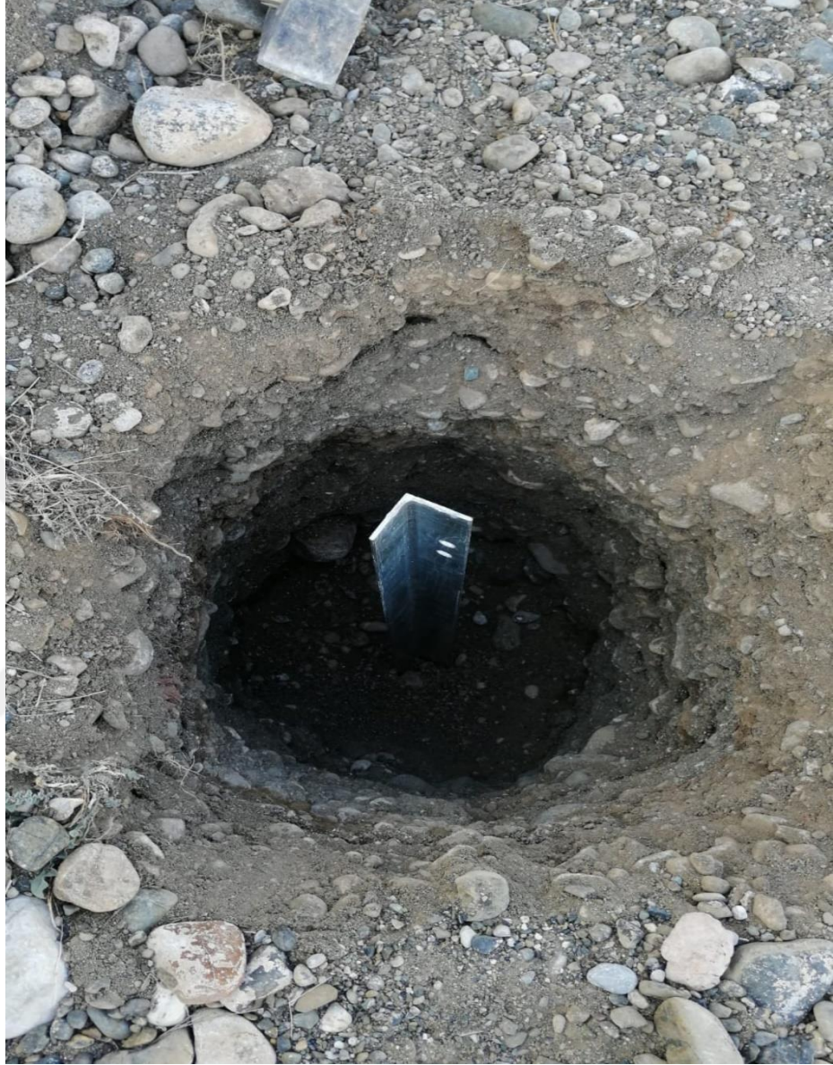
Őekil 4.4. Topraklayıcının topraęa yerleřtirilmesi
