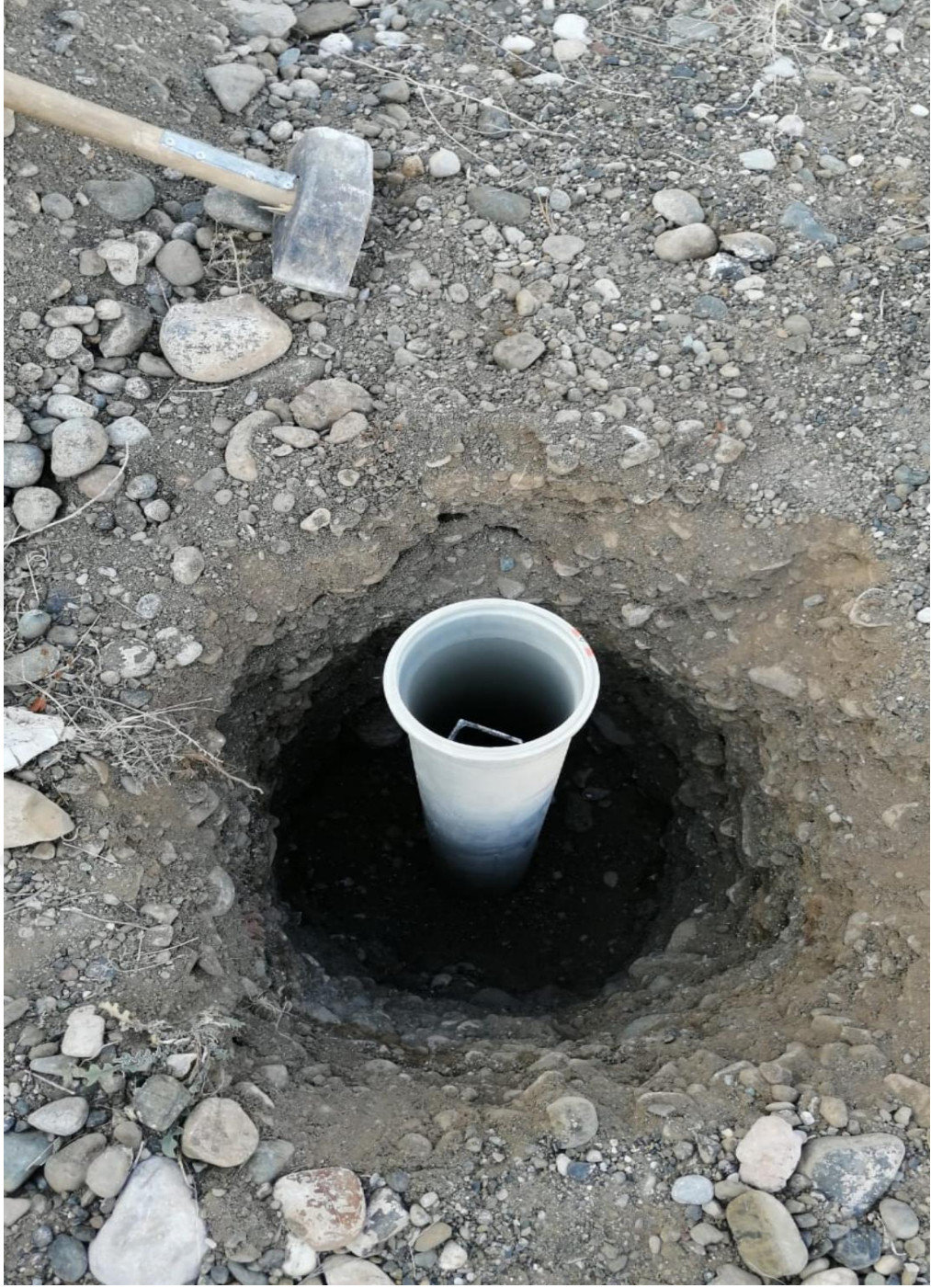
Şekil 4.5. Topraklayıcının etrafına direnç düşürücünün kalıbının yerleştirilmesi
