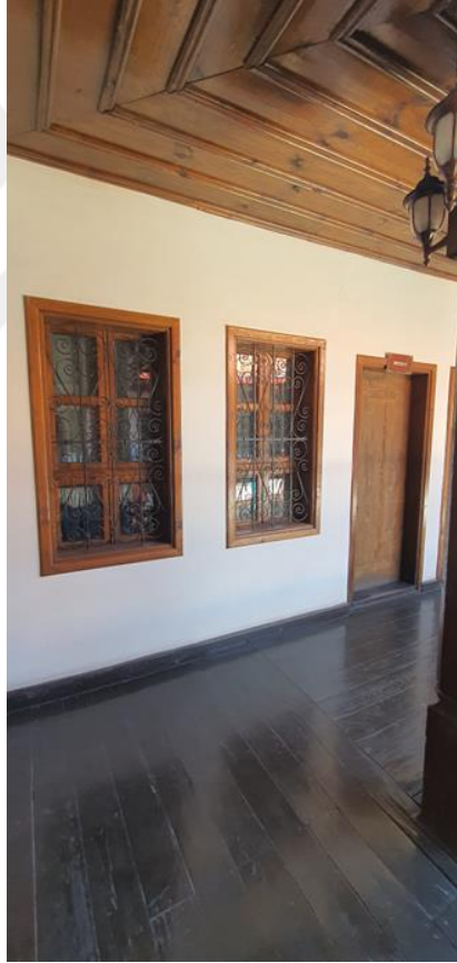
Fotoğraf 3.213: Çorapçı Hanı Üst kat odalarının kapı ve pencereleri
