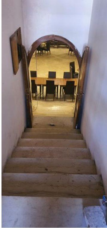
Fotoğraf 3.95: Subaşı Hanı Develik Bölümüne Avludan Geçiş Sağlayan Merdiven
