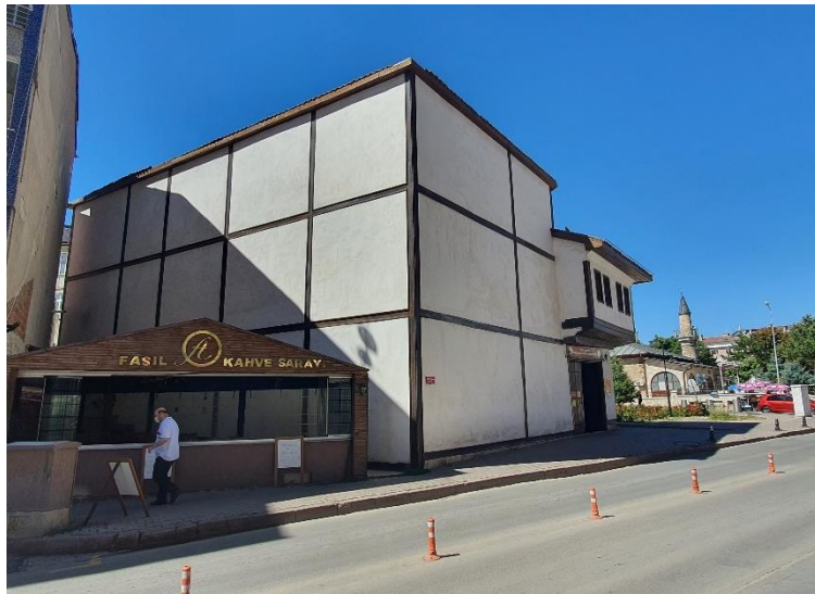
Fotoğraf 3.186: Çorapçı Hanı Doğu cephesi
