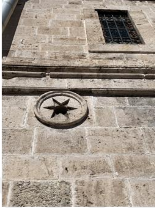
Fotoğraf 3.138: Taşhan Güney Cephesinde Yer Alan Yıldız Motifi
