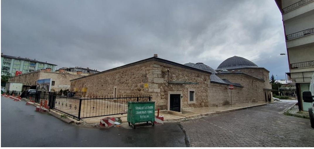
Fotoğraf 3. 33: Behram Paşa Hanı Hanın Arka Cephesinden Hamam ile İlişkisi
