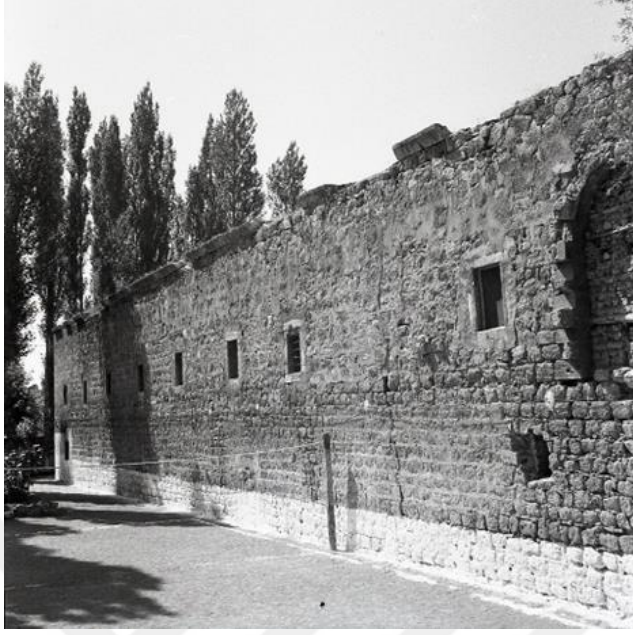
Fotoğraf 3. 4: Behram Paşa Hanı Kuzey Doğu Cephesi Beden Duvarı
