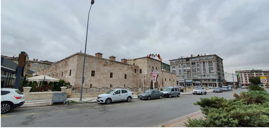
Fotoğraf 3. 21: Behram Paşa Hanı Güney Köşesi Ön ve Yan Cephesi
