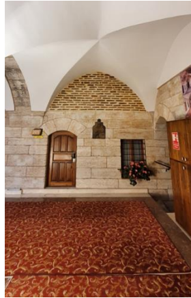
Fotoğraf 3. 61: Behram Paşa Hanı Oda Birimleri Kapı Ve Pencereleeri- Üst Örtü
