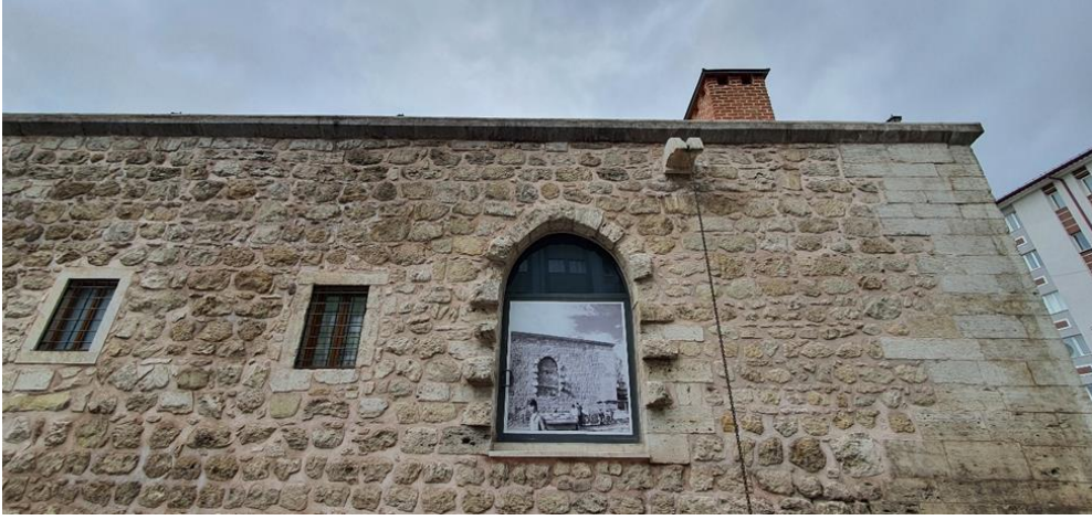
Fotoğraf 3. 30: Behram Paşa Hanı Kuzey Doğu Cephesindeki Kemer Açıklığı
