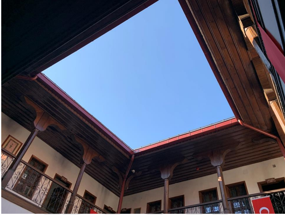
Fotoğraf 3. 199: Çorapçı Hamı Çatı detayı
