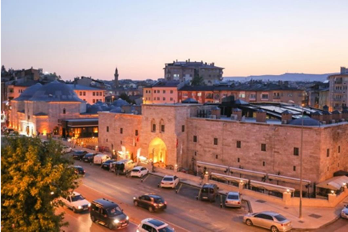
Fotoğraf 3.19: Behram Paşa Hanı Restorasyon Sonrası Han ve Hamam
