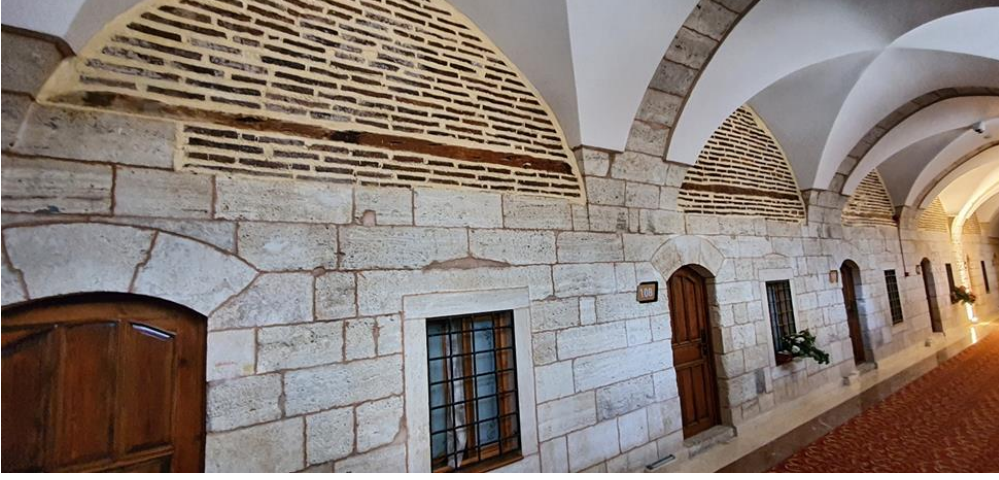
Fotoğraf 3.59: Behram Paşa Hanı Avluya Bakan İç Duvarlar
