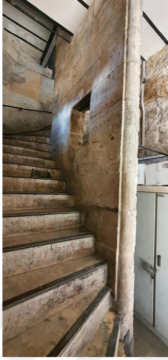
Fotoğraf 3.160: Taşhan Batı Cephesi Merdiven Çıkışı
