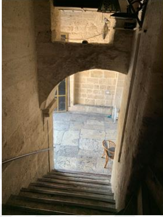
Fotoğraf 3.156: Taşhan Doğu Cephesinde Yer Alan Merdiven
