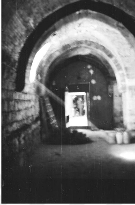
Fotoğraf 3. 14: Behram Paşa Hanı Develik Bölümü Tonozları
