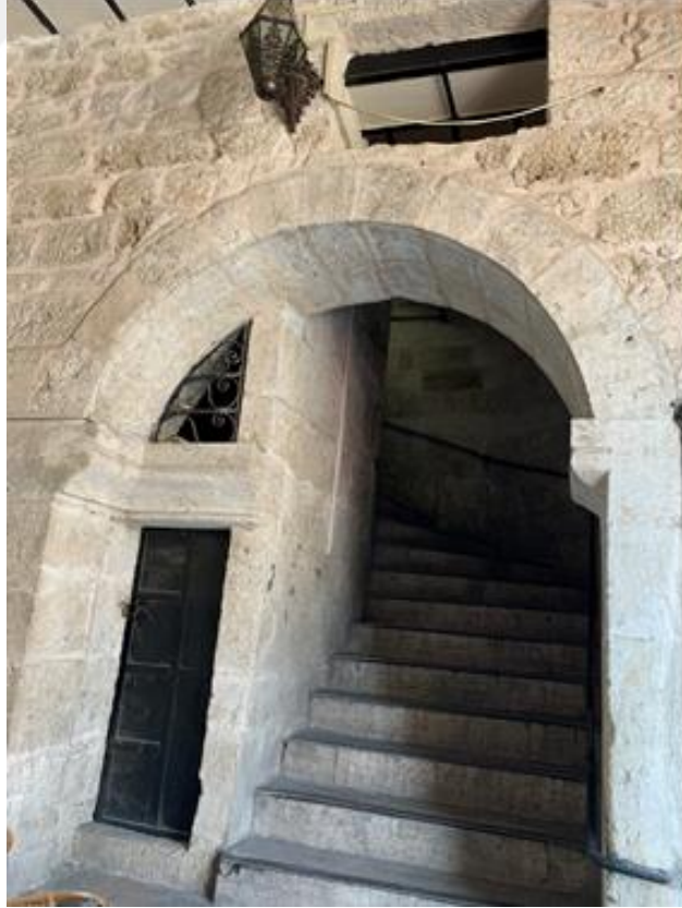
Fotoğraf 3.155: Taşhan Doğu Cephesinde Yer Alan Merdiven
