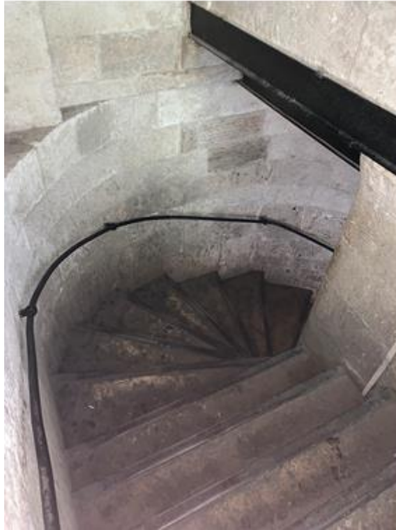
Fotoğraf 3.157: Taşhan Doğu Cephesinde Yer Alan Merdivenin Çıkışı
