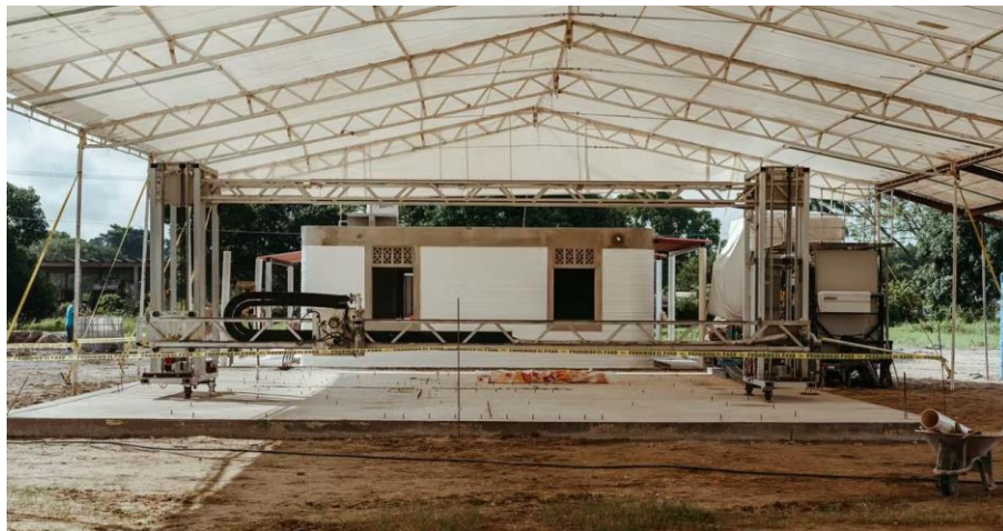
Şekil 4.16 Konutların proje alanında 3B yazıcı ile üretim süreci (ICON, 2019)
