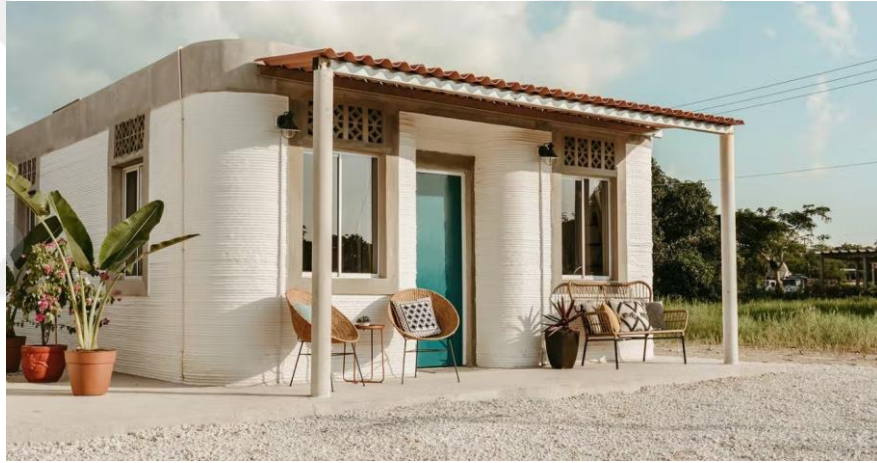
Şekil 4.15 Tabasco, Meksika’da 3B yazıcı ile üretilen konutlar (ICON, 2019)
