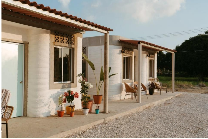
Şekil 4.14 Tabasco, Meksika’da 3B yazıcı ile üretilen konutlar (ICON, 2019)
