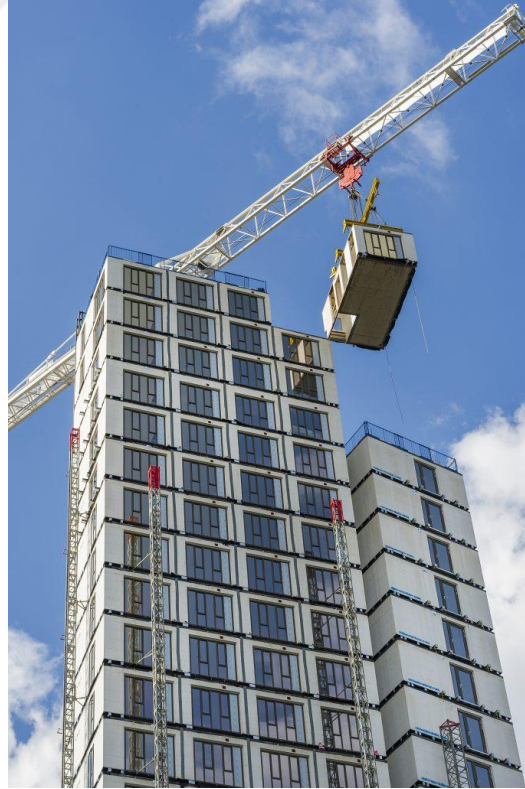
Şekil 4.8 Mapleton Crescent Apartmanı modüler birimlerin birleştirilmesi (Vision Modular, 2017)
