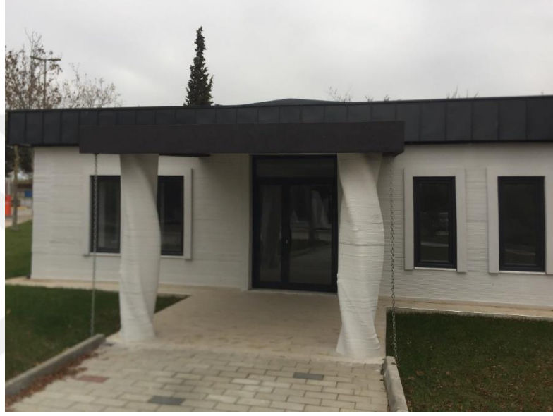
Şekil 5.2 İSTON firmasının üç boyutlu yazıcı ile ürettiği konut
