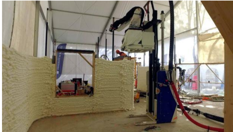
Şekil 4.12 3B yazıcı ile duvar örülmesi, Ynhova, Nantes (Saunders, 2018)
