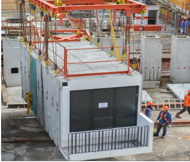
řekil 4.2 Modüler birimin tařınma süreci (Dragages, 2016)
