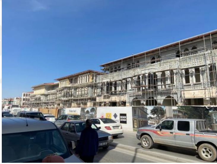
Şekil 46 Mevlana Caddesi-Cephe Yenileme (Orjinal, 2022)
