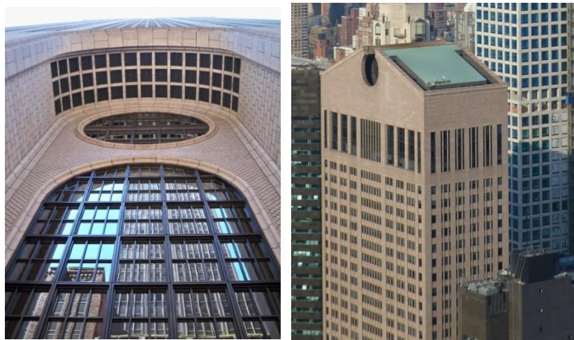
Şekil 3.20 : AT&T bina cephesi, New York /1984 (Wikiimg, 2022 ).
