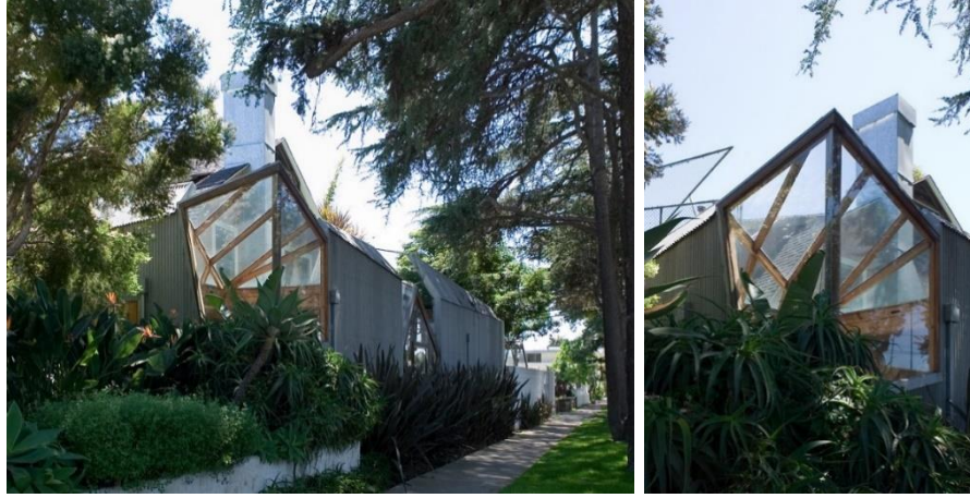
Şekil 4.3 : Çerçevesiz köşe pencereler, Gehry Evi/1978 (Archdaily, 2010 ).
