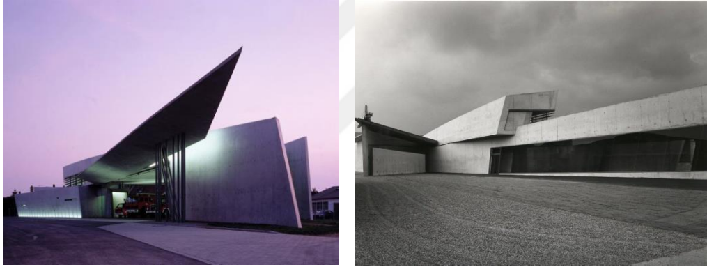
Şekil 4.15 : Solda cephe, sağda, ekiplerin asfalttaki antrenman hareketleri, Zaha Hadid, Vitra İtfaiye İstasyonu/1993 (Arkitektuel, 2022 ).
