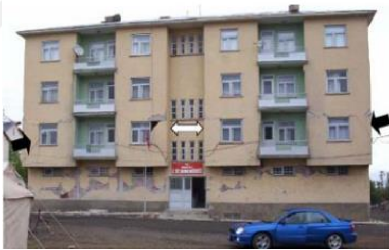
Şekil 3.11. Ağır çıkma bulunan bir yapı (Özmen, 2005).
