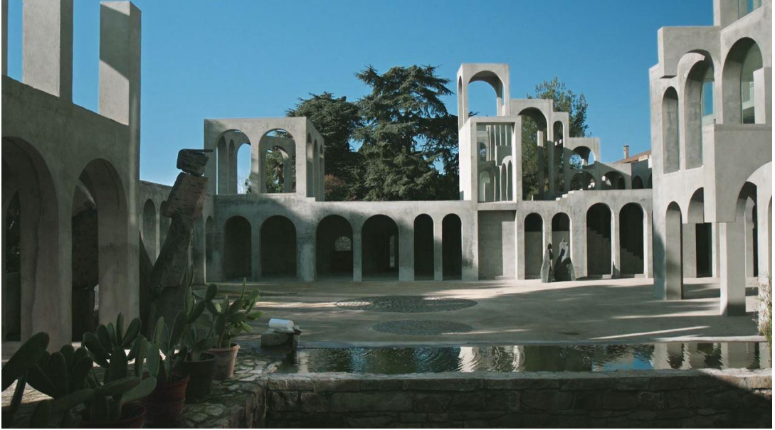
Şekil 4.13 : Xavier Corberó, The Labyrinth Home (Labirent Ev), Dış Mekân, Barselona
