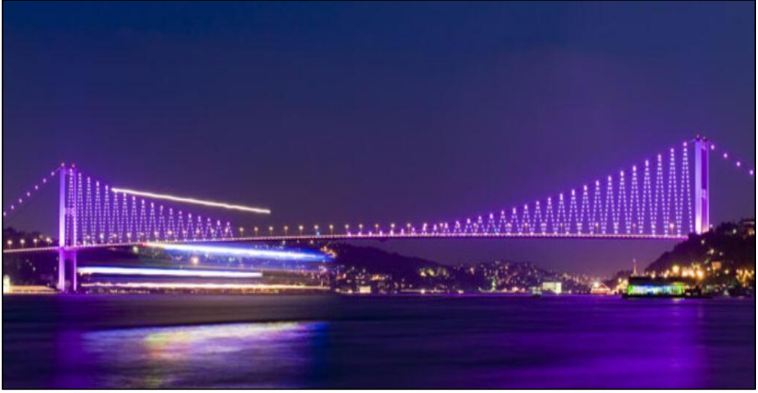
Şekil 2.16. İstanbul Boğaz Köprüsü
