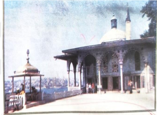
Bağdat Köşkü (Topkapı Sarayı), (Şenünver,2001,60).
