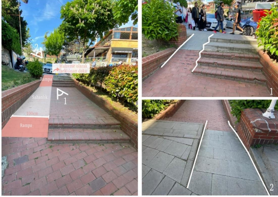
Şekil 3. 34 Rota üzerindeki 2 numaralı rampa (saha çalışmaları 2021,2022)
