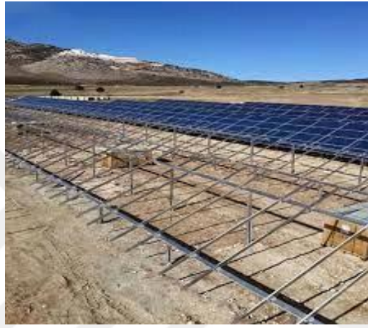
Şekil 3.5. Taşıyıcı sistem ve panel kurulumu
