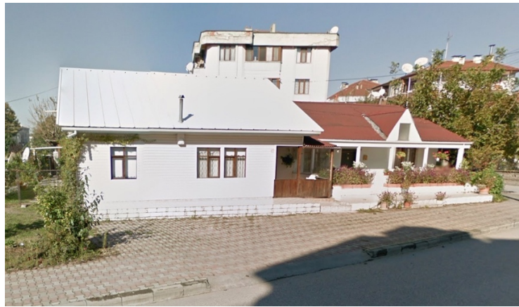
Şekil 3. 15: Deprem sonrası depremzedelerin Mansut Bayram Caddesi üzerindeki arsalarına inşa ettikleri geçici konutların kalıcı haline gelmesi örneği.
