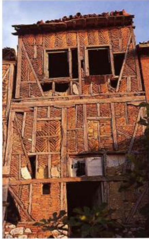
Şekil 2.3. Tuğla yığma bina örneği (Arun, 2005)
