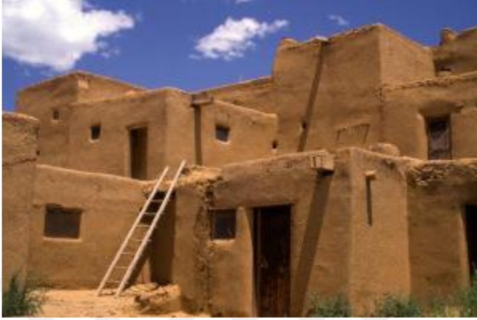
Şekil 2.2. Kerpiçten yapılmış bina (Çavuş vd., 2015)
