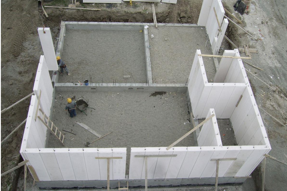
Şekil 2.6. Donatılı panel sistemli yığma bina örneği (Ytong, 2019)
