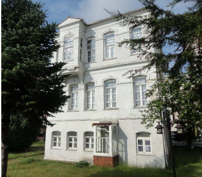
Şekil 4.1. Piyale Paşa Konağı kuzey cephe görünümü
