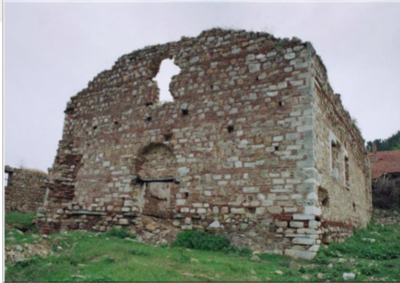
Şekil 4.7. Aya Yani Kilisesi Güneybatı'dan Genel Görünümü
