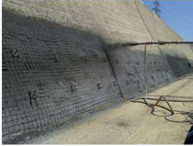
Şekil 3.2 Zemin çivili kazı yöntemi
