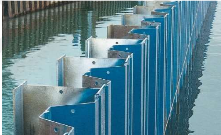
Şekil 3.6 Palplanş duvara bir örnek
