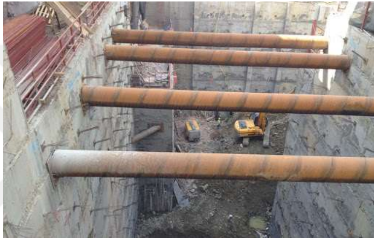
řekil 3.1 elik boru destekli kazı yntemi
