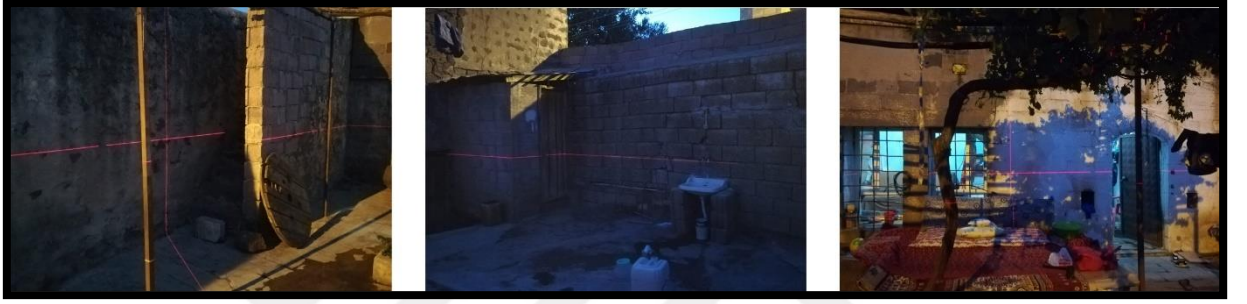
Şekil 4.1. Lazer Distomatla Sıfır Hattı Oluşturma
