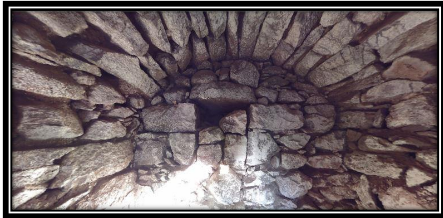
Şekil 5.59. Z13 Mahali Tonoz Üst Örtüsü
