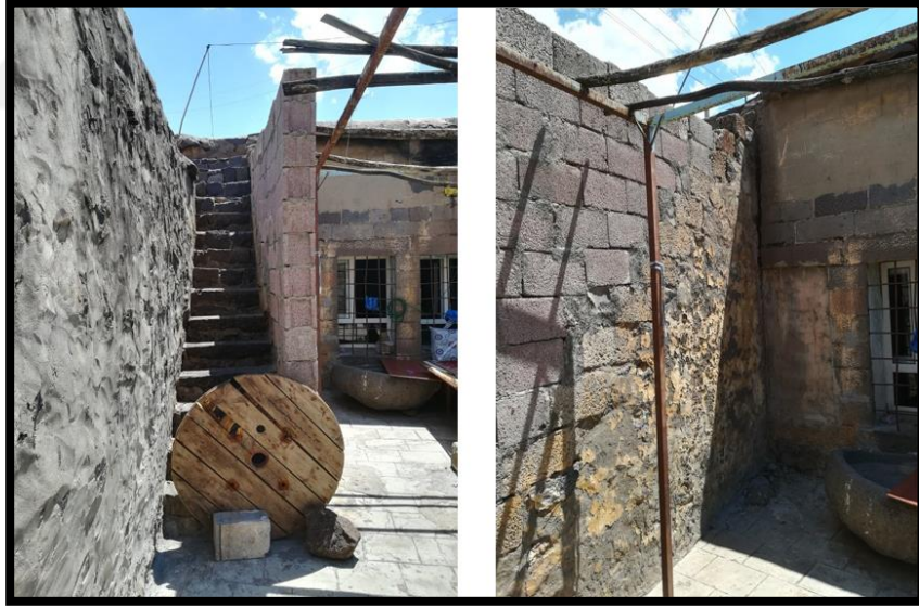
Şekil 3.99. Güney Cephede Çatıya Çıkan Kagir Merdiven
