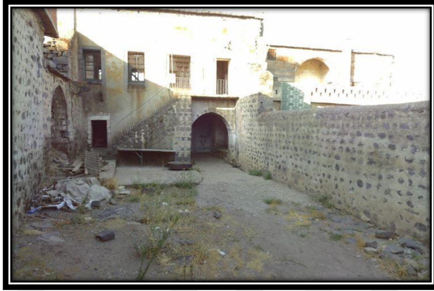
Şekil 5.81. Z2 Avlu Güney Cephesi
