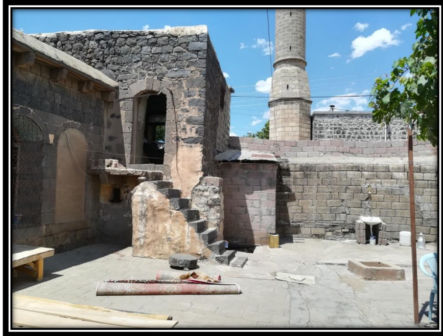
Şekil 3.77. Avlu, N1 Köşk Odası ve Wc Mahali (Solda Briketli)
