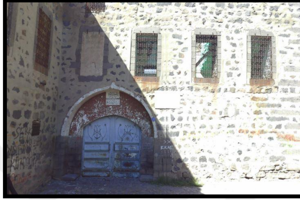
Şekil 5.75. Z1 Giriş Kapısı
