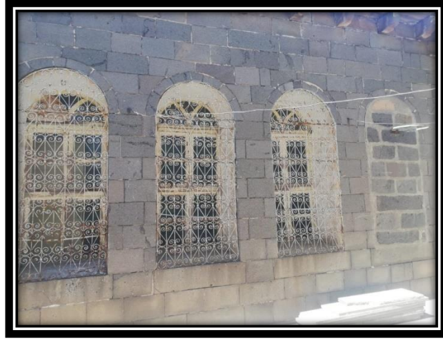
Şekil 3.146. Avlunun Batı Cephesindeki Kapatılan Pencere
