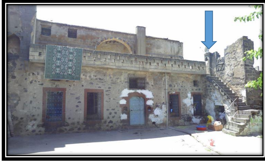
Şekil 5.84. Z3 Avlu Güney Cephesi
