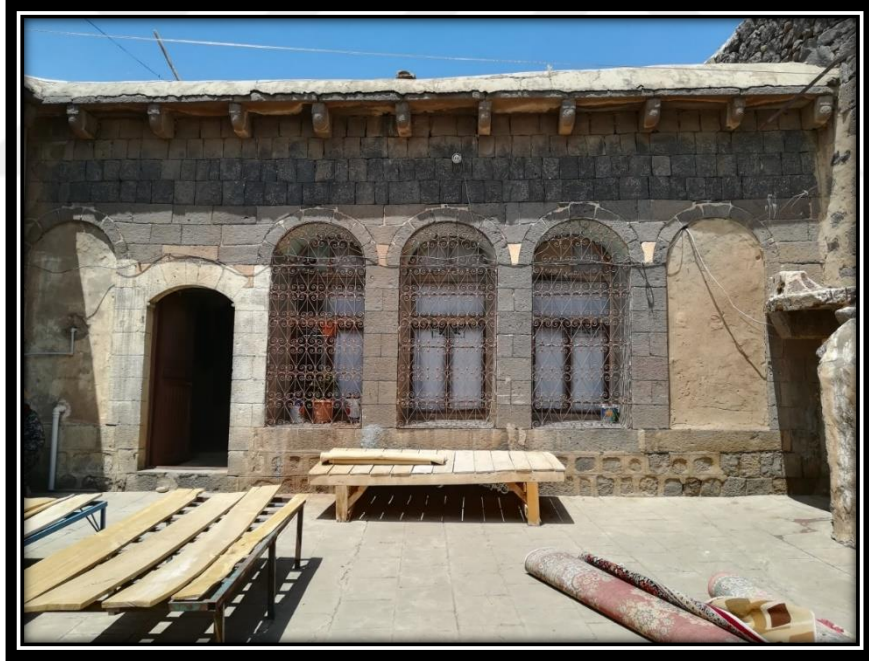
Şekil 3.110. Avlunun Batı Cephesinde Kapatılan Pencere Boşlukları
