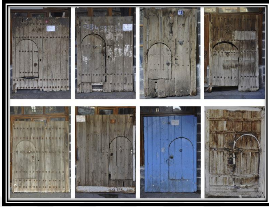
Şekil 5.77. Sokak kapıları “Kuzulu Kapı” (yıkılan evlerin kapıları). (Dalkılıç ve Nabikoğlu, 2019)
