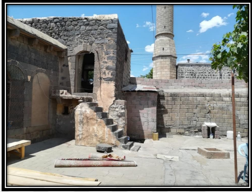
Şekil 3.111. Avlunun Kuzey Cephesinde Briket Malzeme Kullanımı
