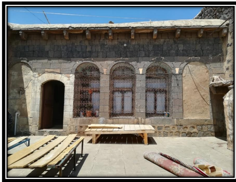
Şekil 3.101. Avlu Batı Cephesi
