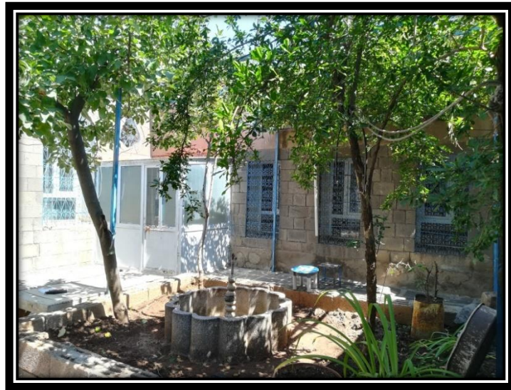
Şekil 3.68. Avlu Batı Cephesi
