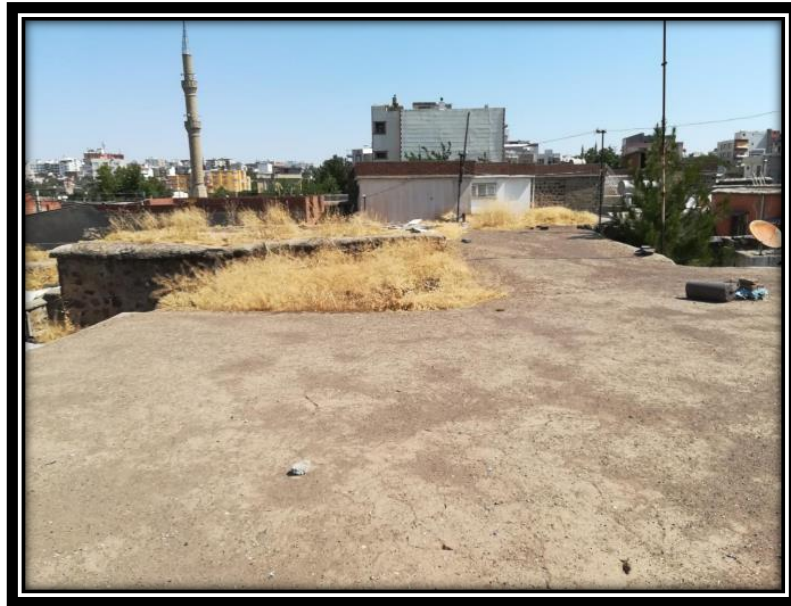
Şekil 3.62. Toprak Çatı (Dam)
