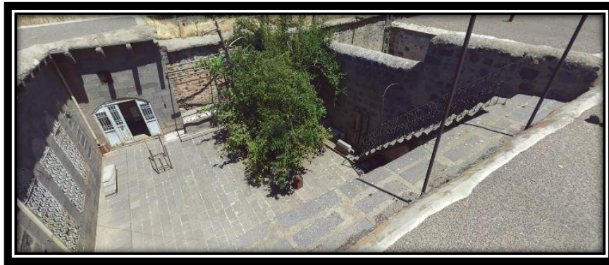
Şekil 3.141. Sonradan Genişletilen Çatı Saçağı
