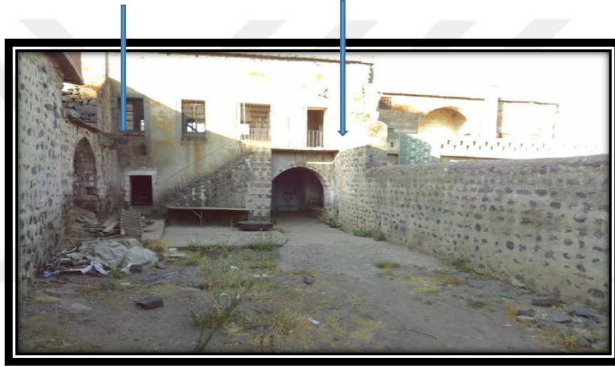
Şekil 5.110. Z2 Avlu Güney Cephesi
