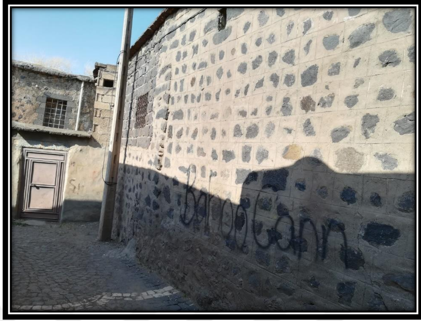
Şekil 3.59. Sokak Batı Cephesi
