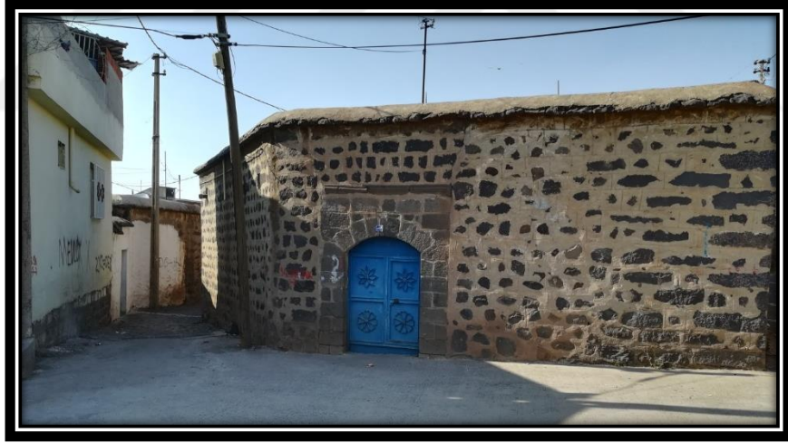
Şekil 3.58. Sokak Güney Cephesi
