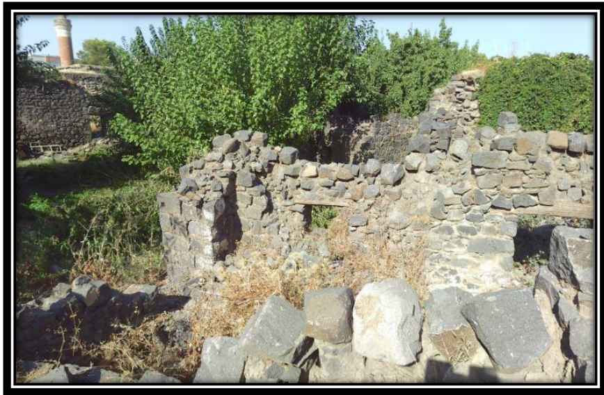
Şekil 5.73. Tamamen Yıkılmış Yapı Örneği
