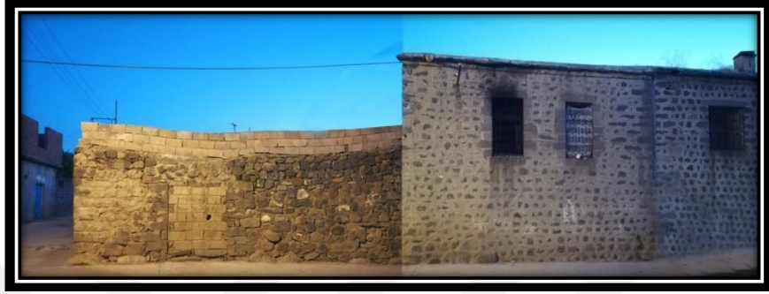
Şekil 3.105. Sokak Kuzey Cephesi
