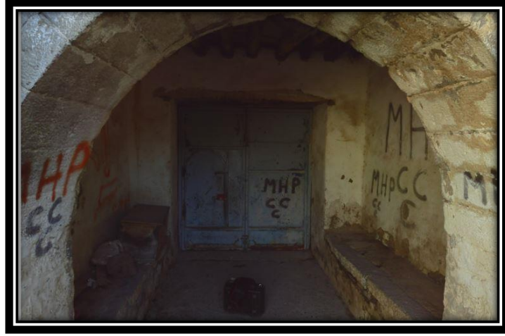
Şekil 5.65. Z1 Giriş Holünde Sprey Boya Örneği
