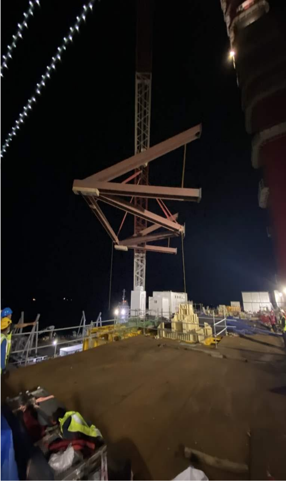
Şekil 3.135. Kılavuz Çerçeve Montajı
