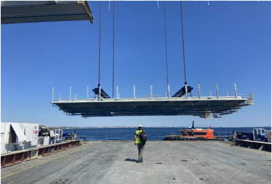
Şekil 3.157. Kaldırma Kirişlerinin Çelik Tabliye Bloğuna Montajı
