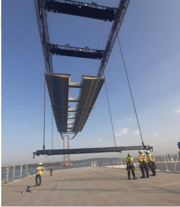
Şekil 3.159. Kaldırma Kirişlerinin Çelik Tabliye Bloğuna Montajı
