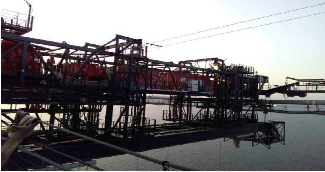
Şekil 3.152. Portal Vinç Montajı
