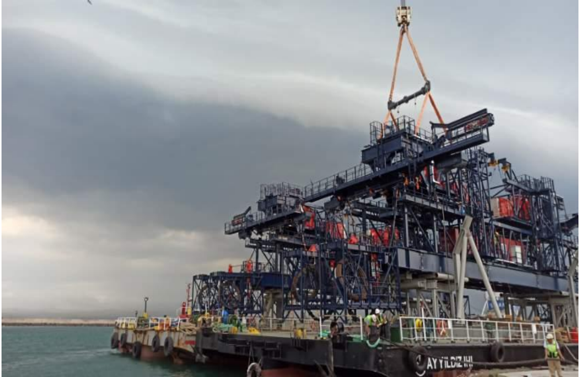
Şekil 3.121. Portal Vinç İmalat Alanı
