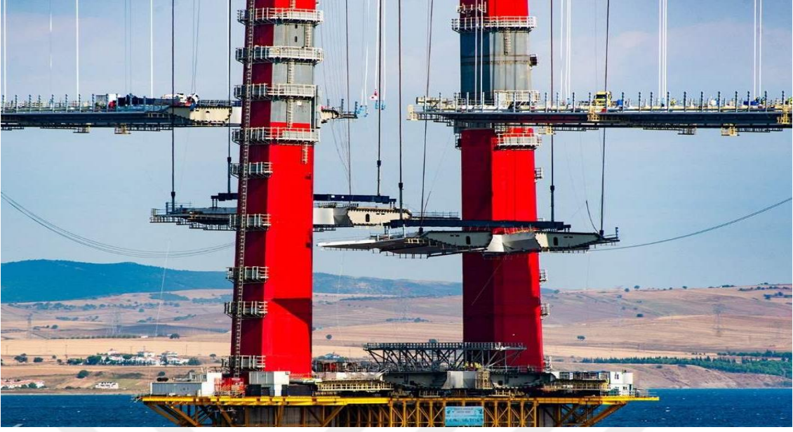
Şekil 3.166. Çelik Tabliye Bloklarının Kaldırılması
