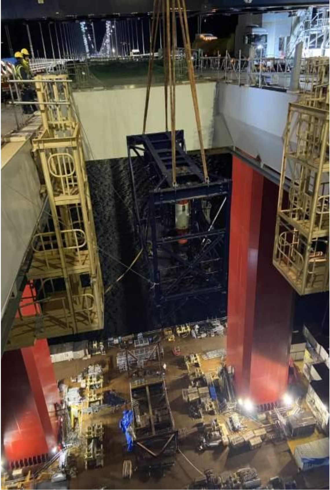
Şekil 3.172. Orta Açıklıktaki Portal Vinçlerin Demontajı
