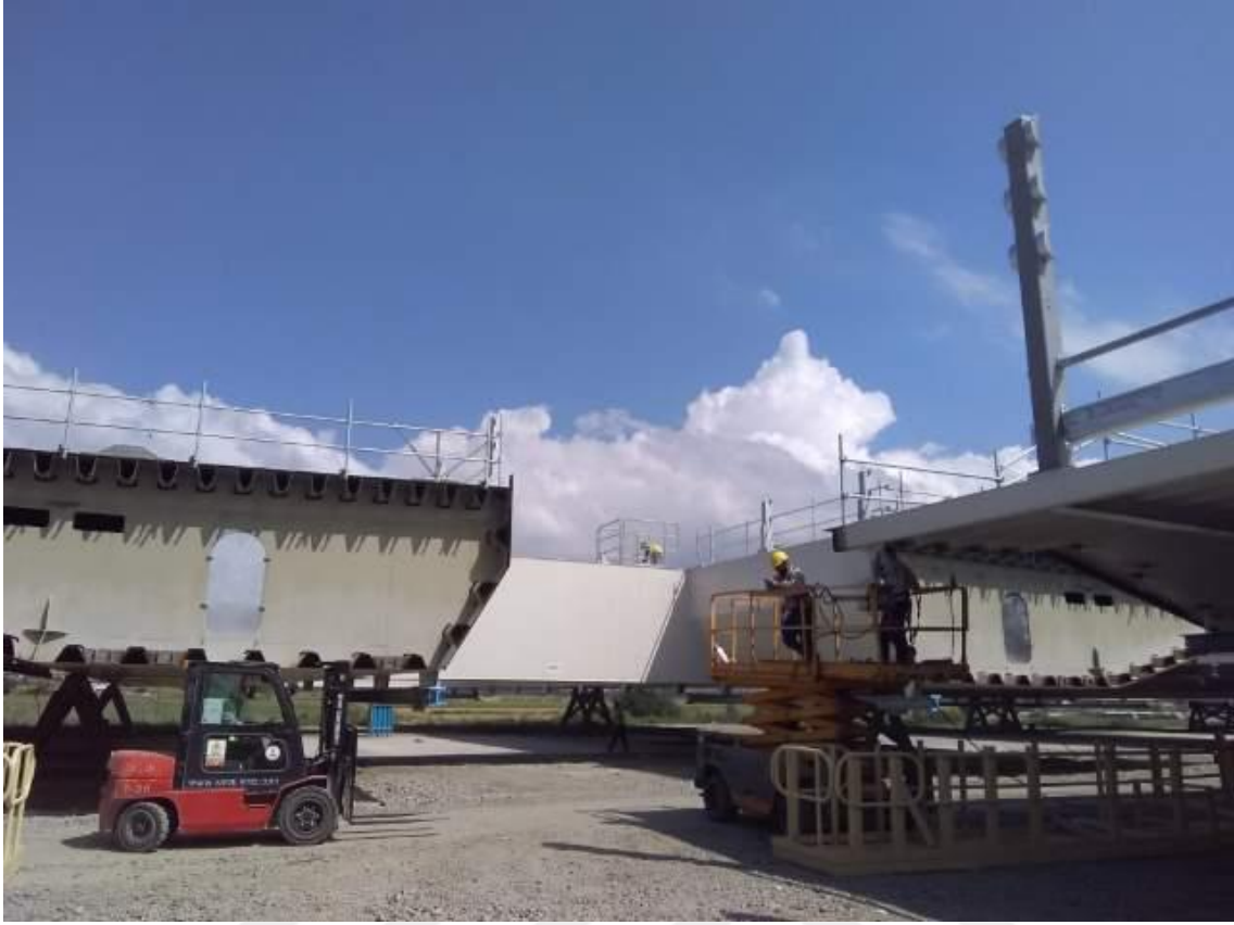
Şekil 3.137. Çelik Tabliye Bloklarının Montaja Hazır Hale Getirilmesi
