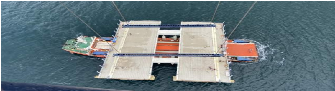
Şekil 3.160. Çelik Tabliye Bloğunun Kaldırılması
