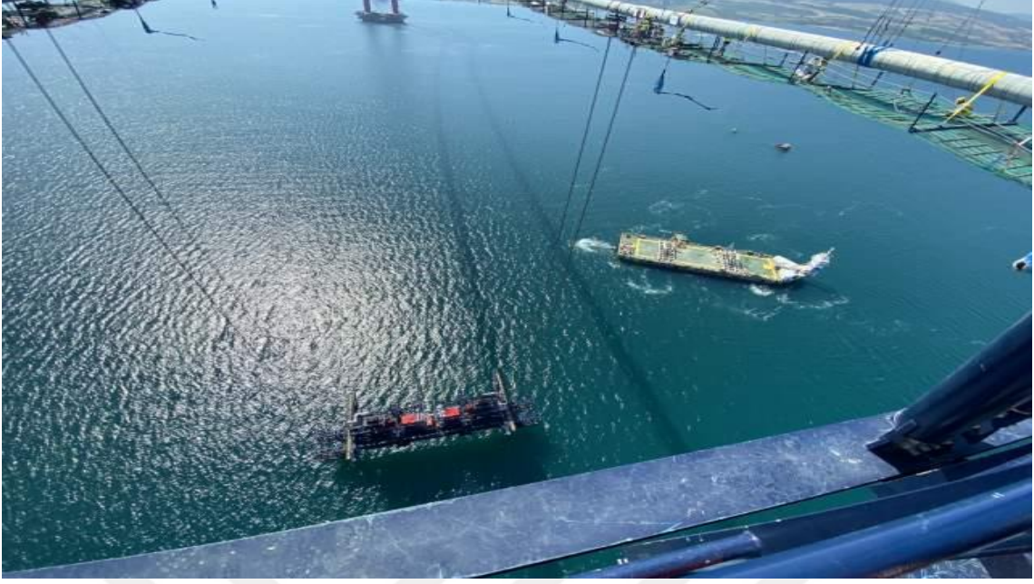
Şekil 3.148. Portal Vinç Kaldırma Operasyonu
