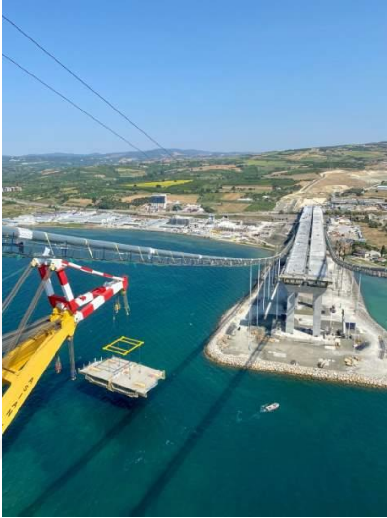
Şekil 3.143. Yüzer Vinç ile Çelik Tabliye Montajı
