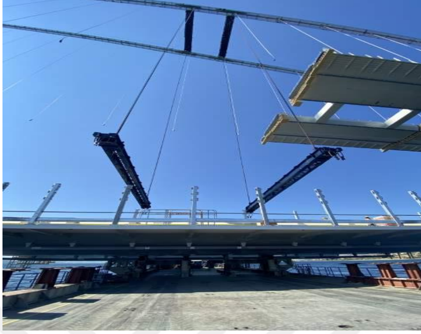
Şekil 3.158. Kaldırma Kirişlerinin Çelik Tabliye Bloğuna Montajı
