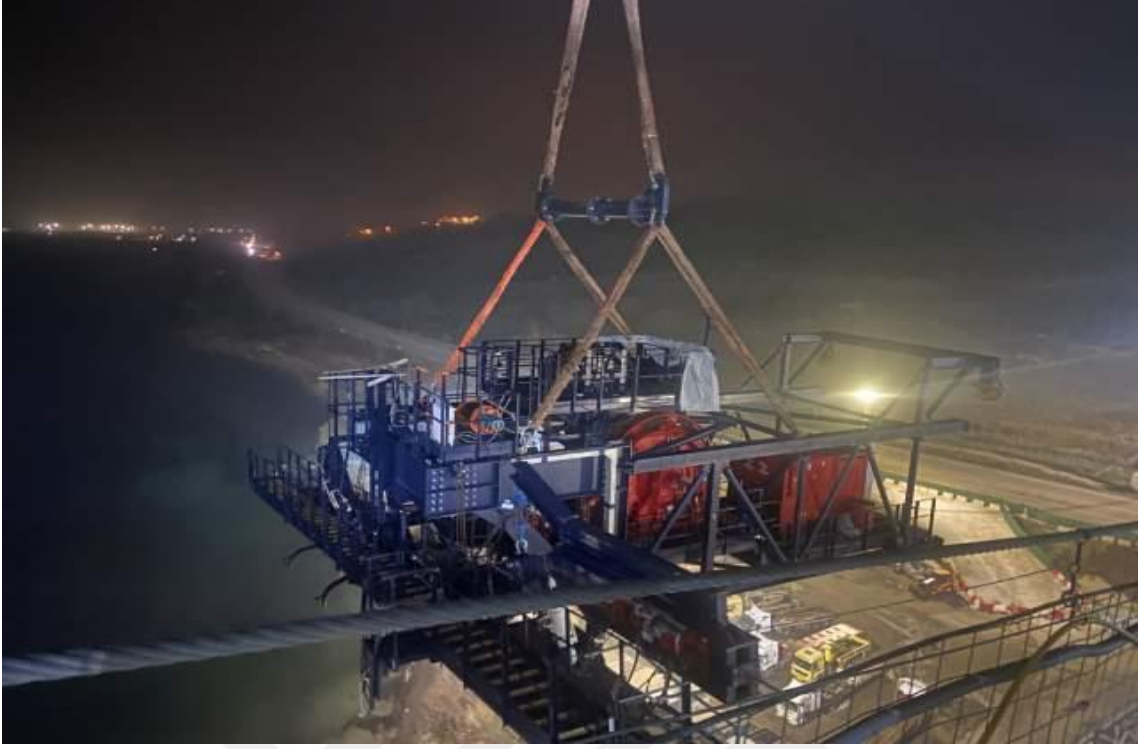
Şekil 3.174. Yan Açıklıktaki Portal Vinçlerin Demontajı
