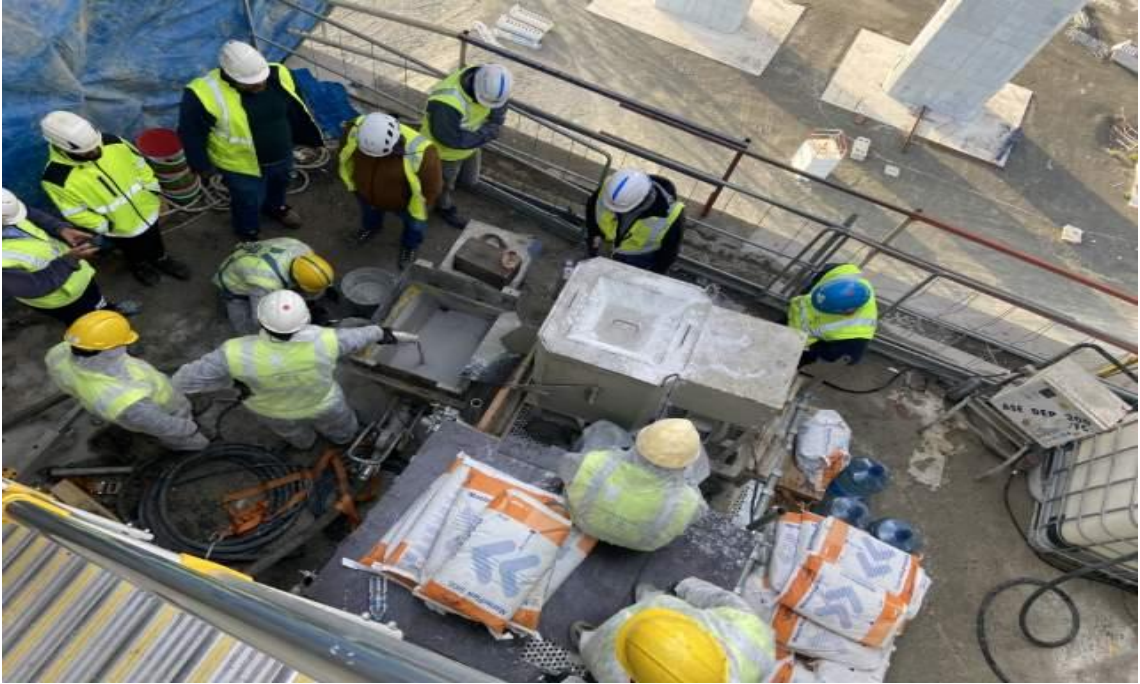
Şekil 3.127. Çelik Tabliye Desteklerinin Beton Alanının Hazırlanması
