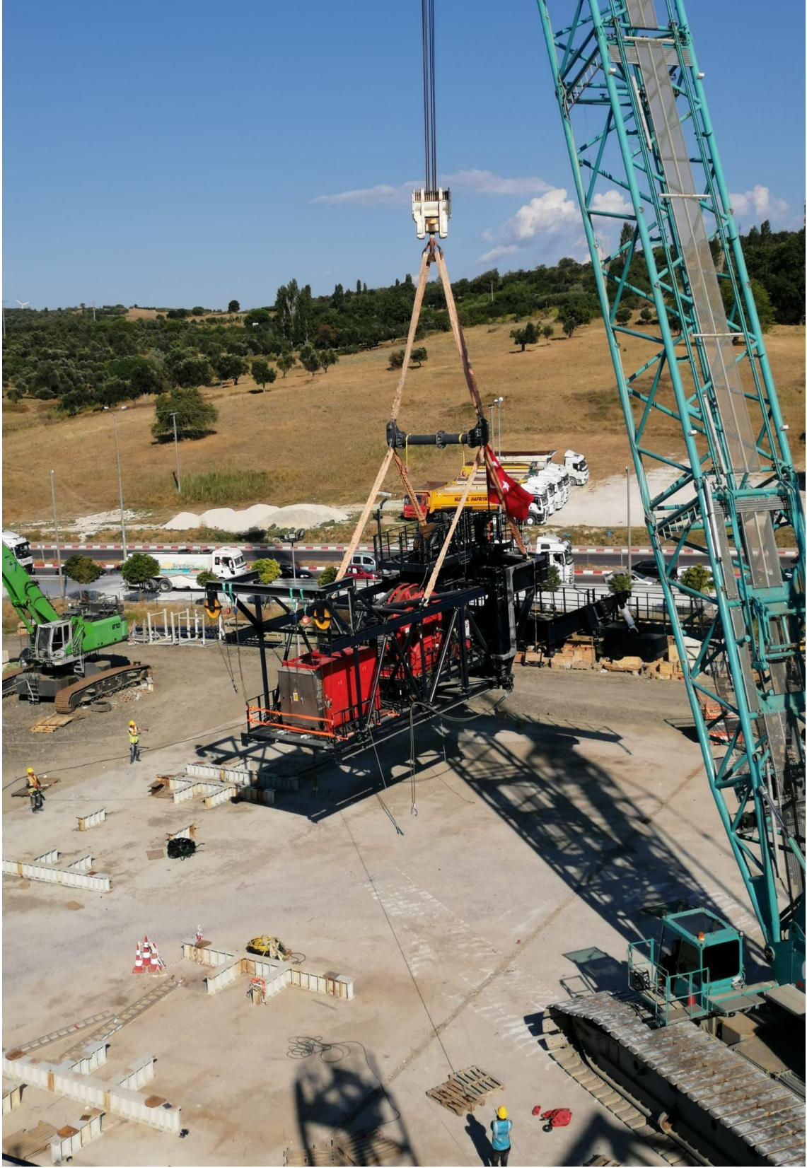
Şekil 3.119. Portal Vinç İmalat Alanı
