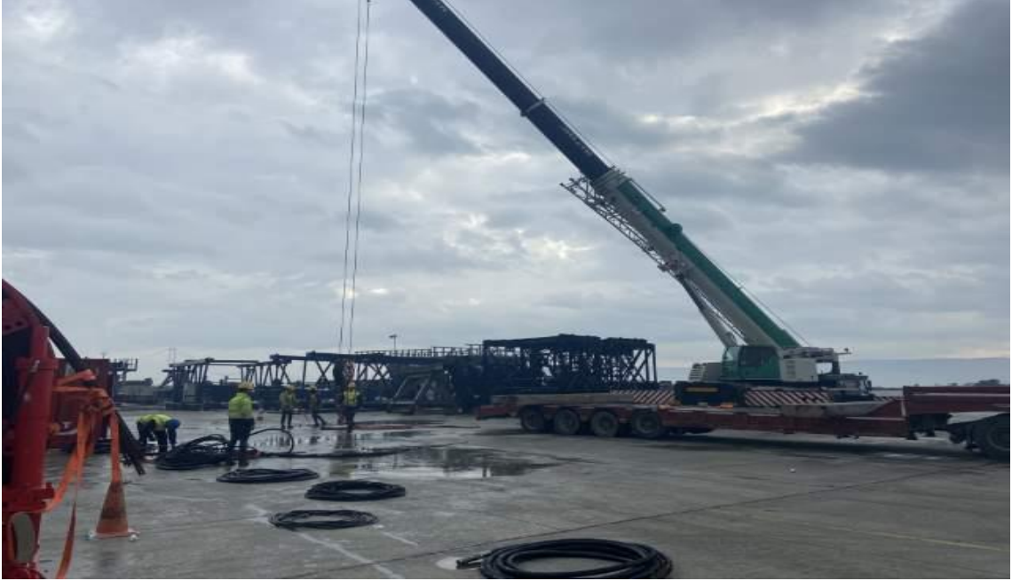
Şekil 3.181. Portal Vinçlerin İstiflenmesi Çalışması
