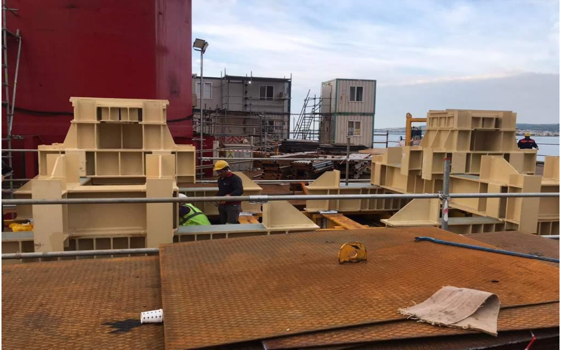
Şekil 3.133. Çelik Tabliye Desteklerinin Montajı
