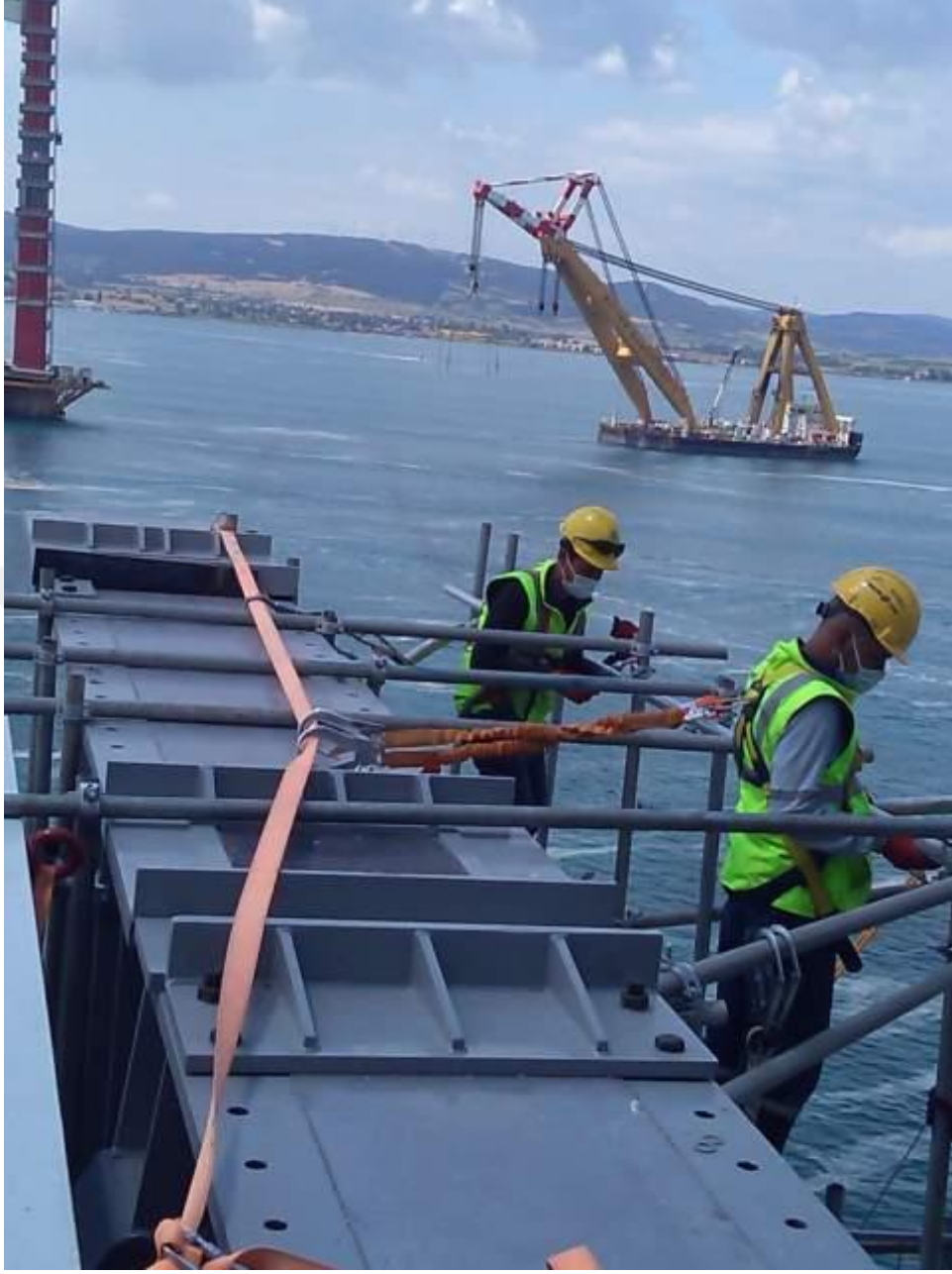
Şekil 3.128. Çelik Tabliye Desteklerinin Montajı
