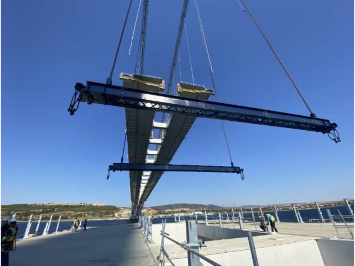
Şekil 3.155. Kaldırma Kirişlerinin Çelik Tabliye Bloğuna Montajı
