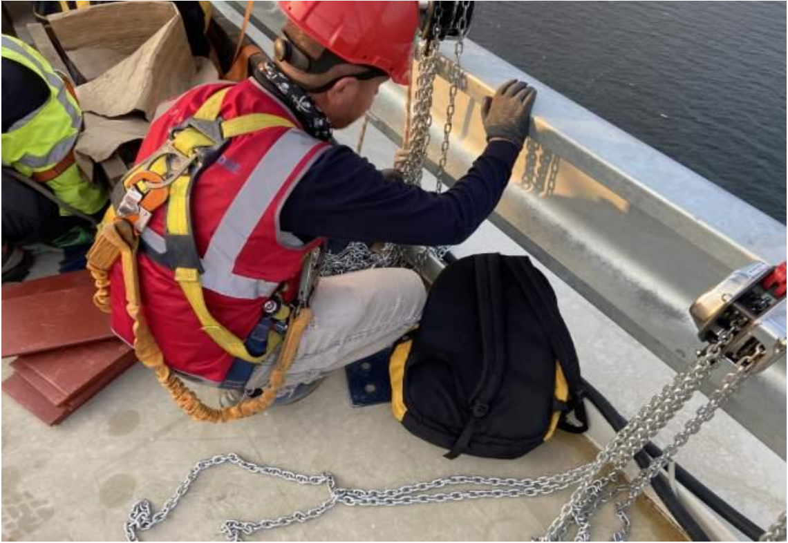
Şekil 3.23. Kaldırma Ekipmanlarının Kontrolü ve Korunması
