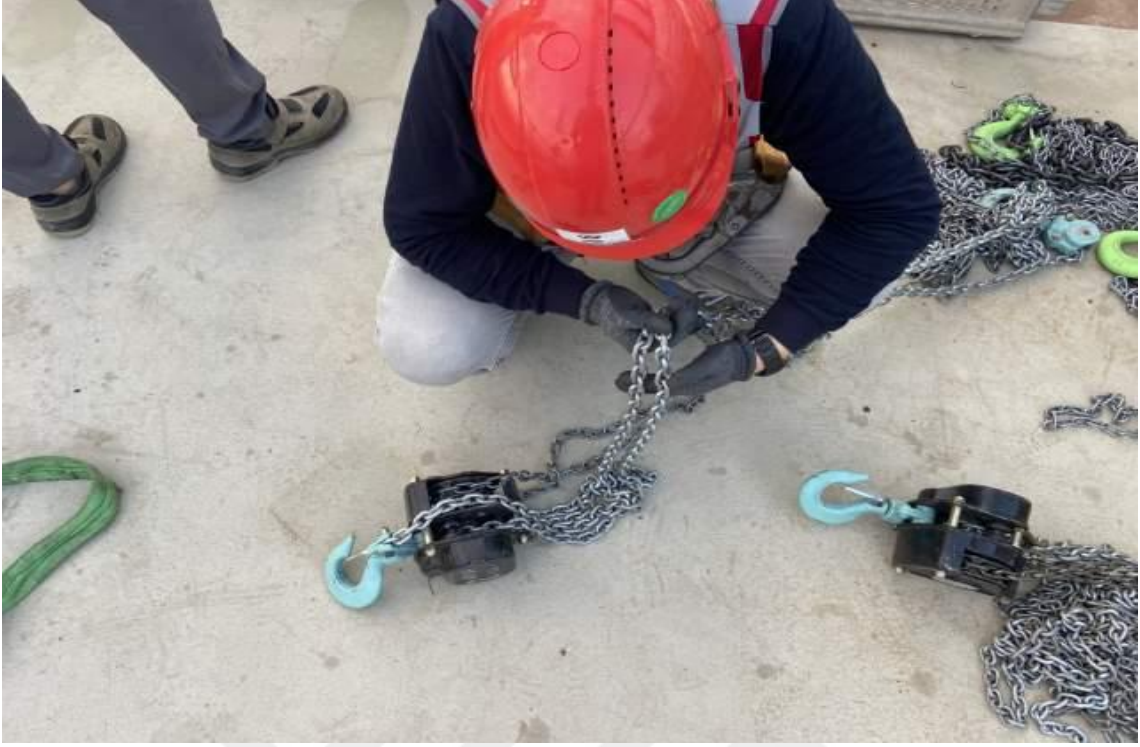
Şekil 3.22. Kaldırma Ekipmanlarının Kontrolü ve Korunması
