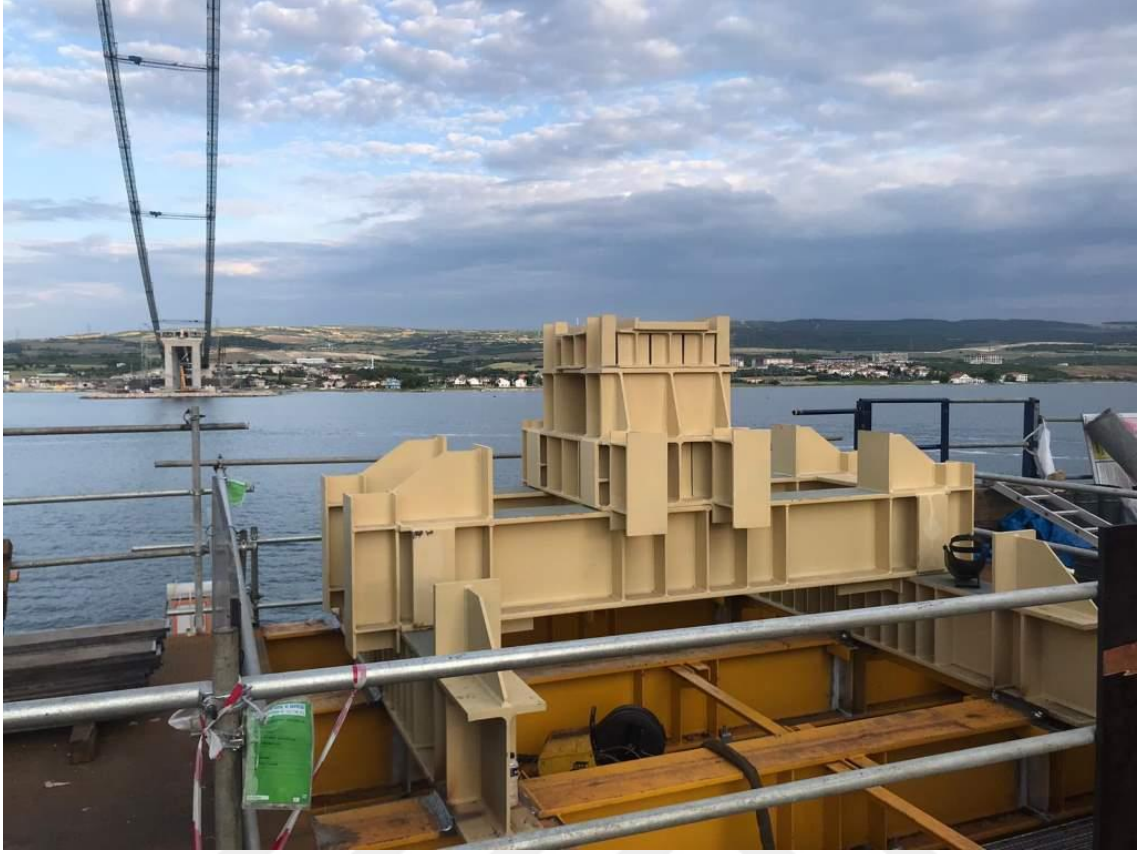
Şekil 3.132. Çelik Tabliye Desteklerinin Montajı
