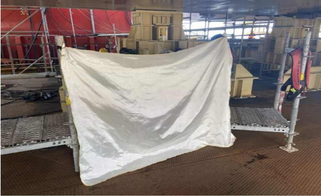
Şekil 3.18. Örnek Sıcak Çalışma Alan Koruması
