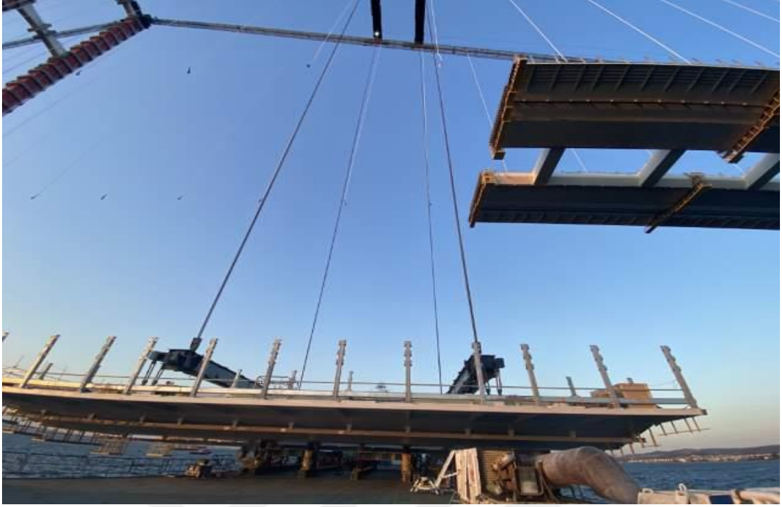
Şekil 3.156. Kaldırma Kirişlerinin Çelik Tabliye Bloğuna Montajı
