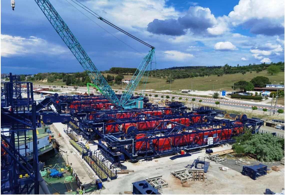
Şekil 3.117. Portal Vinç İmalat Alanı
