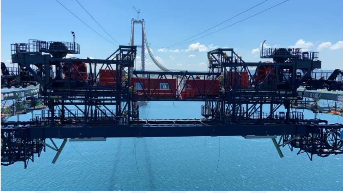
Şekil 3.150. Portal Vinç Montajı
