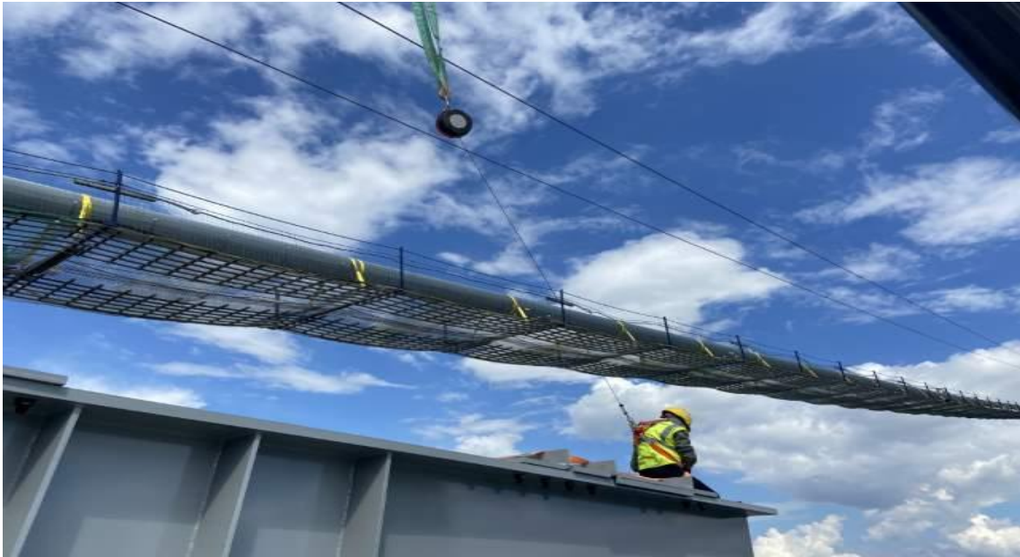
Şekil 3.125. Çelik Tabliye Desteklerinin Montajı
