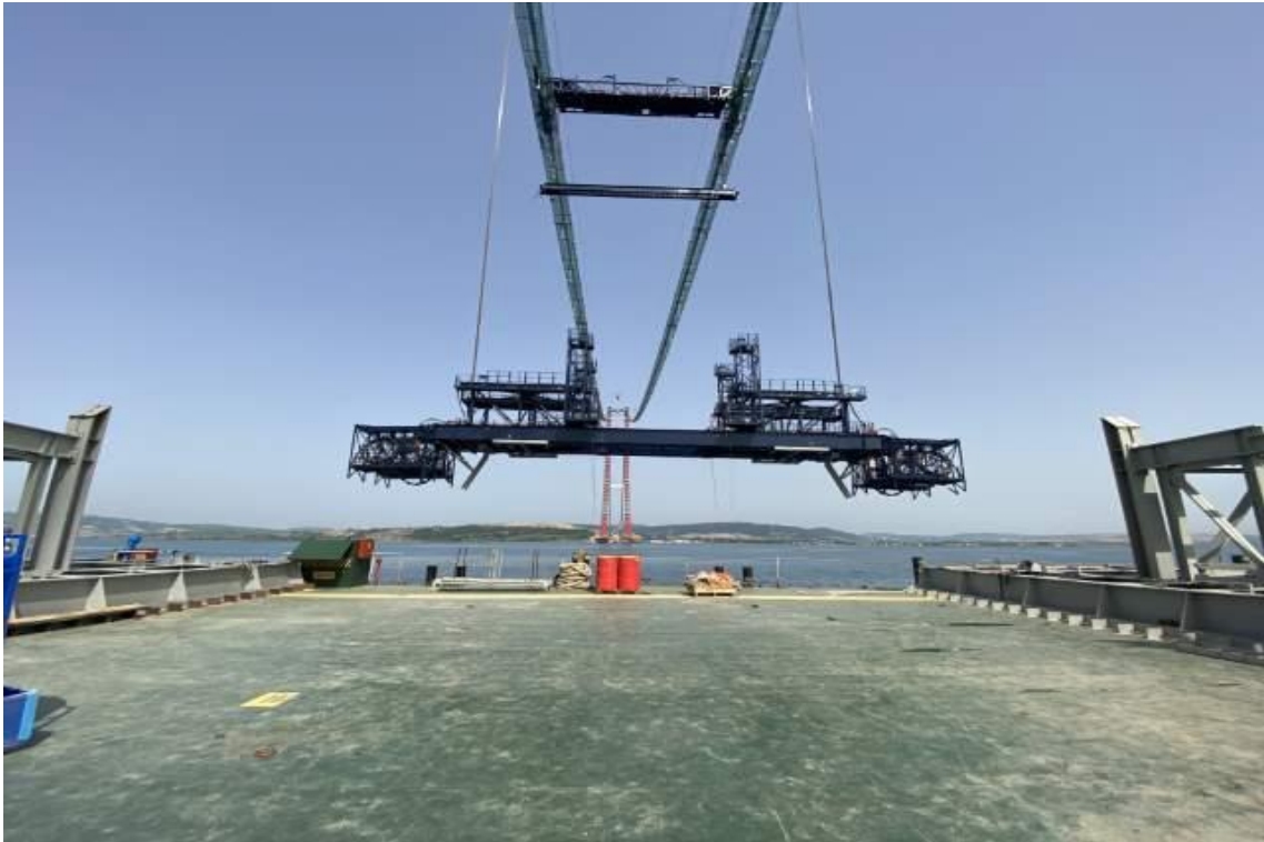
Şekil 3.154. Kendi Kendine Kaldırma Sisteminin İndirilmesi
