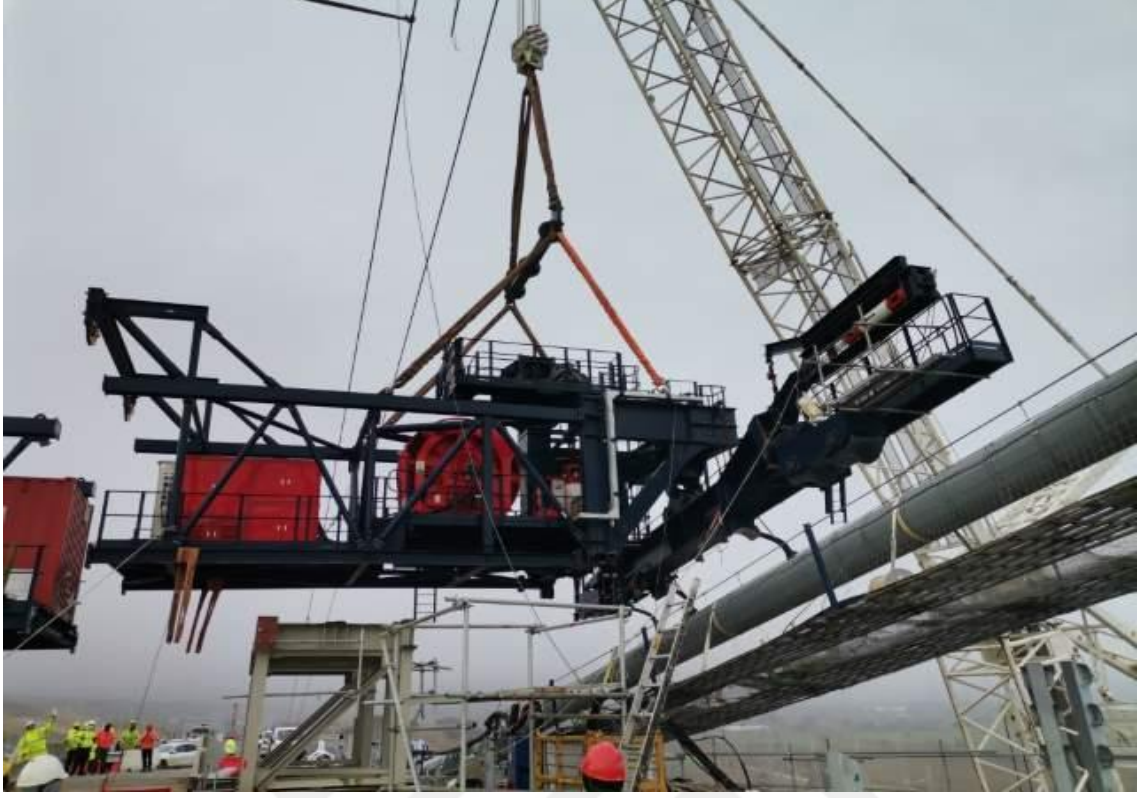
Şekil 3.177. Yan Açıklıktaki Portal Vinçlerin Demontajı
