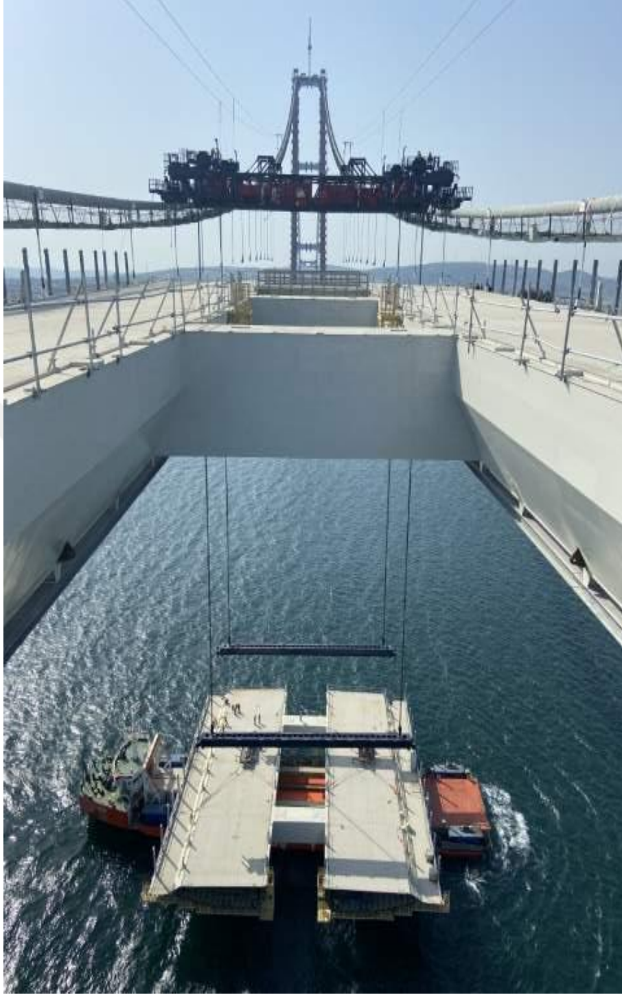
Şekil 3.48. Çelik Tabliye Kaldırma Sırasında Alan Kapama Çalışması
