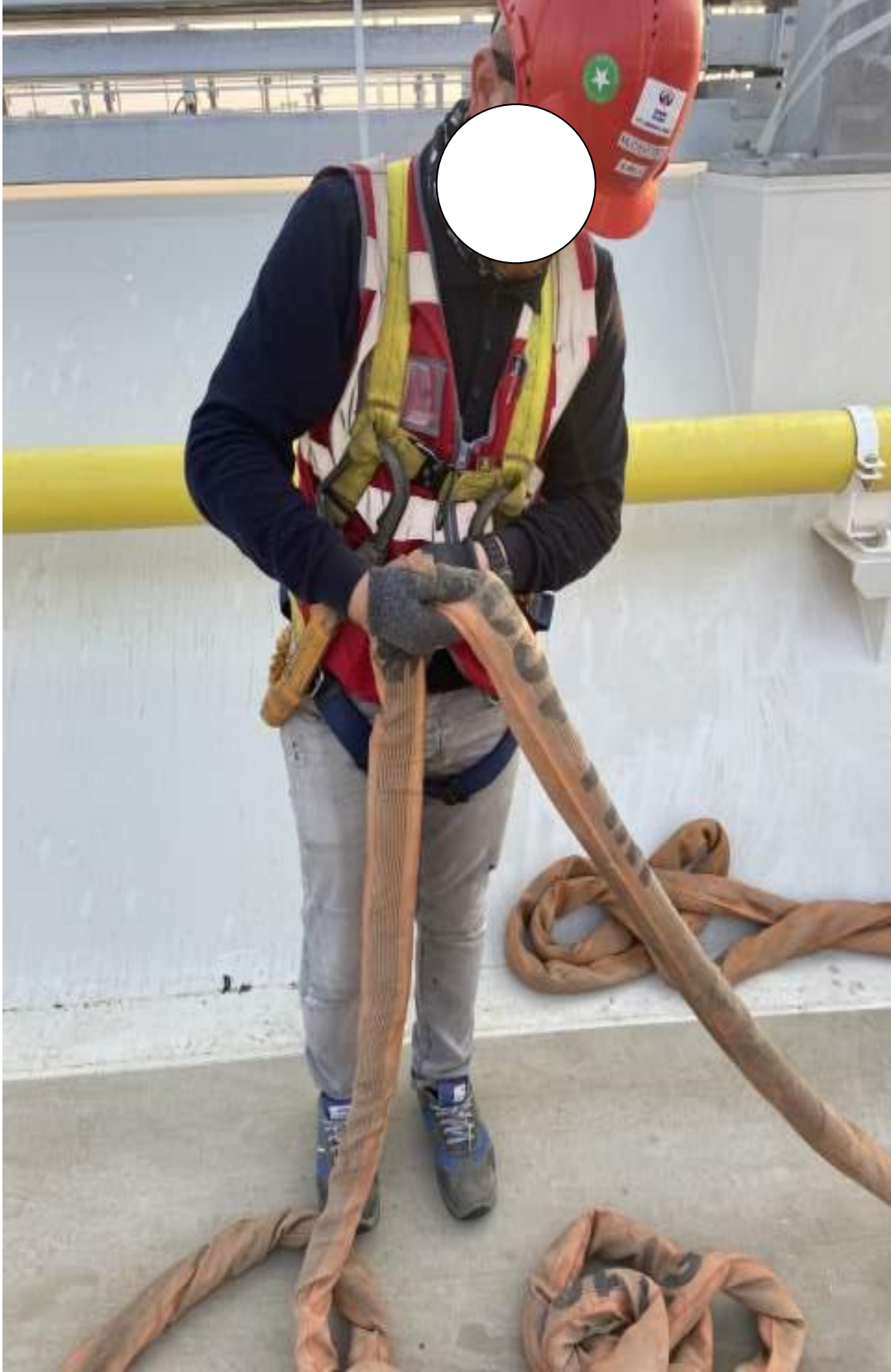
Şekil 3.24. Kaldırma Ekipmanlarının Kontrolü ve Korunması
