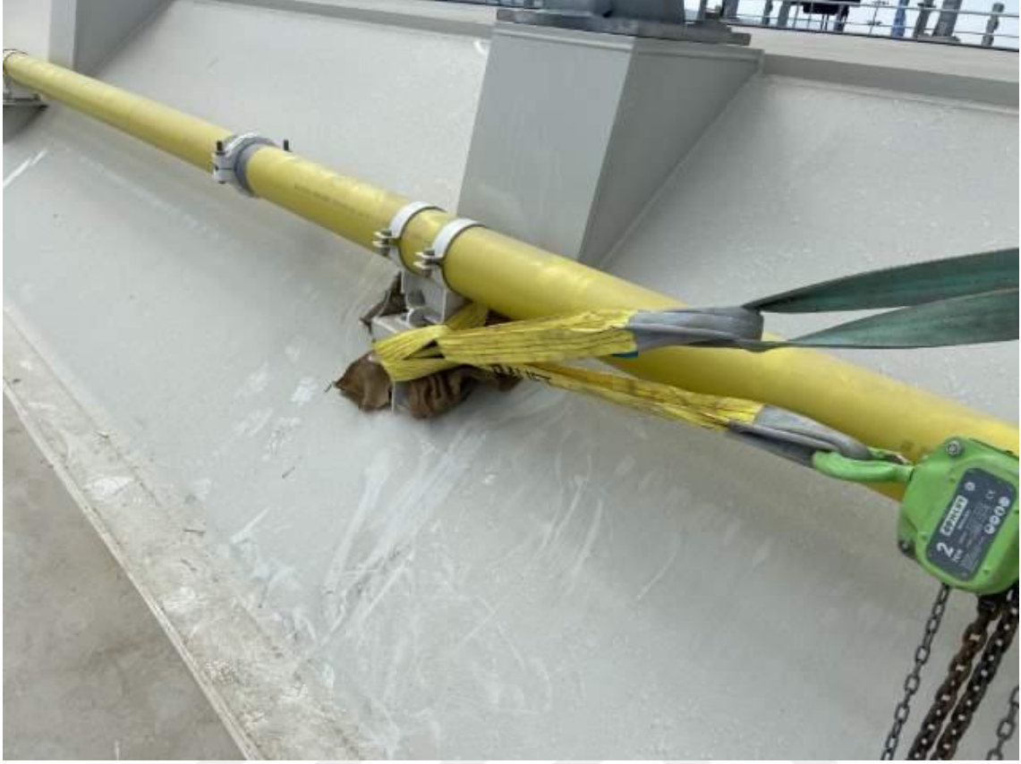
Şekil 3.25. Kaldırma Ekipmanlarının Kontrolü ve Korunması
