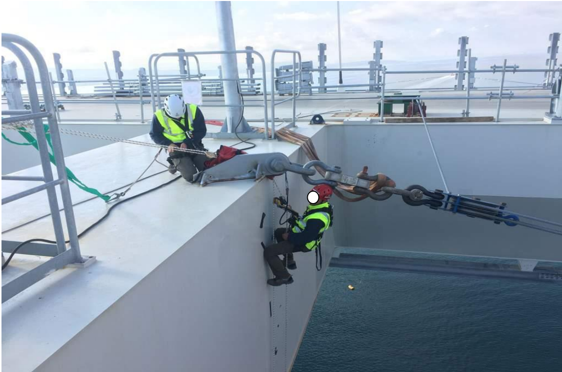
Şekil 3.165. Bağlantı Noktası IRATA Çalışması
