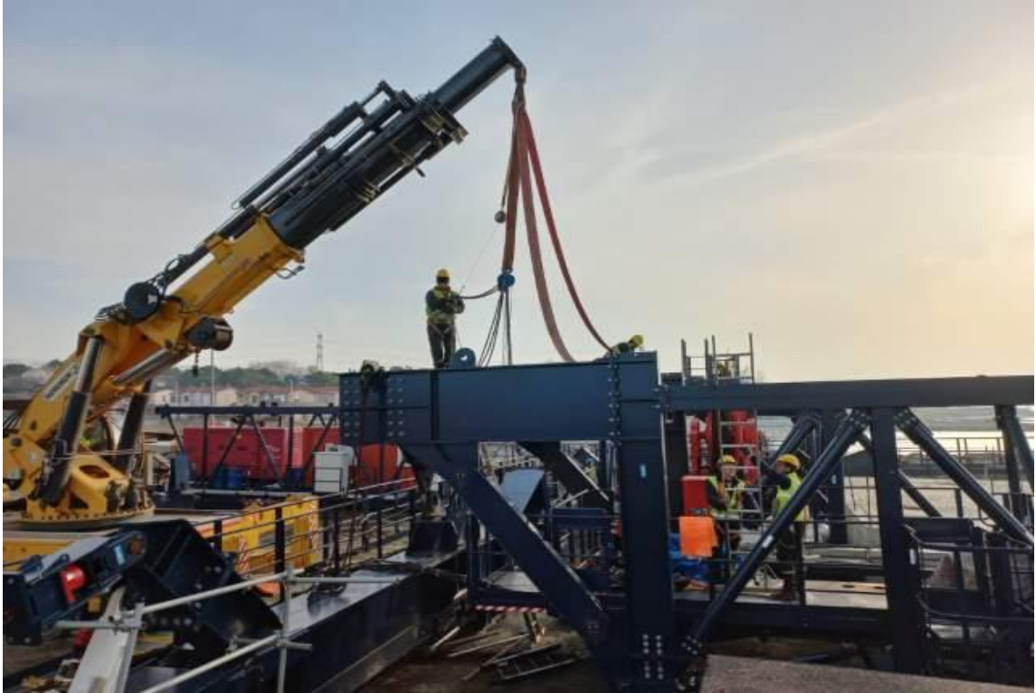
Şekil 3.178. Yan Açıklıktaki Portal Vinçlerin Demontajı
