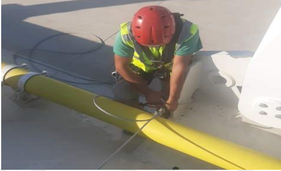
Şekil 3.52. Yaşam Hattı Kurulum Çalışması
