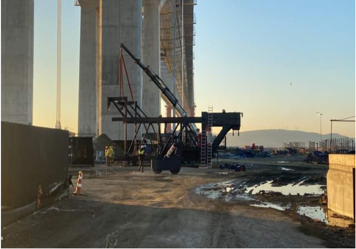
Şekil 3.175. Yan Açıklıktaki Portal Vinçlerin Demontajı
