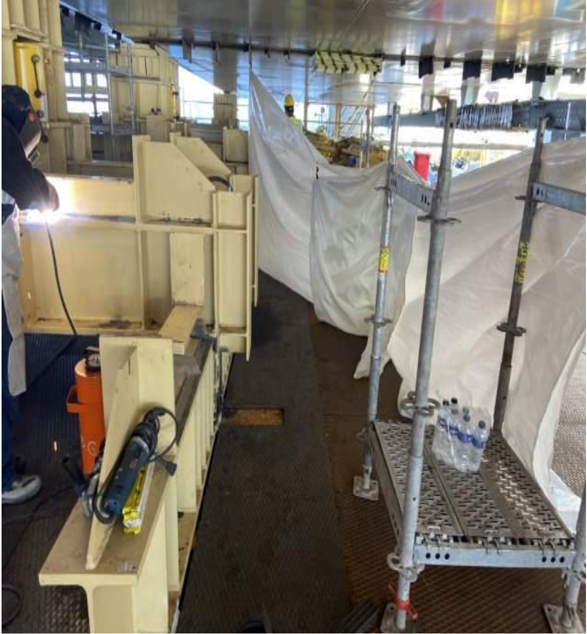
Şekil 3.19. Örnek Sıcak Çalışma Alan Koruması
