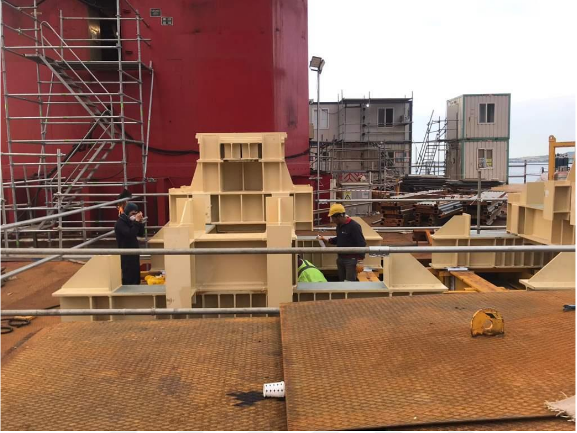
Şekil 3.130. Çelik Tabliye Desteklerinin Montajı
