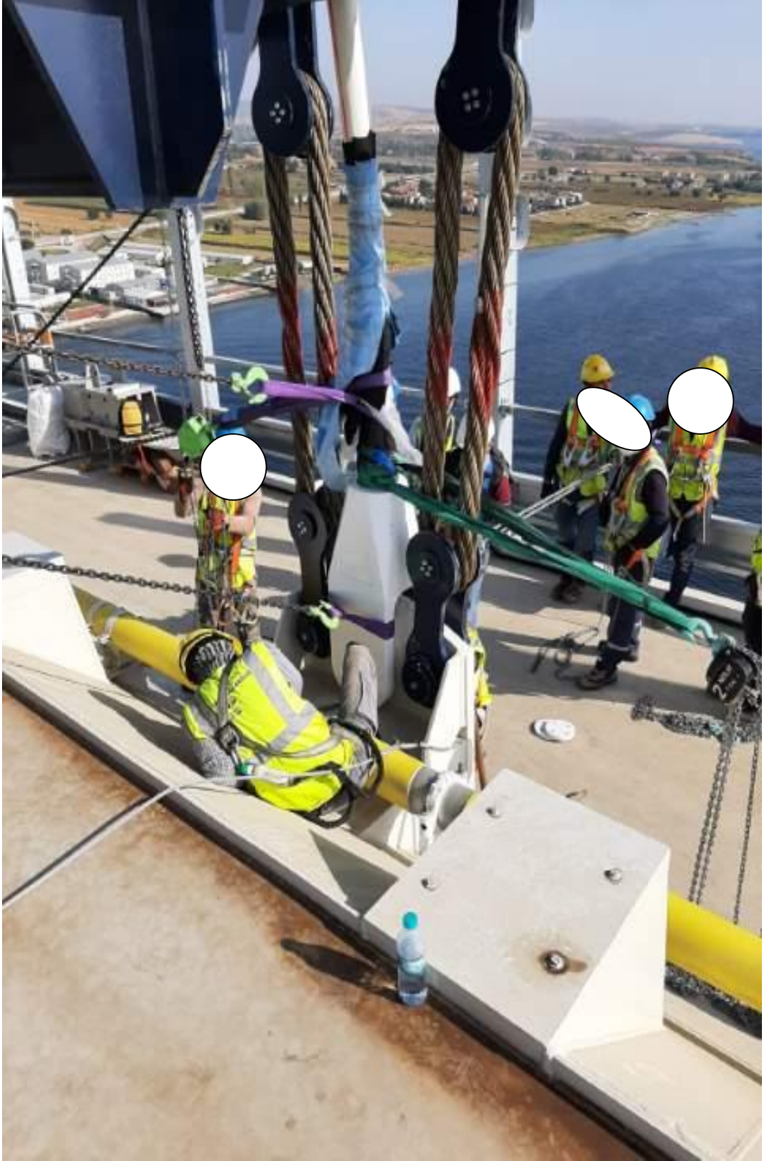
Şekil 3.162. Çelik Tabliye Bloğunu Montajı
