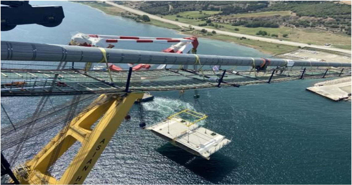
Şekil 3.139. Yüzer Vinç ile Çelik Tabliye Montajı
