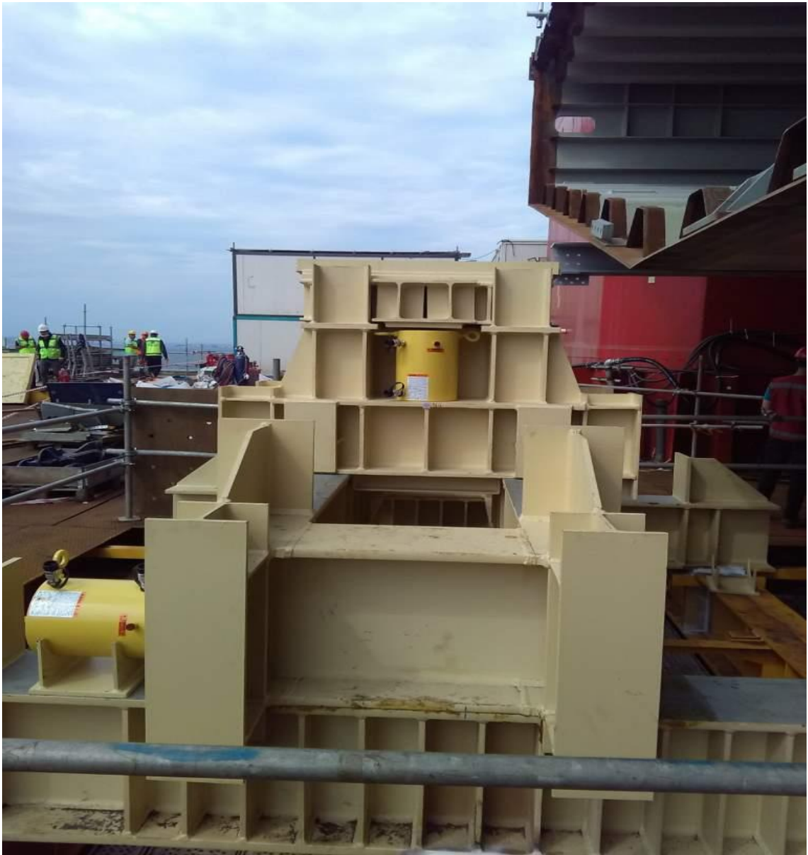
řekil 3.129. elik Tabliye Desteklerinin Montajı
