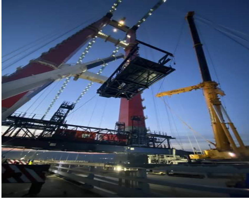
Şekil 3.170. Orta Açıklıktaki Portal Vinçlerin Demontajı
