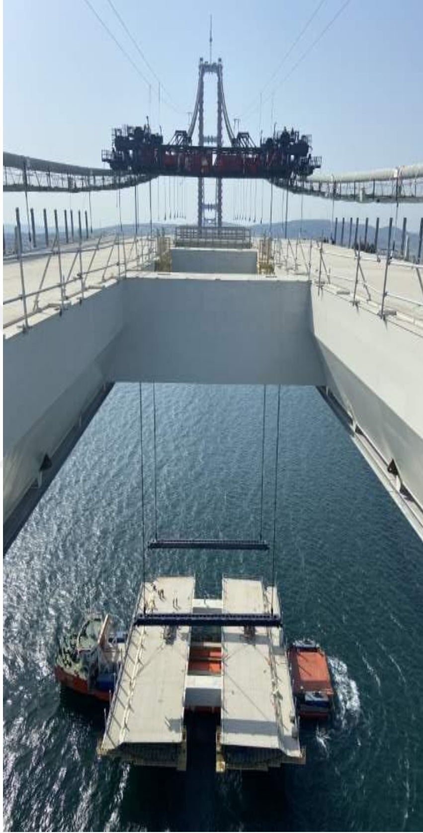
Şekil 3.161. Çelik Tabliye Bloğunun Kaldırılması
