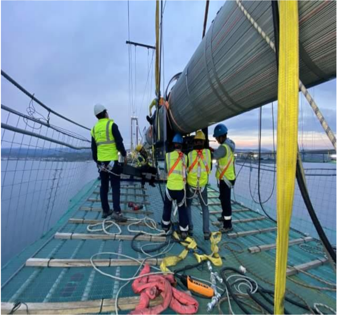
Şekil 3.147. Portal Vinç Kaldırma Kelepçesi Montajı
