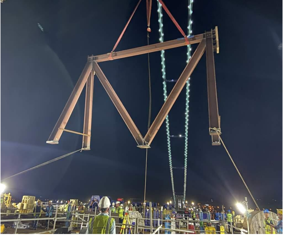
Şekil 3.136. Kılavuz Çerçeve Montajı
