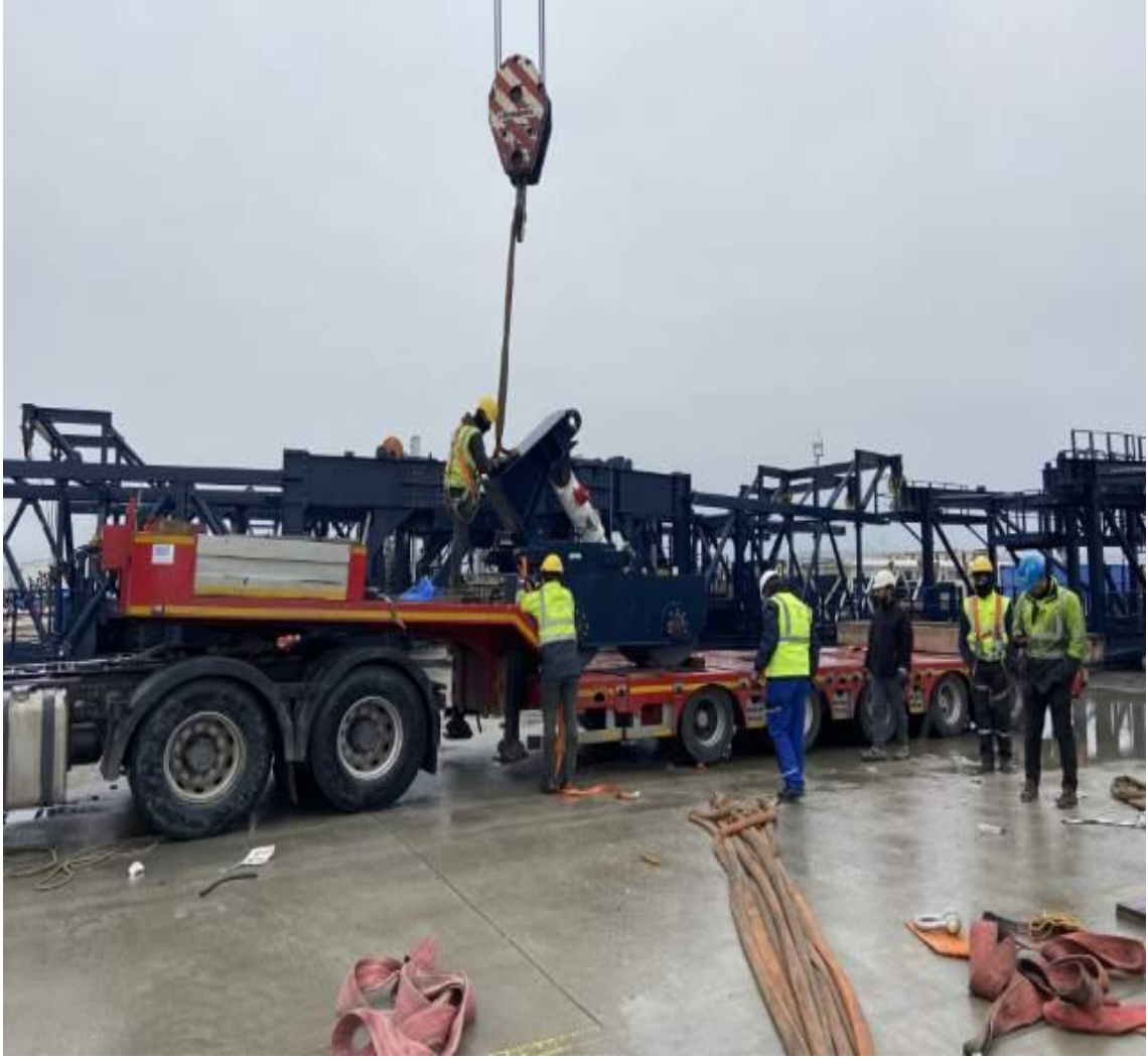
Şekil 3.182. Portal Vinçlerin İstiflenmesi Çalışması
