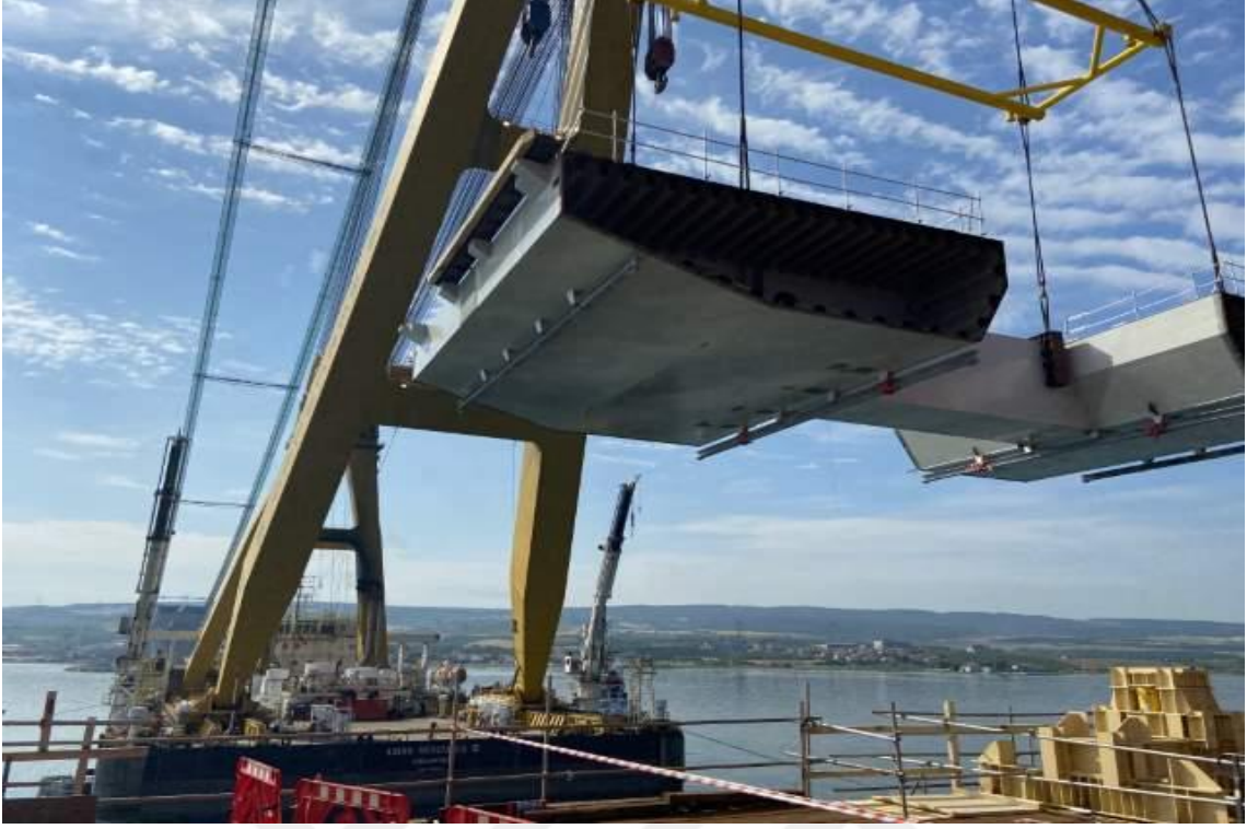
Şekil 3.146. Yüzer Vinç ile Çelik Tabliye Konumlandırılması
