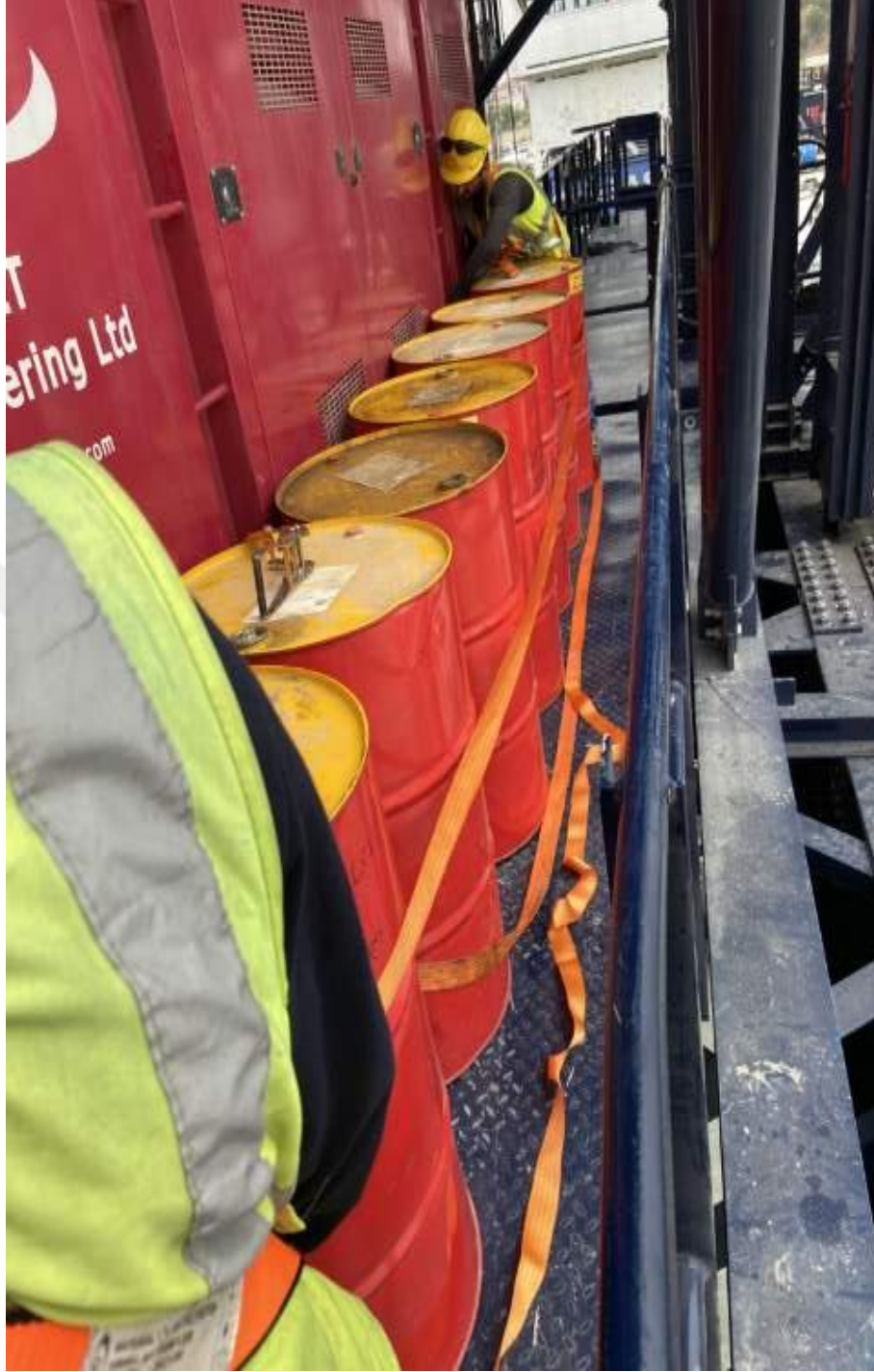
Şekil 3.47. Örnek Parça ve Malzeme Sabitleme Çalışması
