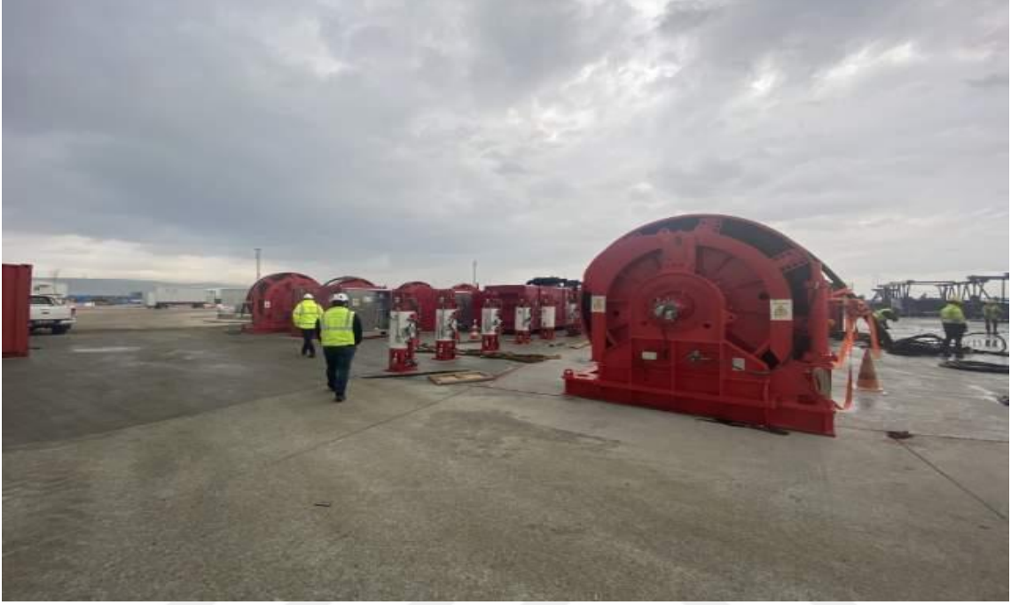
Şekil 3.180. Portal Vinçlerin İstiflenmesi Çalışması
