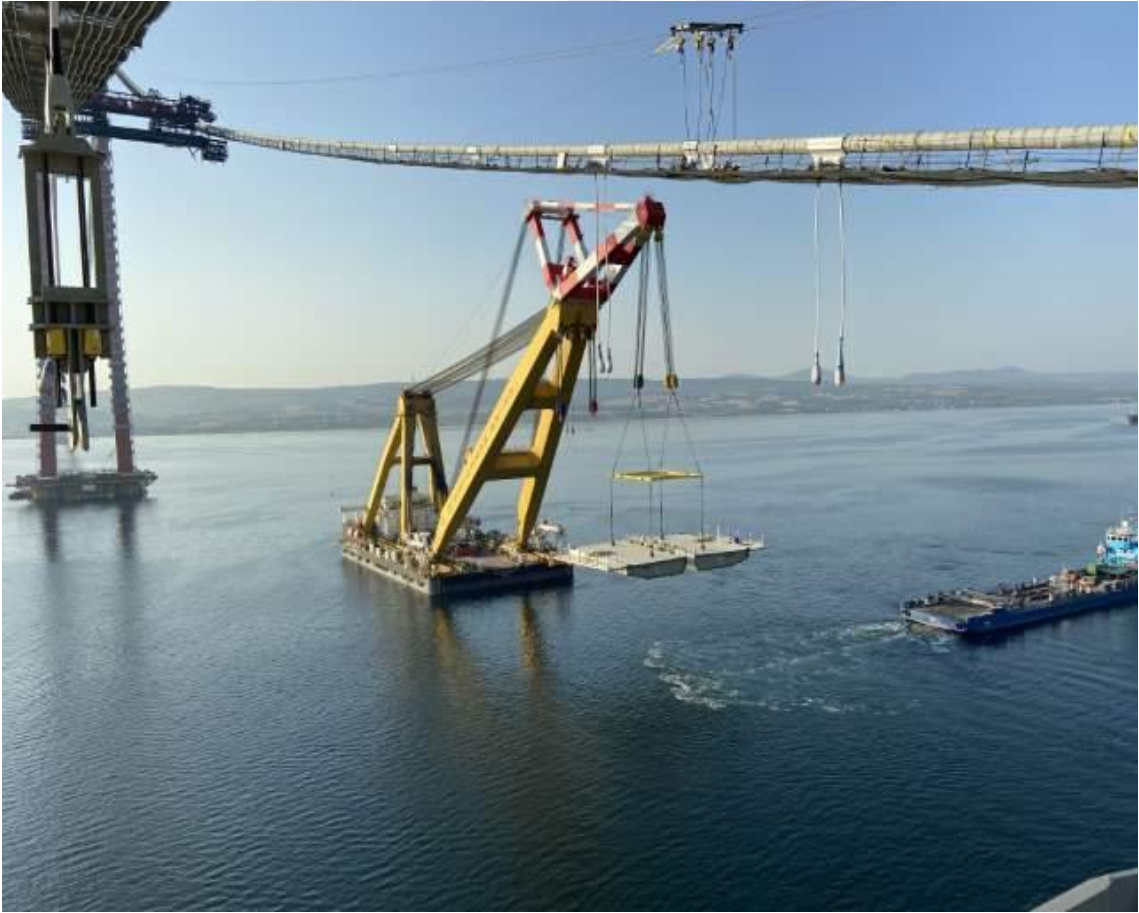
Şekil 3.142. Yüzer Vinç ile Çelik Tabliye Montajı
