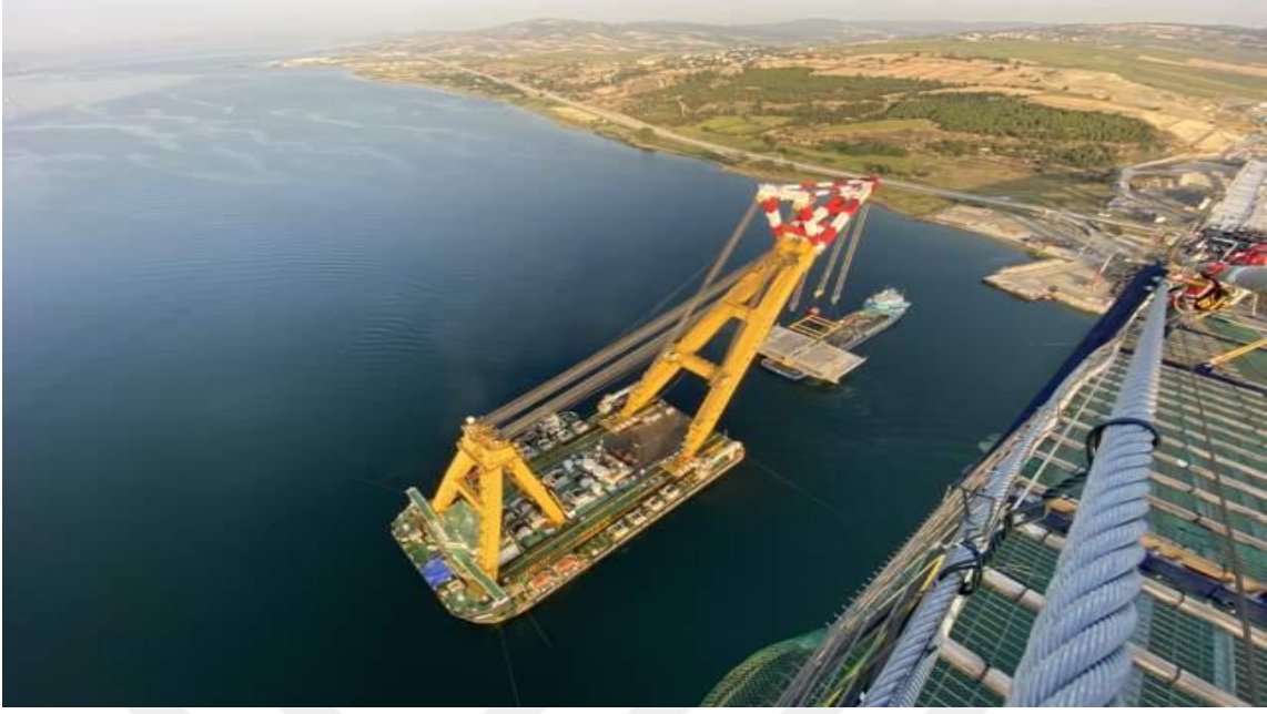
Şekil 3.141. Yüzer Vinç ile Çelik Tabliye Montajı
