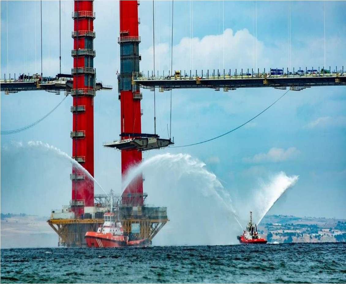
Şekil 3.167. Çelik Tabliye Bloklarının Kaldırılması
