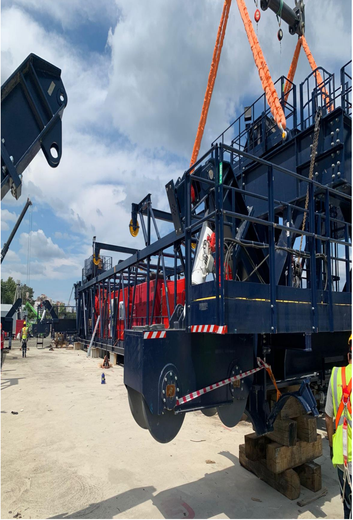
Şekil 3.118. Portal Vinç İmalat Alanı
