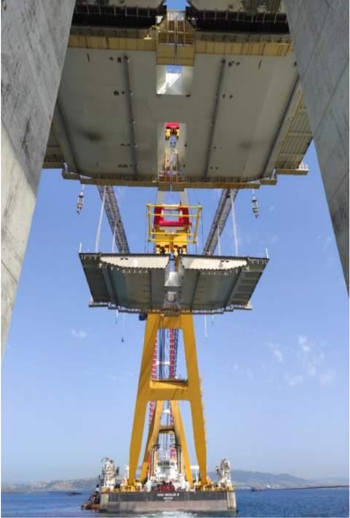
Şekil 3.140. Yüzer Vinç ile Çelik Tabliye Montajı
