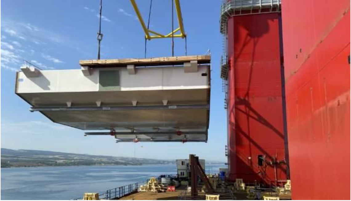
Şekil 3.144. Yüzer Vinç ile Çelik Tabliye Konumlandırılması
