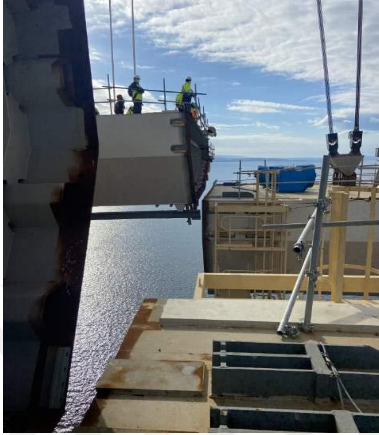
Şekil 3.169. Anahtar Segment Çelik Tabliye Bloğu Montaj Çalışması
