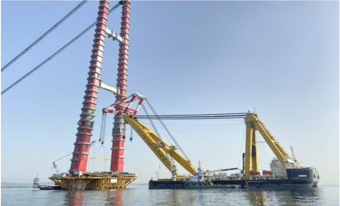
Şekil 3.145. Yüzer Vinç ile Çelik Tabliye Konumlandırılması
