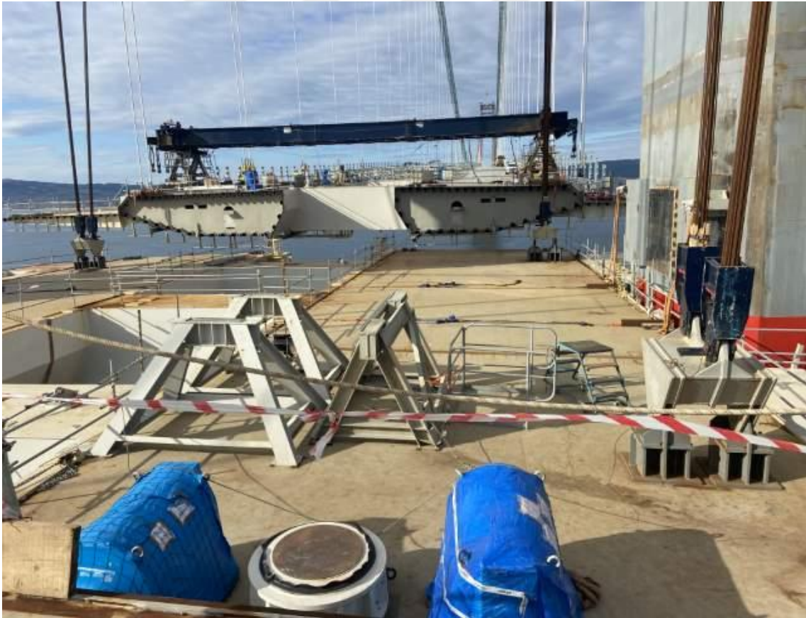
Şekil 3.168. Anahtar Segment Çelik Tabliye Bloğu Montaj Çalışması
