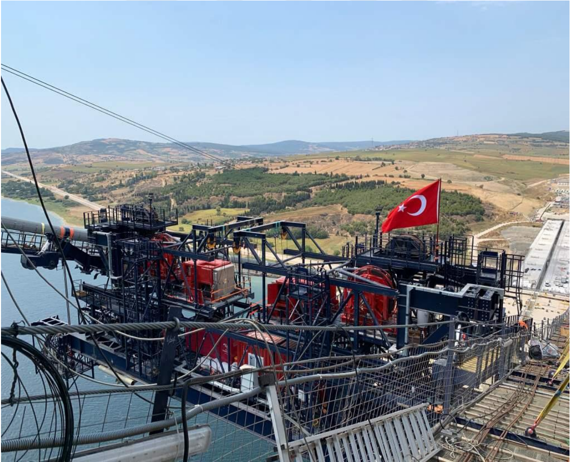
Şekil 3.151. Portal Vinç Montajı
