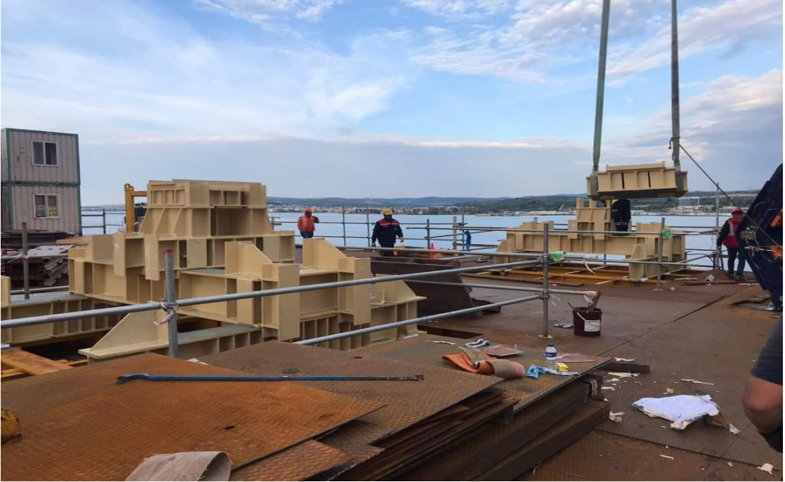
Şekil 3.131. Çelik Tabliye Desteklerinin Montajı
