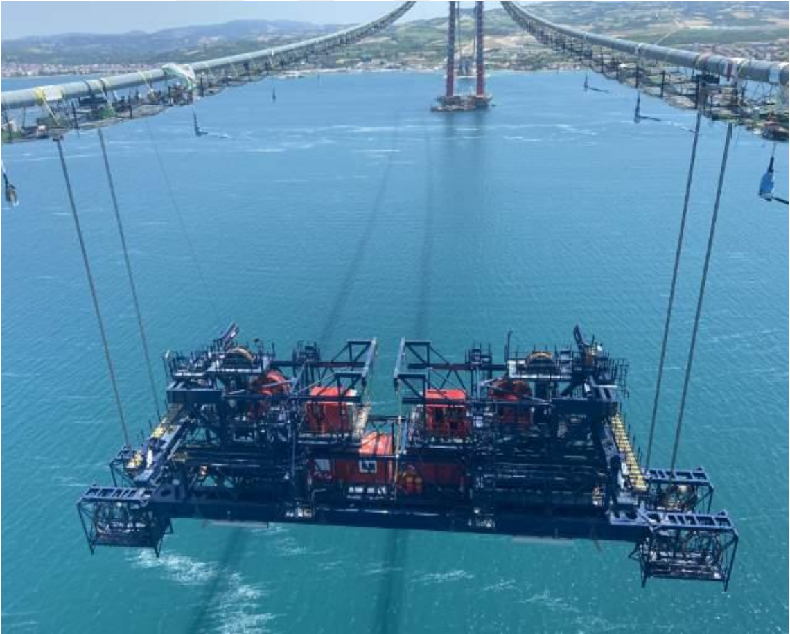
Şekil 3.149. Portal Vinç Kaldırma Operasyonu
