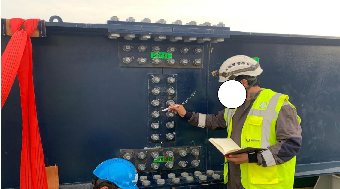
Şekil 3.123. Portal Vinç Kalite Kontrol Çalışması
