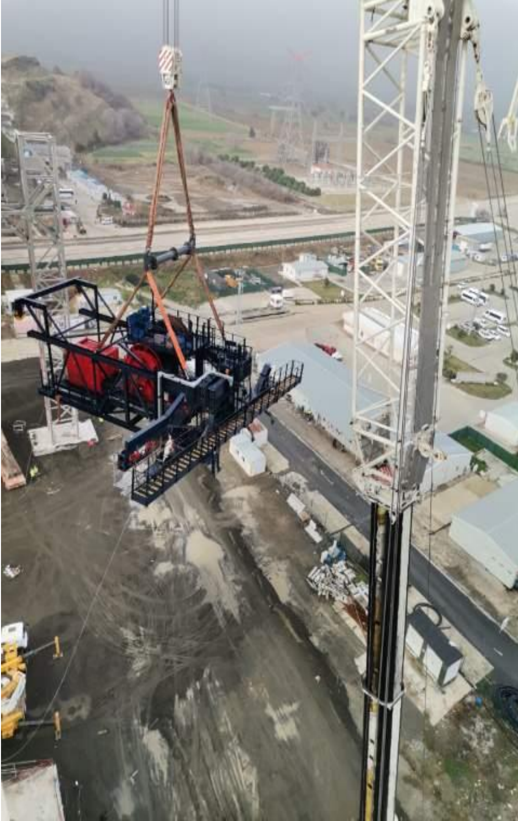
Şekil 3.176. Yan Açıklıktaki Portal Vinçlerin Demontajı
