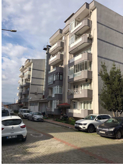
Şekil 5.40. Yeni Kordon Sitesi Görünüş
