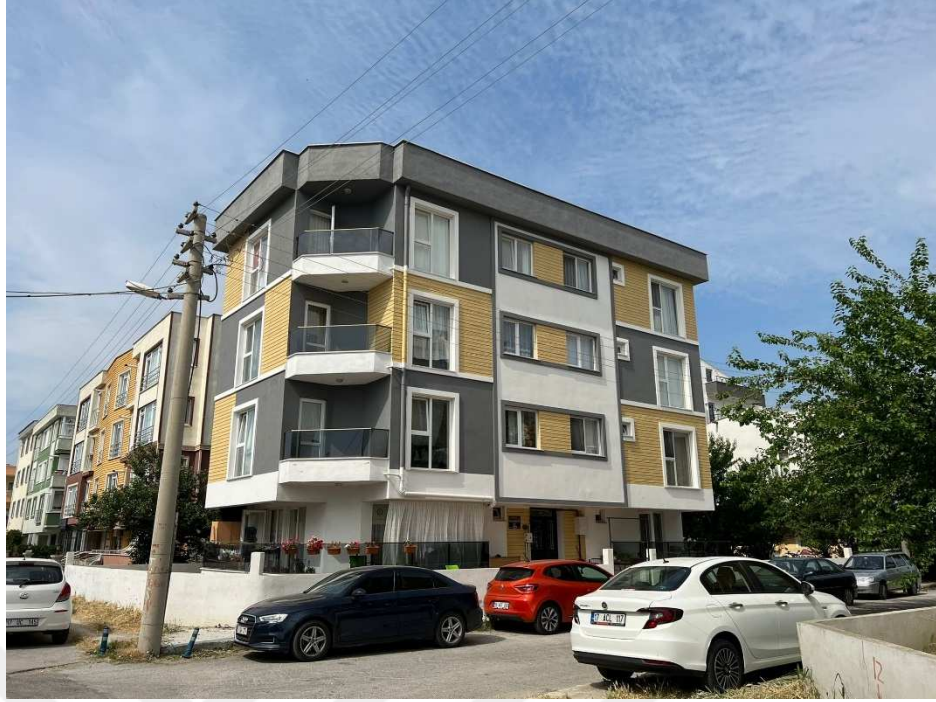
Şekil 5.69. Ihlamur Apartmanı Görünüş
