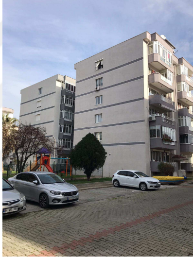
Şekil 5.41. Yeni Kordon Sitesi Görünüş
