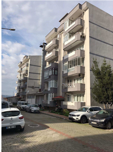
Şekil 5.42. Yeni Kordon Sitesi Görünüş
