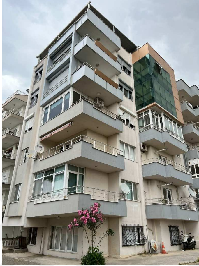
Şekil 5.54. Kent Apartmanı Görünüş
