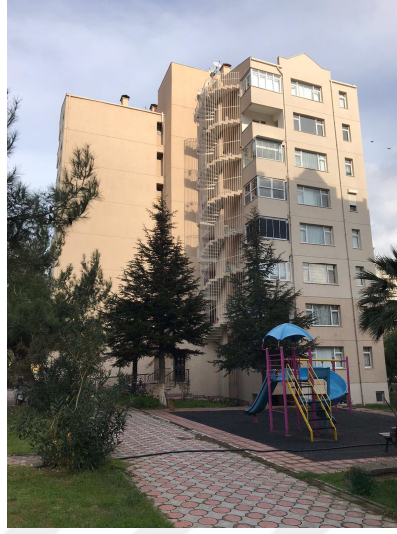
Şekil 5.47. Barışkent II Sitesi Görünüş
