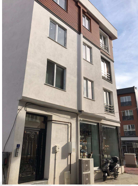
Şekil 5.66. Şenol Kankaya Apartmanı Görünüş
