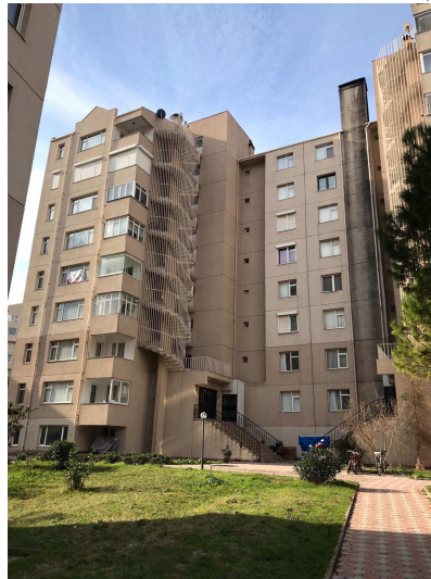
Şekil 5.46. Barışkent II Sitesi Görünüş
