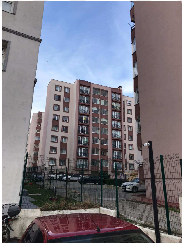
Şekil 5.60. Özgürkent Sitesi Görünüş
