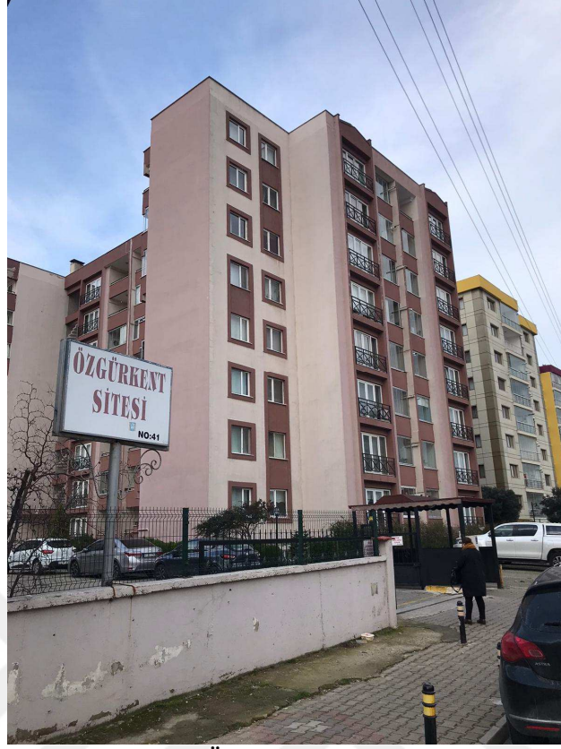
Şekil 5.59. Özgürkent Sitesi Görünüş
