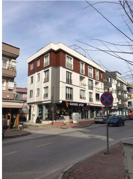
Şekil 5.65. Şenol Kankaya Apartmanı Görünüş
