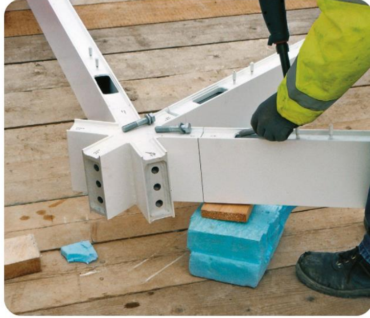
Şekil 2.7. Kutu kesit profiller için düğüm birleşim detayı (L'Informatiu blog, 2018)
