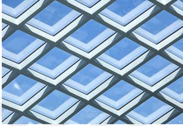
ekil 3.3. Nazarbayer Centre yapısında kullanılan elik profiller (Metal Yapı, 2021)
