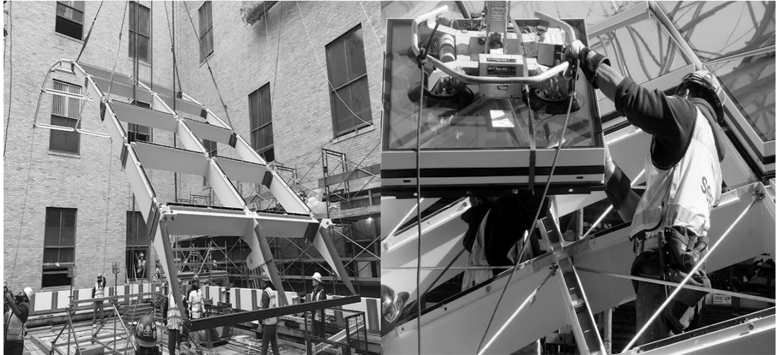
Şekil 2.23. Moynihan Tren İstasyonu çatı montaj aşaması (Seele, 2021)
