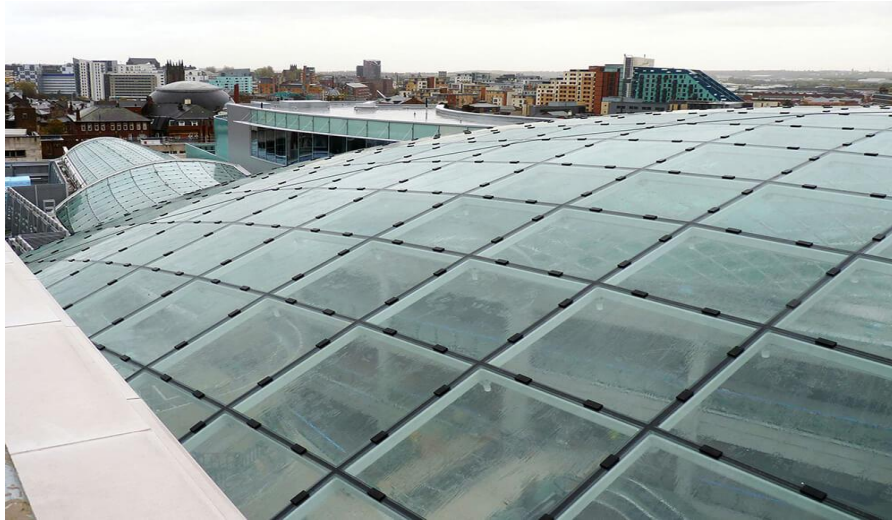
Şekil 2.25. Trinity Alışveriş Merkezi çatısı cam kaplama uygulaması (Seele, 2021)
