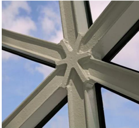
Şekil 3.8. De Blub düğüm noktası kaynaklı çelik dikdörtgen kesit birleşim detayı (Knippershelbig, 2021)
