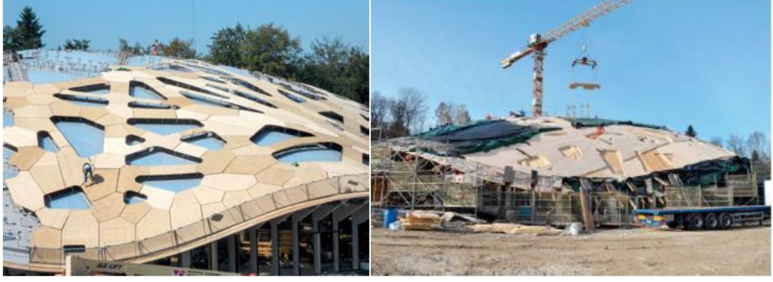
Şekil 4.1. Elephant House, ahşap kabuğun montaj aşaması (Koç, 2020)
