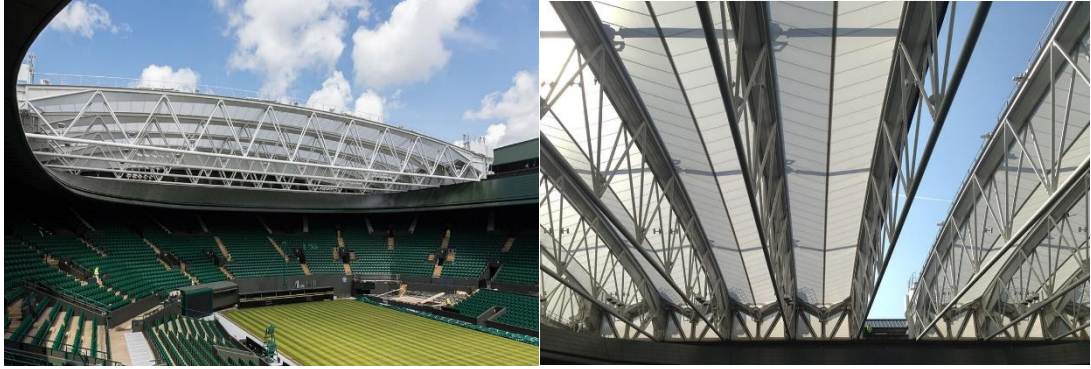
Şekil 2.17. All England Çim kort membran çatı kaplaması uygulaması (Seele, 2021)
