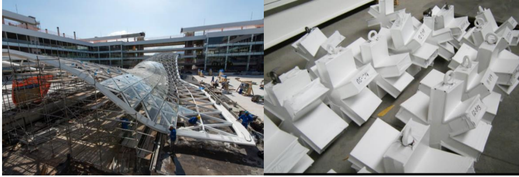
Şekil 3.5. Casa Shopping Carioca Wave yapım aşaması ve düğüm birleşim detayı (Knippershelbig, 2021)
