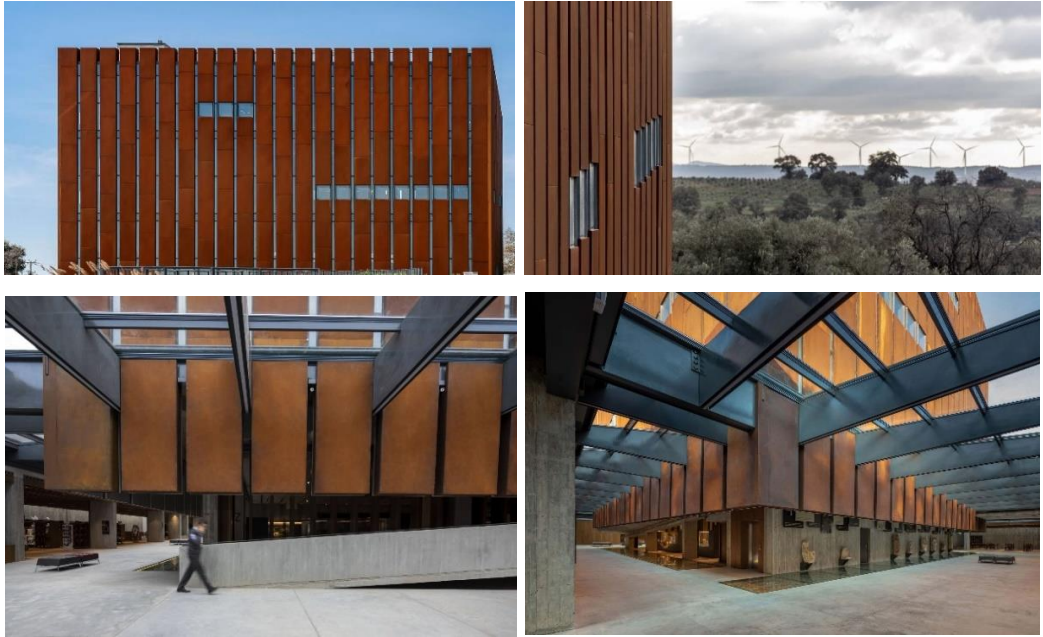
Şekil 3. 17. Troya Müzesi corten çelik panel kullanımı (Kuyrukçu, 2021)
