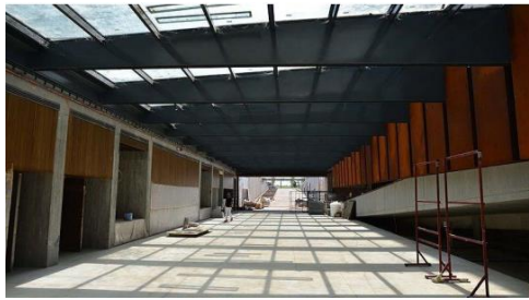
Şekil 3. 6. Troya Müzesi zemin kat girişi (Kuyrukçu, 2021)
