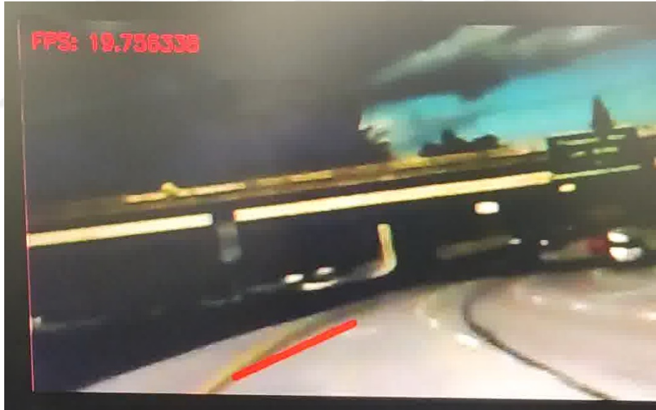
Şekil 4.7 Asfaltı yenilenmiş yol görüntüsünün çıkışı
