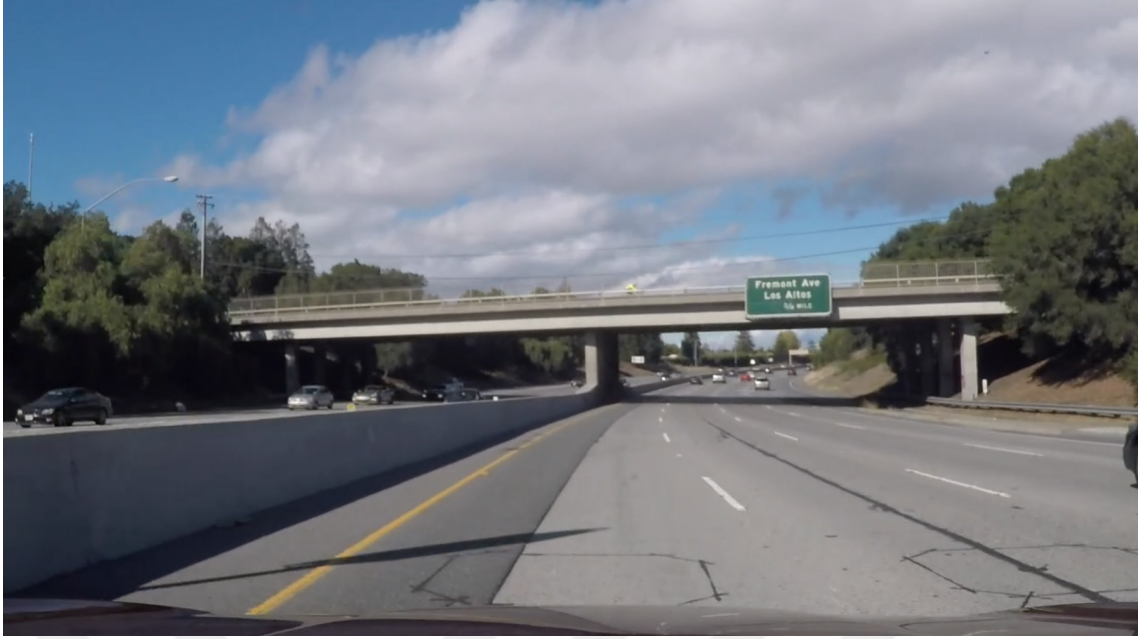
Şekil 4.6 Eski ve yeni asfaltın bulunduğu yol görüntüsü
