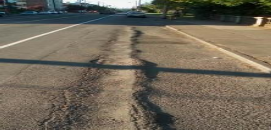
Şekil 2.18 Tekerlek izi oluşumu (Kırbaş, H.,1999).
