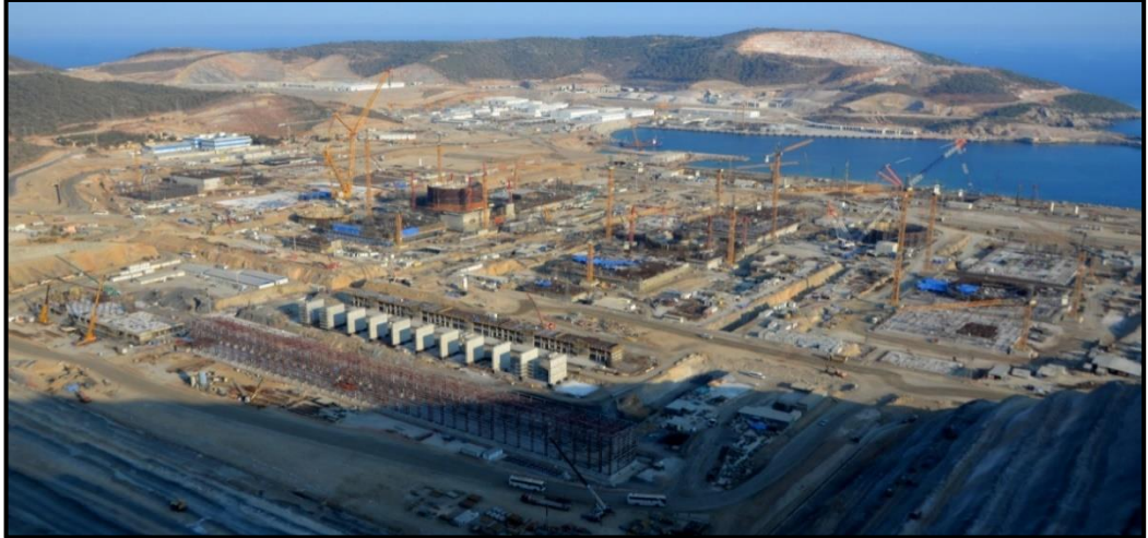
Şekil 4.8: Akkuyu Nükleer Güç Santrali Projesi Devam Eden İnşaatı.
