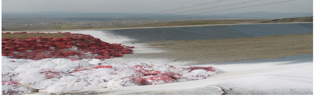
Şekil 4.2. Harmandalı Düzenli Atık Depolama Tesisinde tıbbi atıkların bertarafı (İBB, 2011a).
