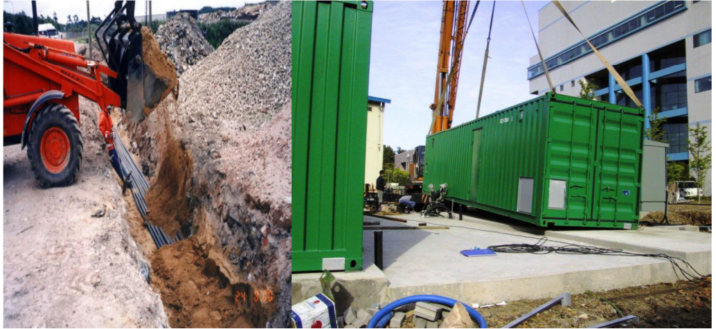
Şekil 5.15 ve Şekil 5.16. Gaz borularının pompa ve düzenleyici konteynerine bağlanması ve bağlantıdan sonraki görüntüsü (Terraza and Willumsen, 2009).
