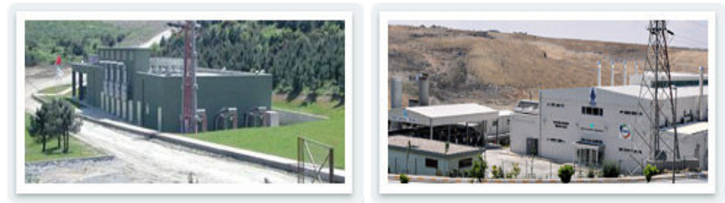
Şekil 2.1. Odayeri ve Kömürcüoda deponi gazından elektrik üretim tesisleri (İstaç, 2011).
