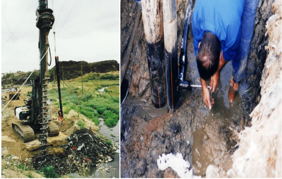
Şekil 5.13. Gaz kuyularının sondajla açılması. Şekil 5.14. Gaz borusunun yatay gaz toplama boruları bağlantısı (Terraza and Willumsen, 2009).
