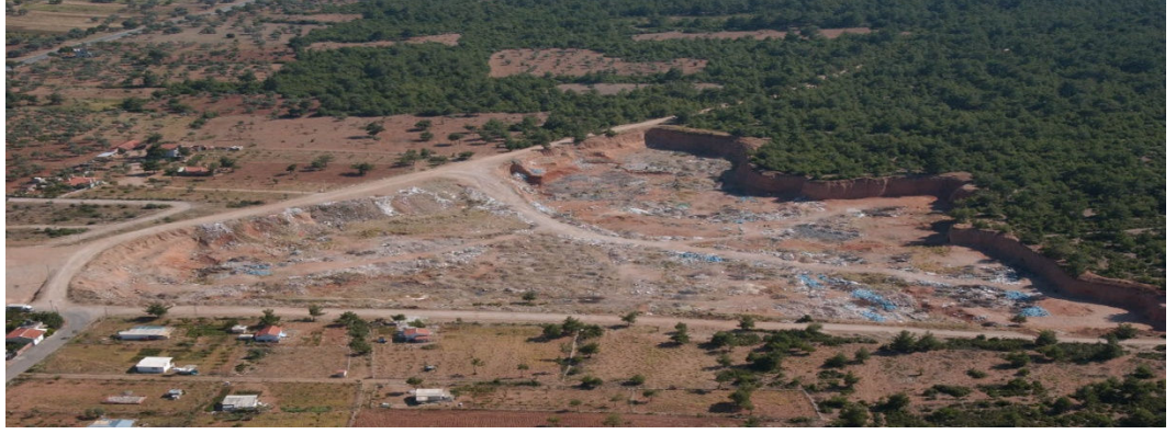
Şekil 4.9. Buca-Kırklar hafriyat toprağı ve inşaat/yıkıntı atıkları depolama alanı, (İBB, 2011a).
