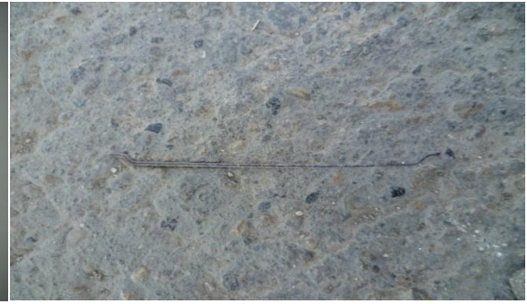
Resim 2.2. Kancalı lifin beton içinde görüntüsü
