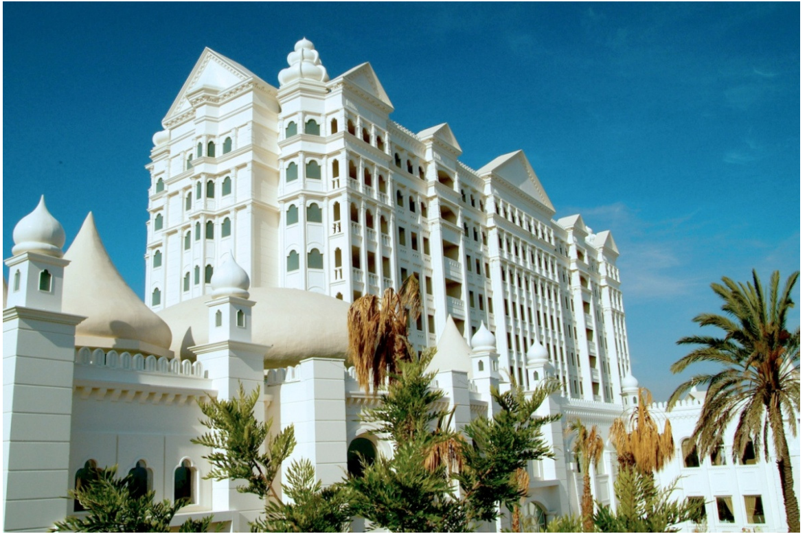
Şekil 4.9. Dış cephe uygulaması bitirilmiş otel yapısı
