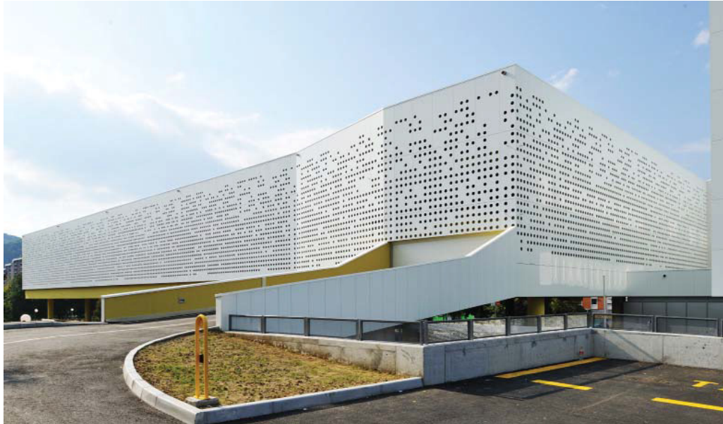
Şekil 4.25. Otopark fibercement uygulama örneği
