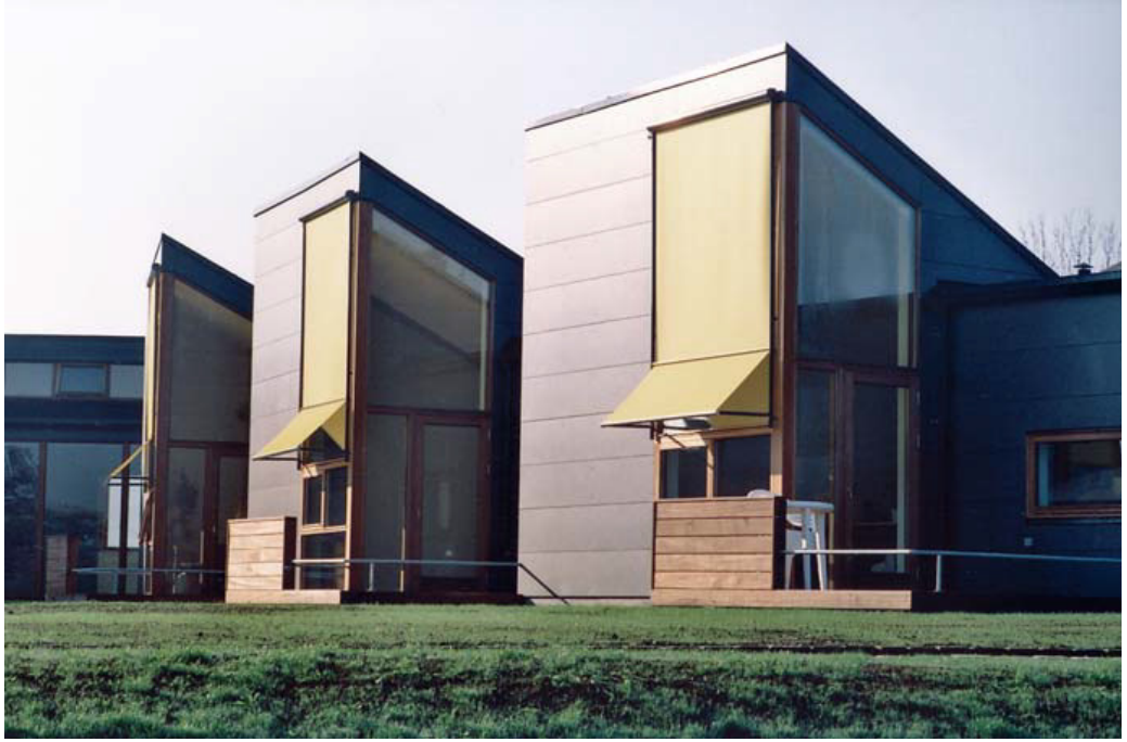
Şekil 4.32. Yurtdışı fibercement uygulama örneği
