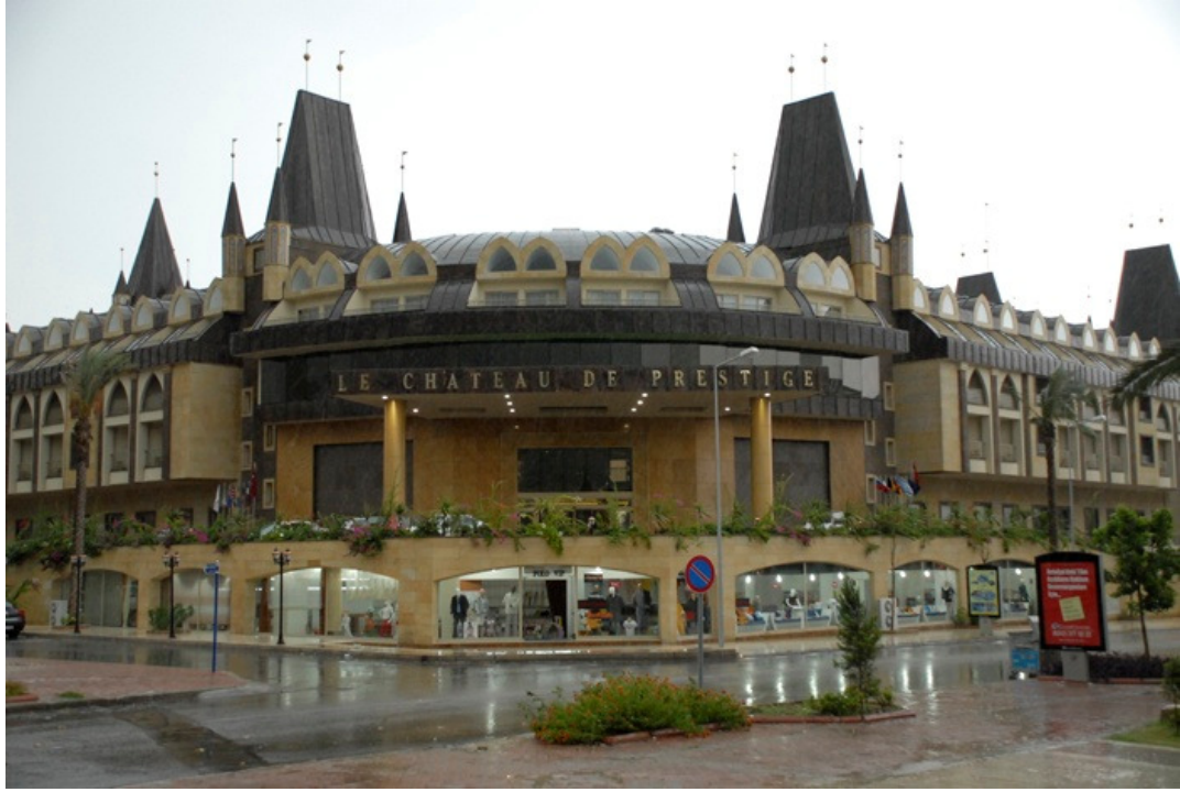
Şekil 4.28. Yurtdışı fibercement uygulama örneği
