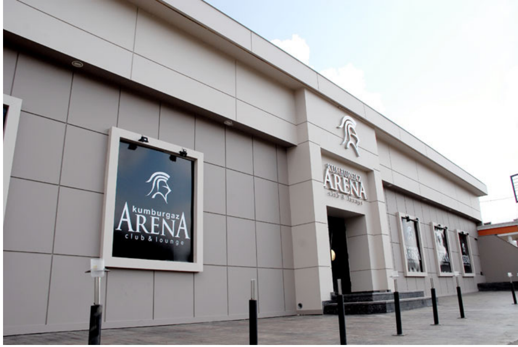
Şekil 4.18. Bitirilmiş eğlence mekânı dış cephe uygulaması
