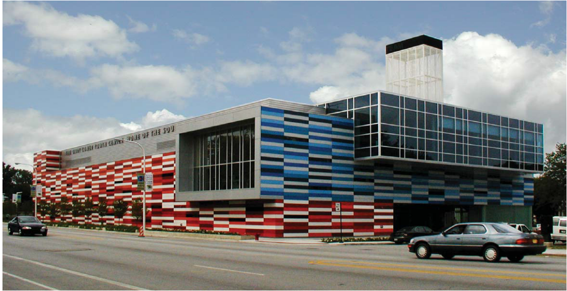
Şekil 4.21. Yurtdışı fibercement uygulama örneği
