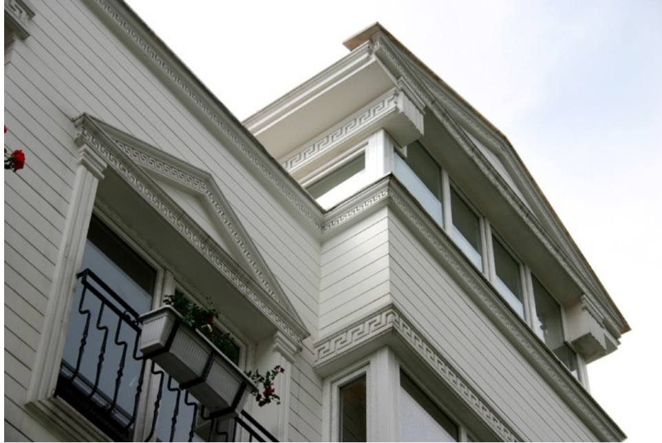
Şekil 4.15. Dış cephe uygulaması bitmiş müstakil ev uygulaması
