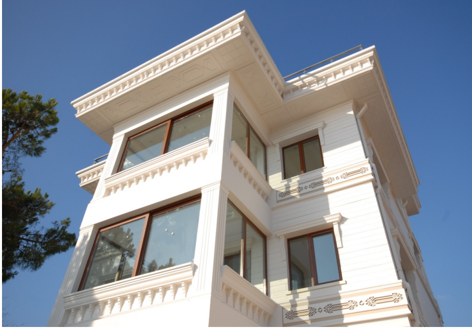
Şekil 4.14. Dış cephe uygulaması bitmiş müstakil ev uygulaması
