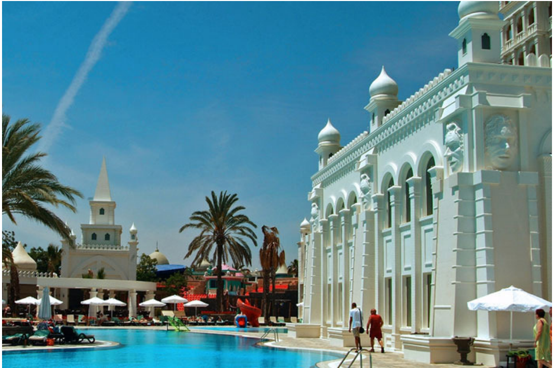
Şekil 4.19. Bitirilmiş otel dış cephe uygulaması
