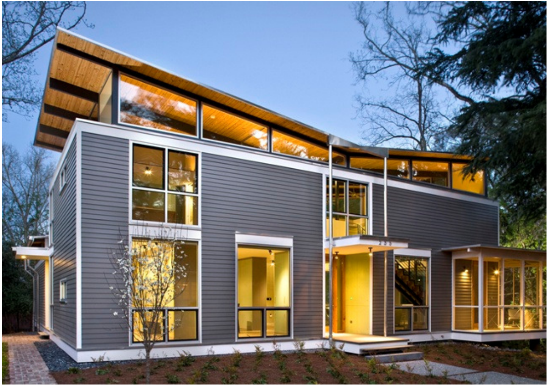
Şekil 4.31. Yurtdışı fibercement uygulama örneği
