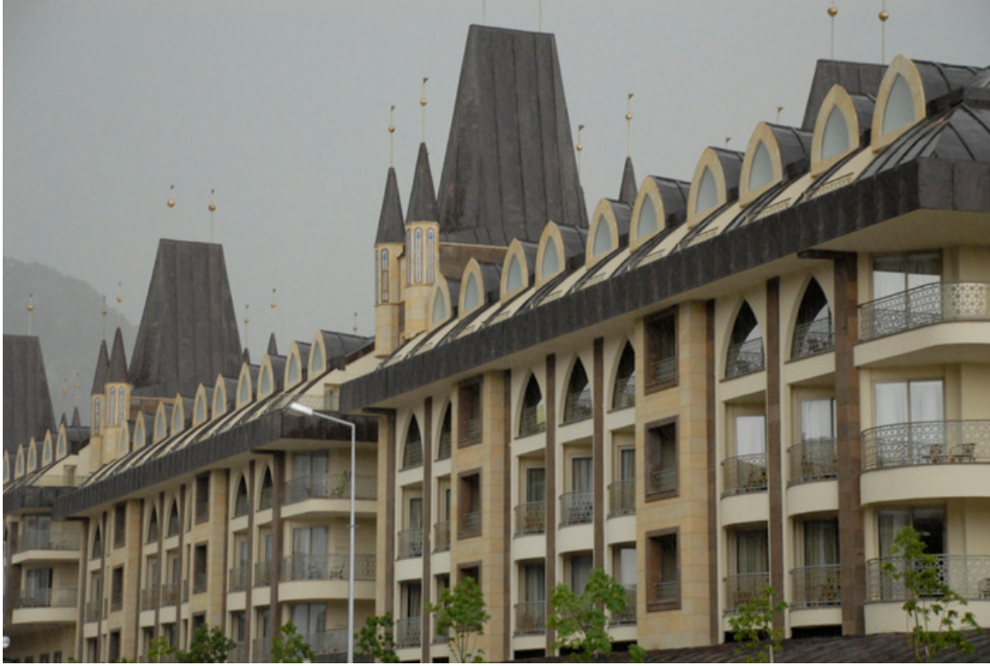
Şekil 4.34. Yurtdışı fibercement uygulama örneği
