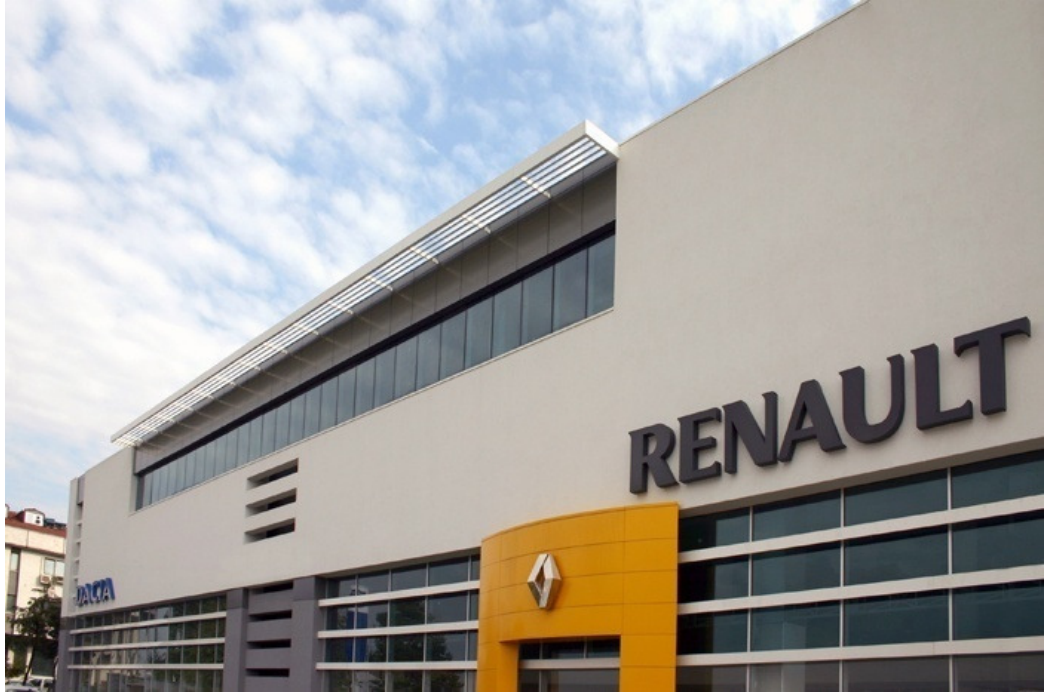
Şekil 4.16. Bitirilmiş işyeri dış cephe uygulaması
