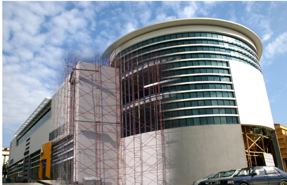
Şekil 4.17. Bitirilmiş işyeri dış cephe uygulaması
