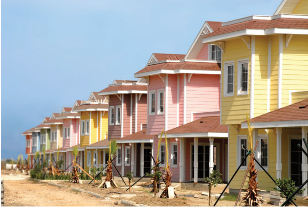
Şekil 4.26. Yurtdışı fibercement uygulama örneği
