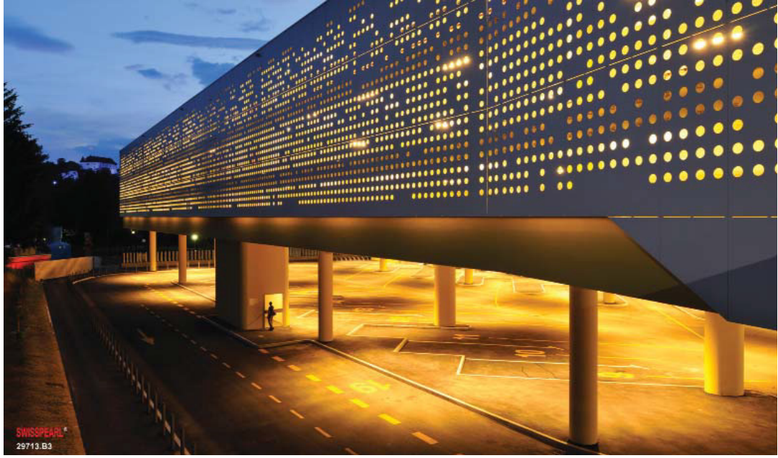
Şekil 4.20. Otopark dış cephe uygulaması
