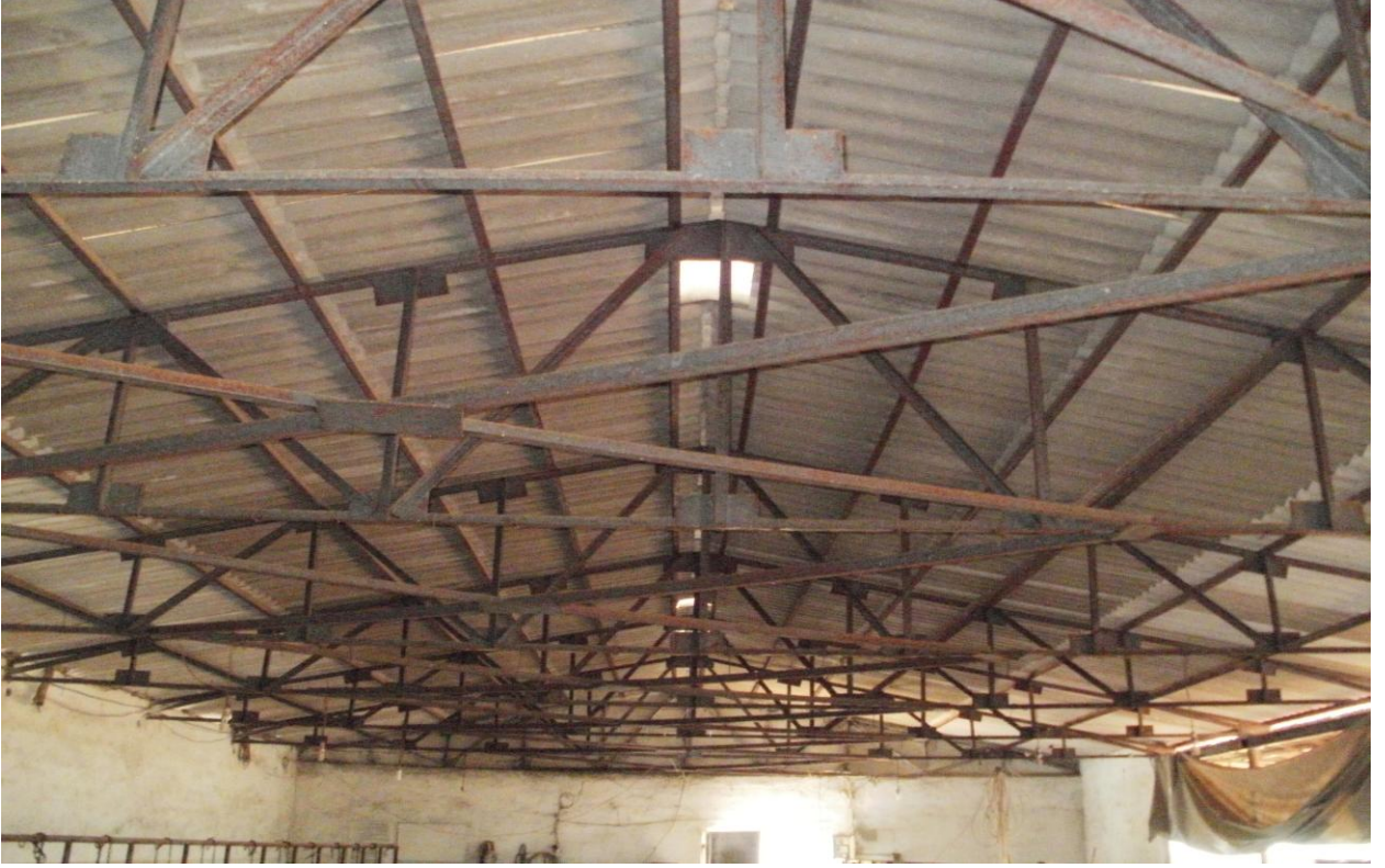
Şekil 4.2. Çatı makasında çelik konstrüksiyon kullanılan barınağın görünüşü (2012).
