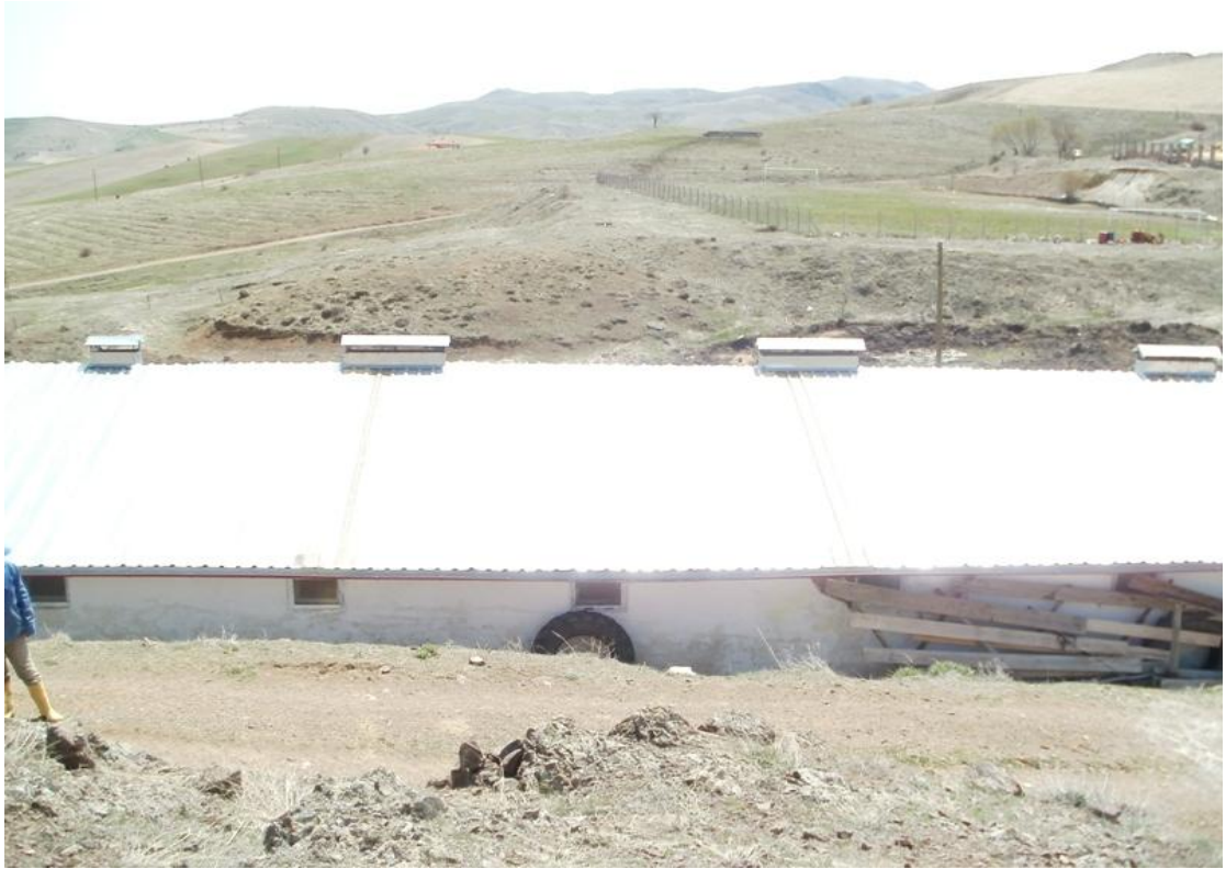
Şekil 4.4. Havalandırma'da dikdörtgen şeklinde bacaların kullanıldığı barınaktan bir görünüş (2012).
