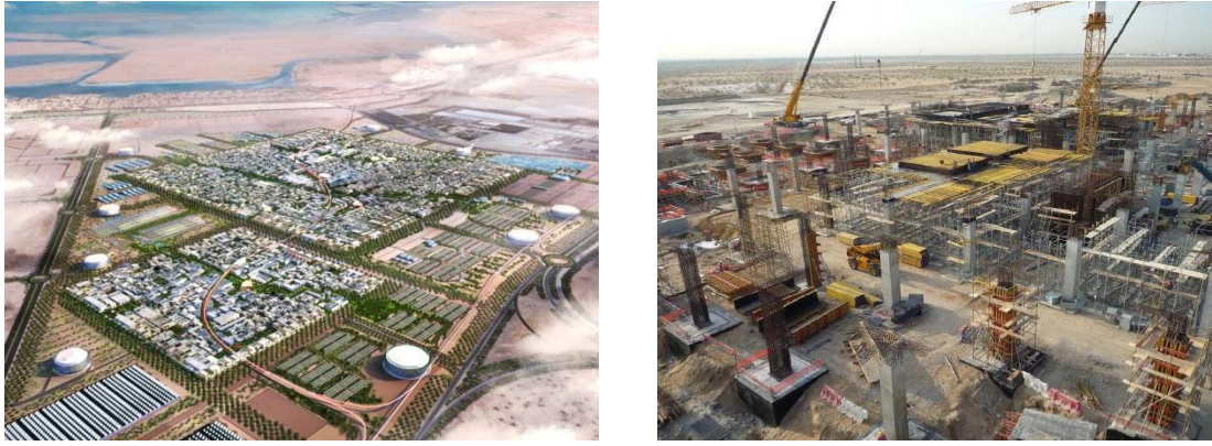
Şekil 3.7 Masdar Şehri [8] ve İnşaatı [9]
