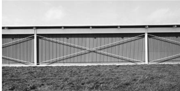
Şekil 2.5 Reliance Electronic Control Fabrikası (1967) [14]
