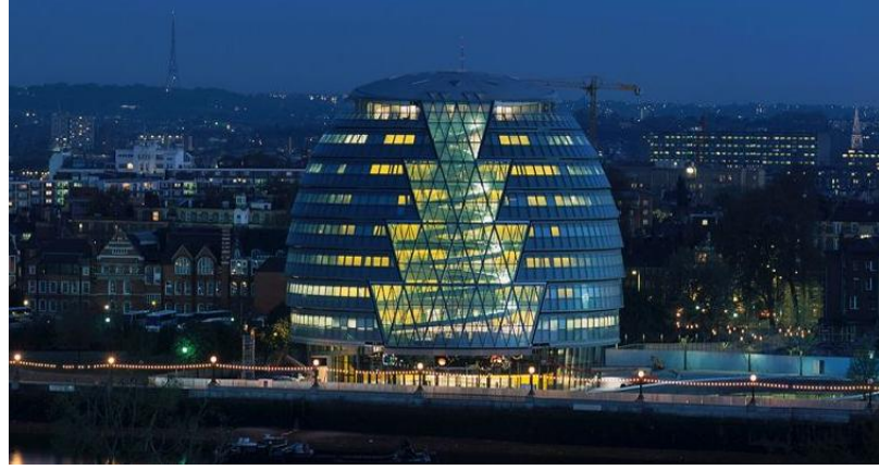
Şekil 4.1 City Hall (Londra Belediyesi Meclis Binası) [7]
