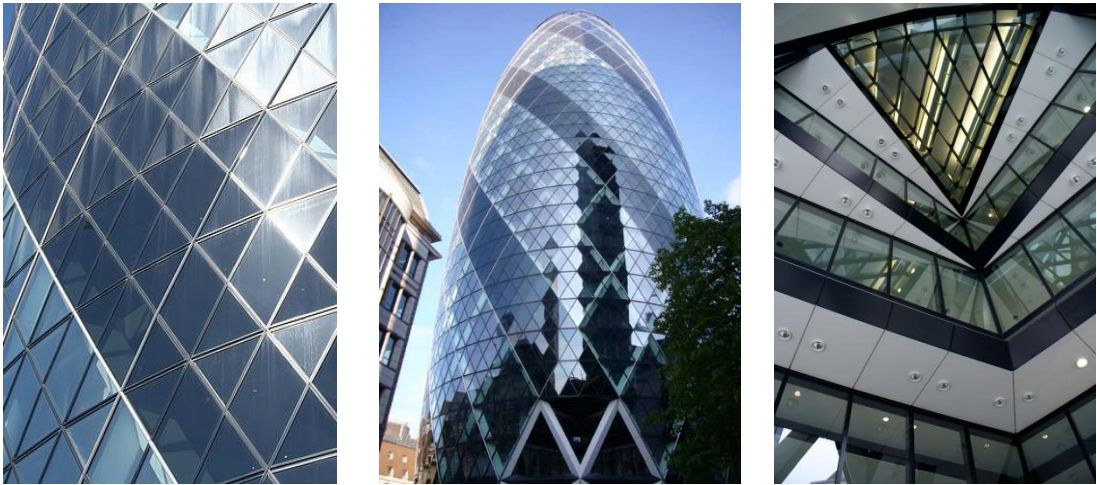
Şekil 4.12 Swiss Re Genel Merkezi Cephesindeki Spiral Bantlar ve Atrium [1]
