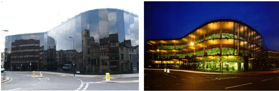
Şekil 2.10 Willis Faber Dumas Ofis Binası (1975) [19]
