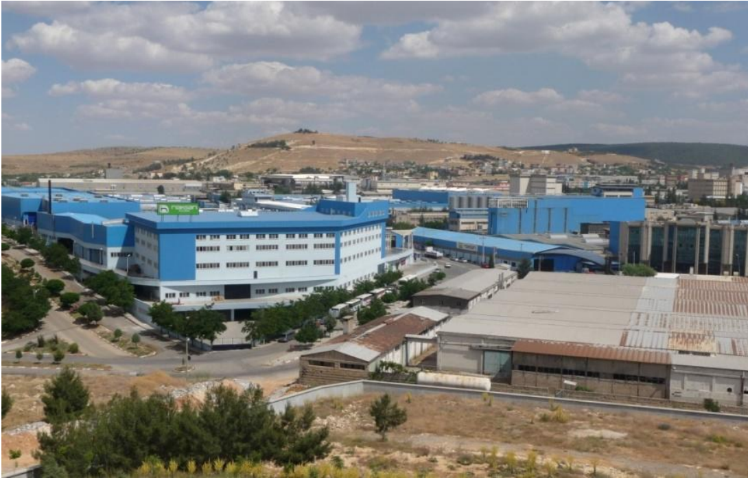
Foto 5.1. Gaziantep 1.OSB Naksan Holding Naksan-Plastik fabrikası genel görünüm
