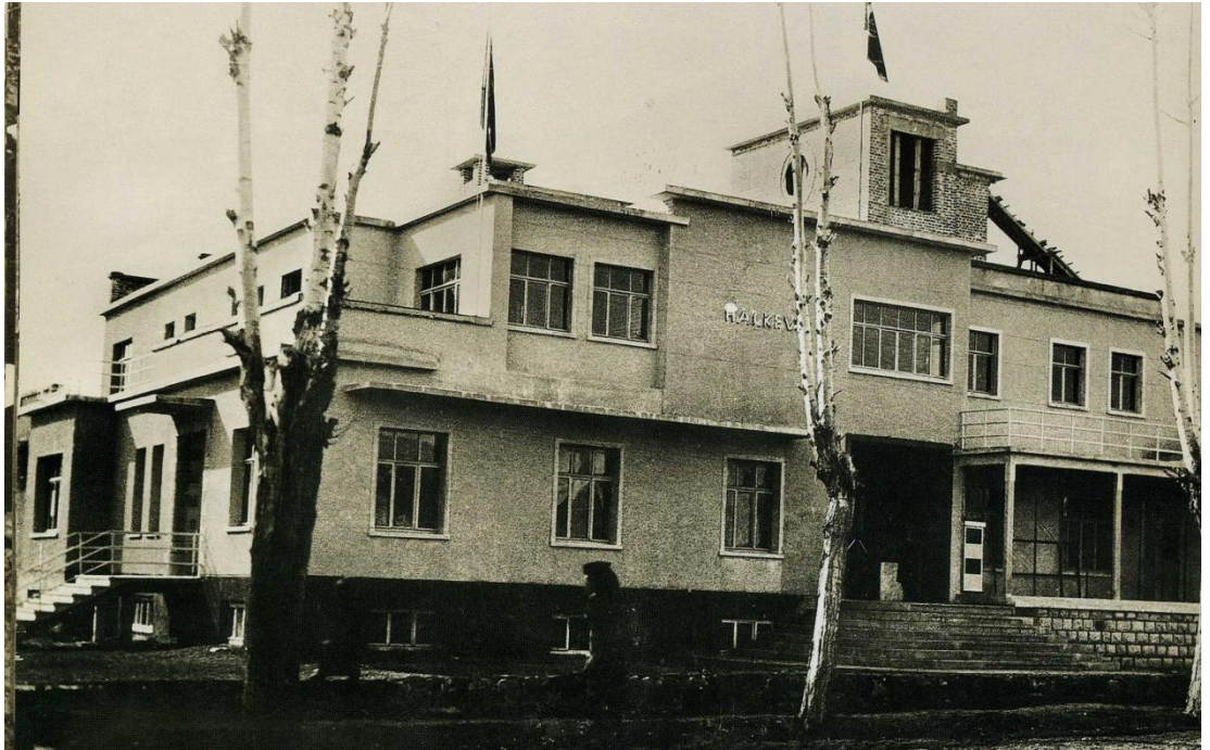
Depremden sonra yapılan Halkevi
