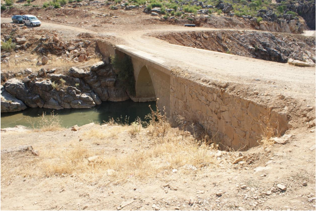
Resim 143: Sinek Köprüsü 2 üstten görünüş (Şafak KUTLAY)
