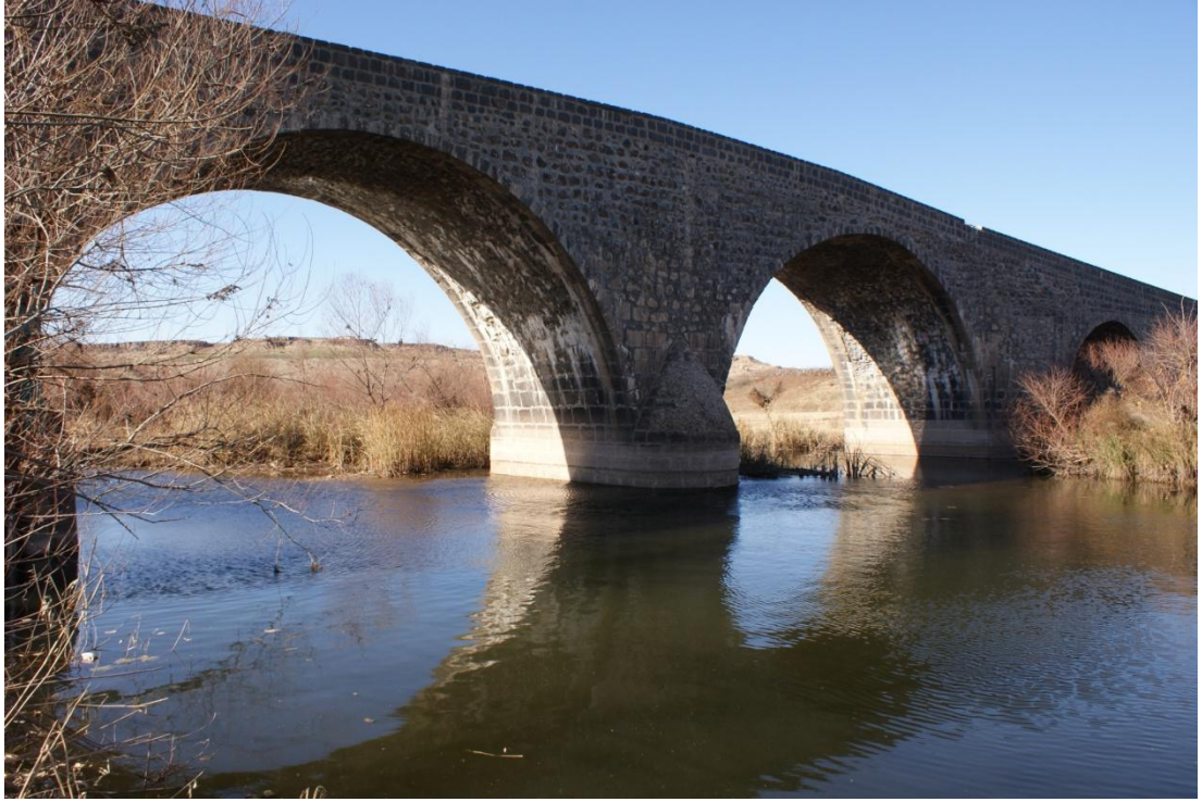
Resim 27: Devedgeçidi Köprüsü: Suyun aktığı taraftan selyaranlardan ayrıntı (Şafak Kutlay)
