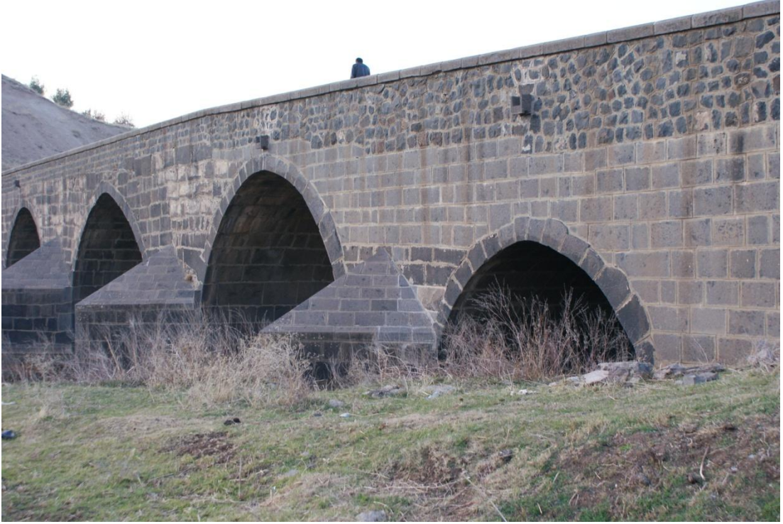
Resim 99: Kara Köprü: Suyun kaynak tarafından sağdan ilk üç göz sivri (Şafak Kutlay)
