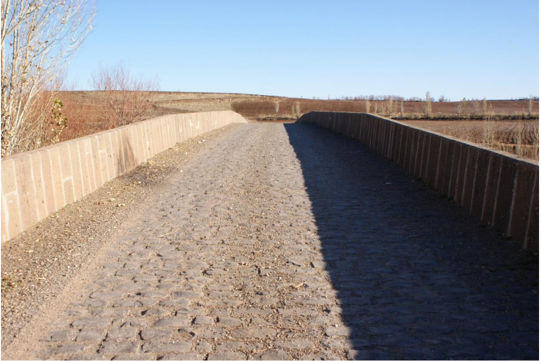
Resim 84: Halilviran (Artukoğulları) Köprüsü: Köprü üstü ve yolu (Şafak Kutlay)
