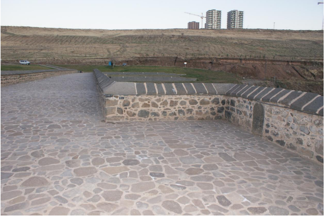
Resim 55: Dicle (Ongözlü Köprü) Köprüsü: Namazgâh (Şafak Kutlay)
