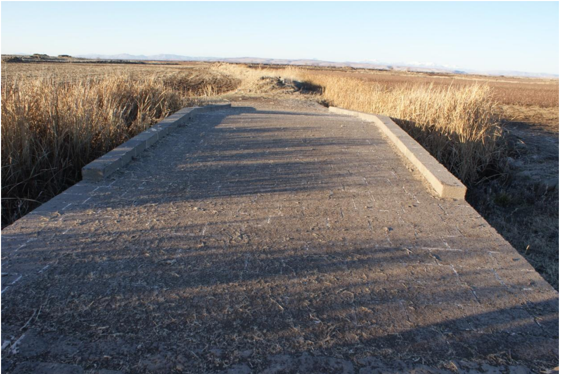
Resim 138: Sancak Köprüsü: Üstü düz
