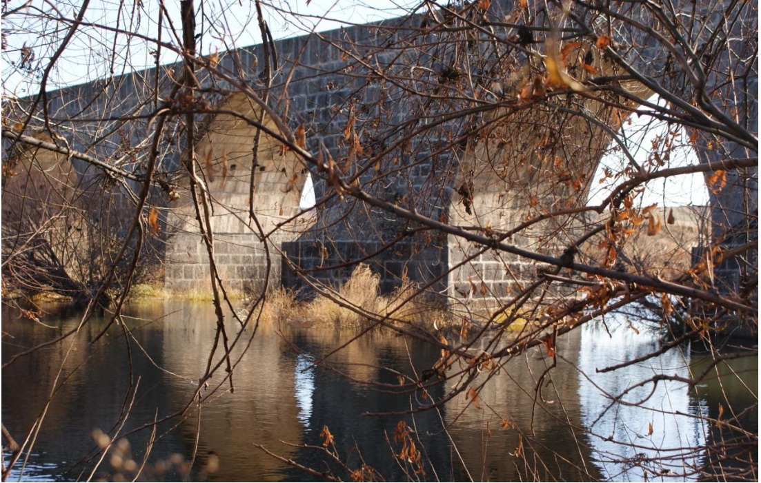
Resim 88: Halilviran (Artukoğulları) Köprüsü: Suyun aktığı taraf selyaranlar (Şafak Kutlay)
