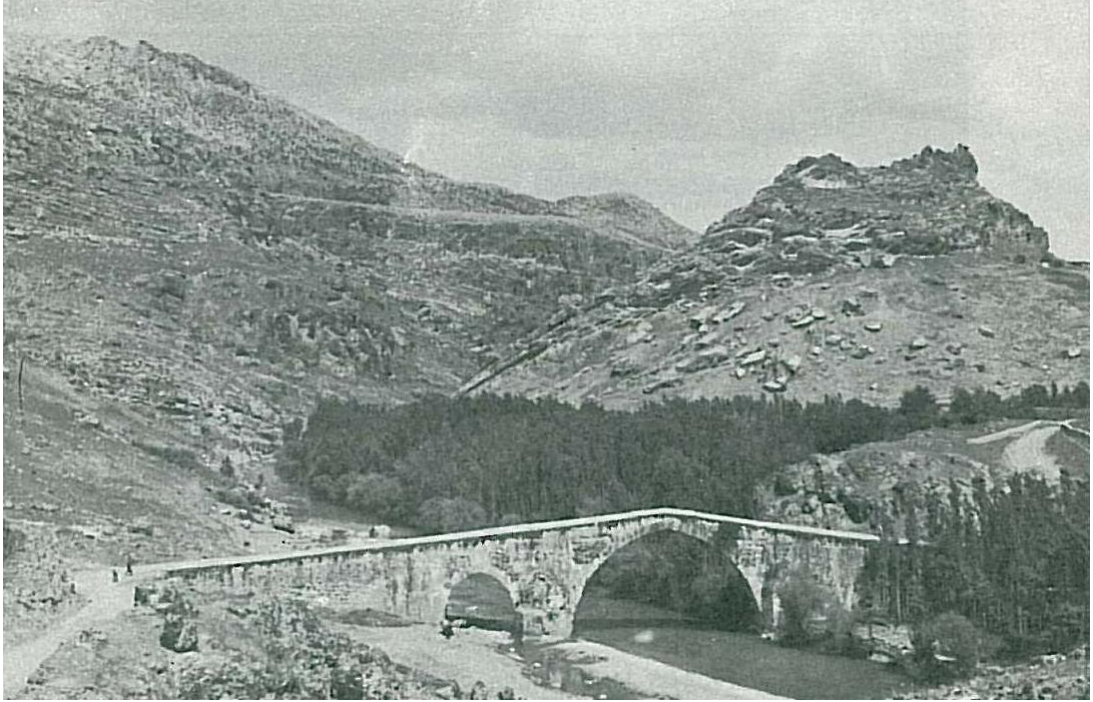
Resim 69: Haburman Köprüsü: köprü onarılmadan önce korkulukları yoktu (Fügen İlter)
