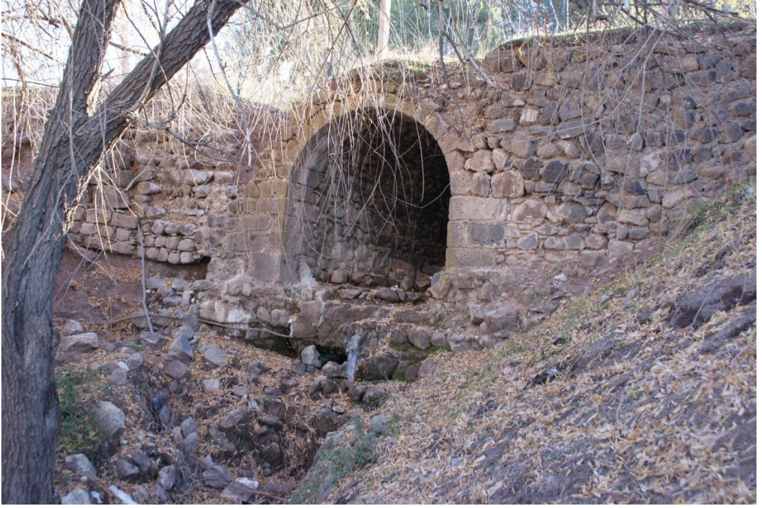
Resim 33: Devedeğidi Menfez Köprüsü: Suyun aktığı taraf (Şafak Kutlay)
