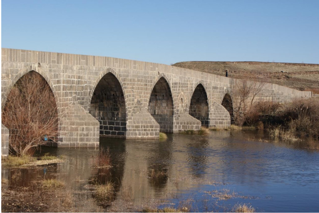
Resim 86: Halilviran (Artukoğulları) Köprüsü: Suyun kaynak tarafı selyaranlar (Şafak Kutlay)
