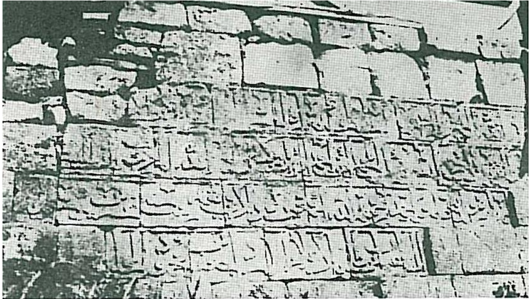
Resim 2: Ambarçayı Köprüsü: Yıkılmadan önce var olan kitabe (Fügen İlter)
