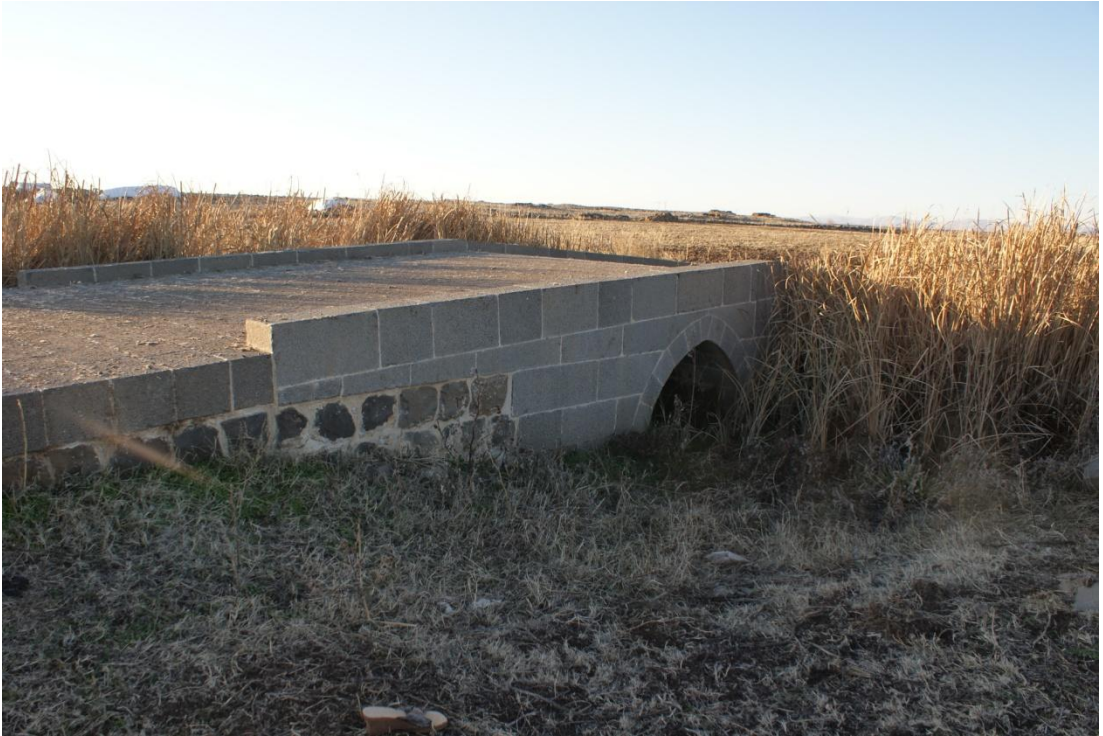
Resim 136: Sancak Köprüsü: Onarımdan Sonra
