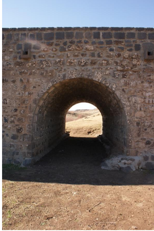
Resim 25: Devegeçidi Köprüsü: Kemerlerden ayrıntı (Şafak Kutlay)
