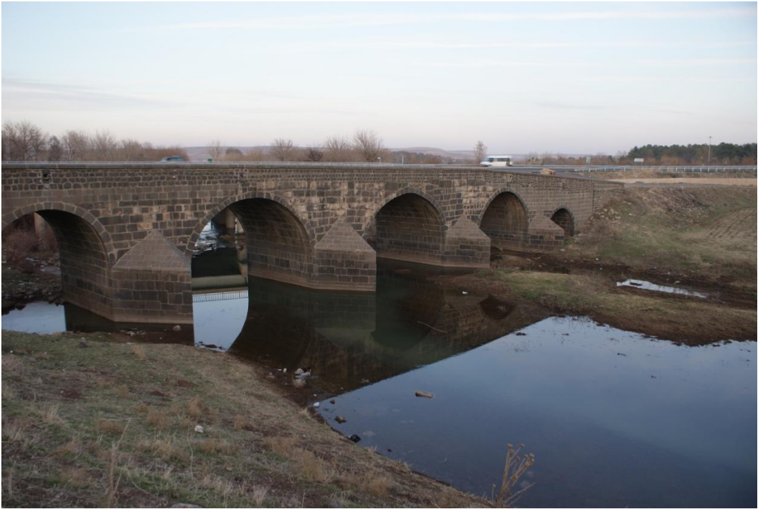
Resim 100: Kara Köprü: Suyun kaynak tarafı selyaranlar (Şafak Kutlay)
