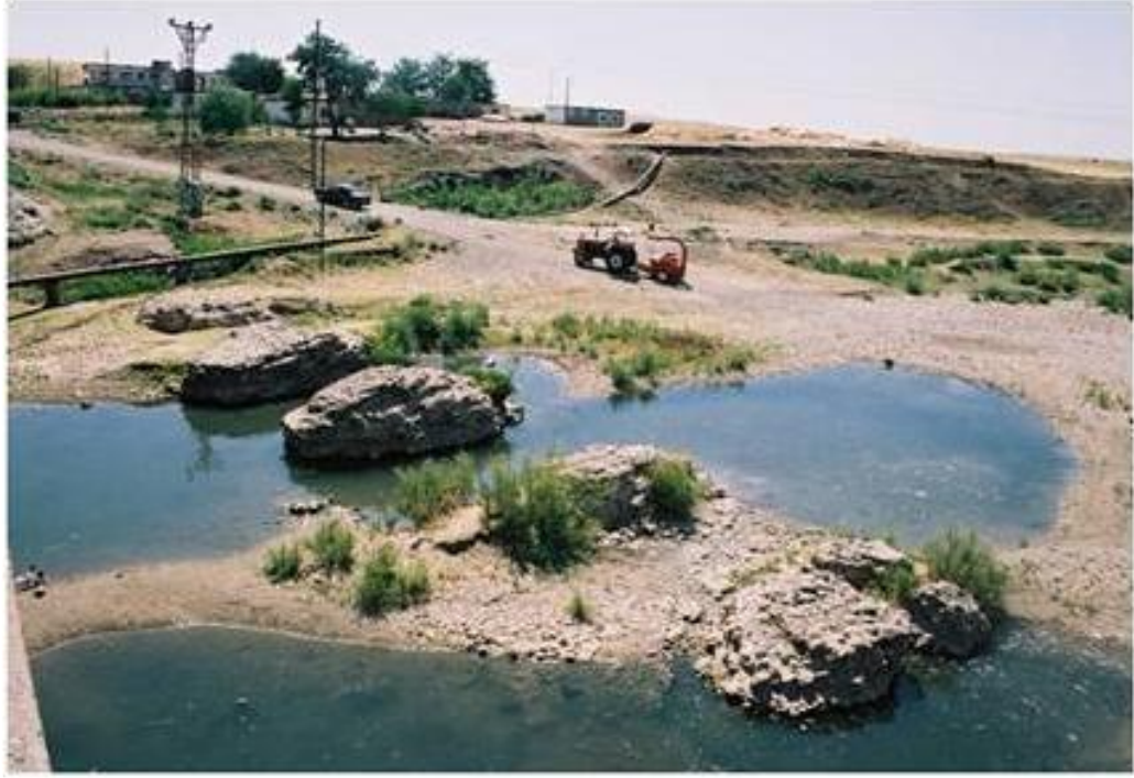
Resim 1: Ambarçayı Köprüsü: Kalıntılar (Dalkılıç, Halifeoğlu)
