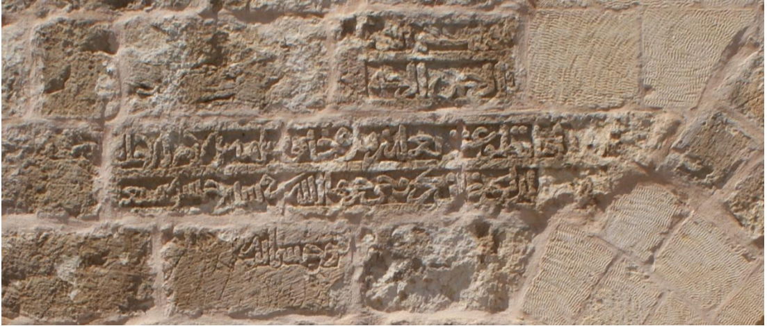
Resim 60: Haburman Köprüsü: Yapım kitabesi
