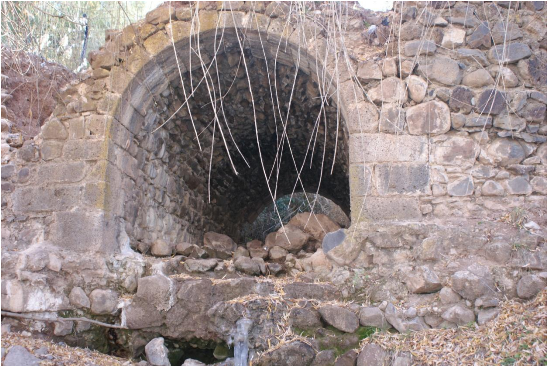
Resim 34: Devedeğidi Menfez Köprüsü: Suyun aktığı taraf kemer (Şafak Kutlay)
