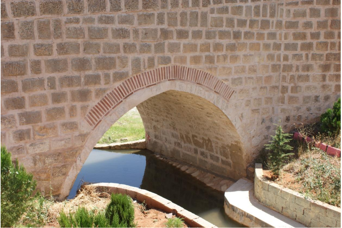
Resim 72: Haburman Köprüsü: Suyun kaynak tarafı tuğla kullanımı (Şafak Kutlay)
