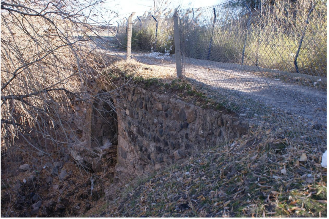
Resim 35: Devegeçidi Menfez Köprü: Üstten Görünüş (Şafak Kutlay)
