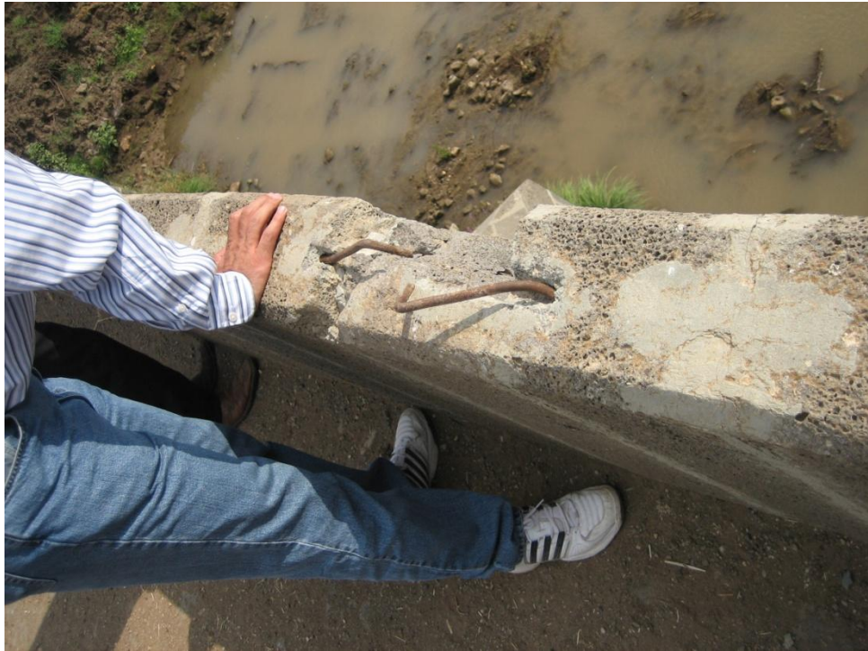
Resim 90: Halilviran (Artukoğulları) Köprüsü: Sonradan yapılan korkuluklar (Diyarbakır Kültür ve Tabiat Varlıklarını Koruma Bölge Kurulu Müdürlüğü Arşivi)
