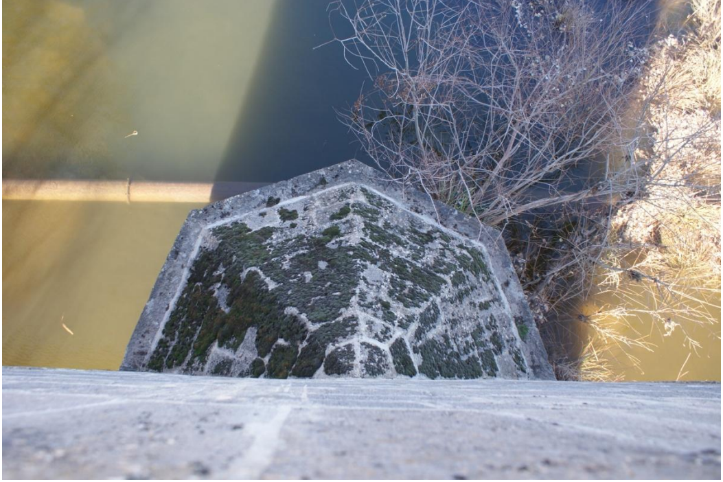
Resim 89: Halilviran (Artukoğulları) Köprüsü: Selyaran ayrıntı (Şafak Kutlay)
