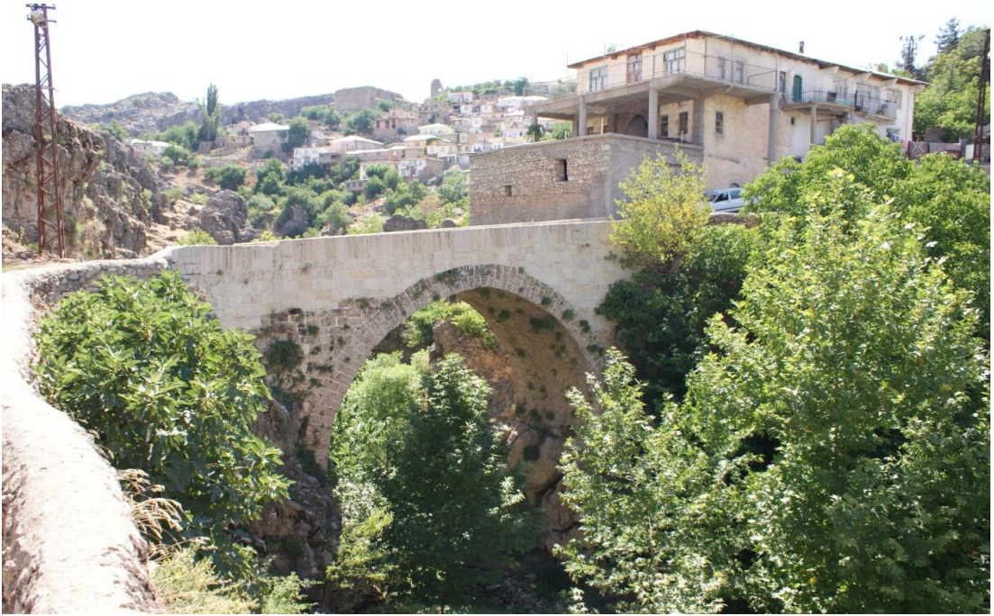
Resim 16: Çüngüş Köprüsü: Suyun kaynak tarafı bugünkü durumu (Şafak Kutlay)
