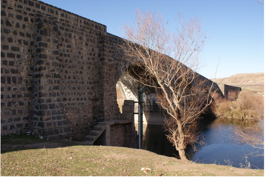
Resim 31: Devedeğidi Köprüsü: Suyun aktığı taraftaki destek duvarları (Şafak Kutlay)
