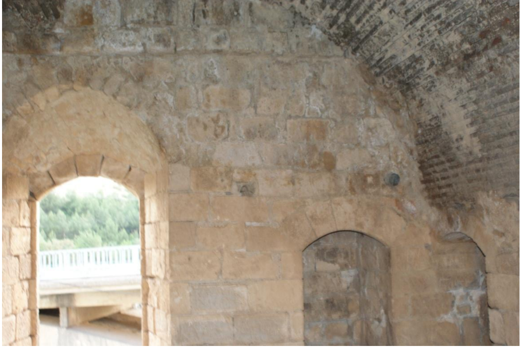
Resim 134: Malabadi(Batmansu) Köprüsü: Odalarda tuğla kullanımı(Şafak Kutlay)
