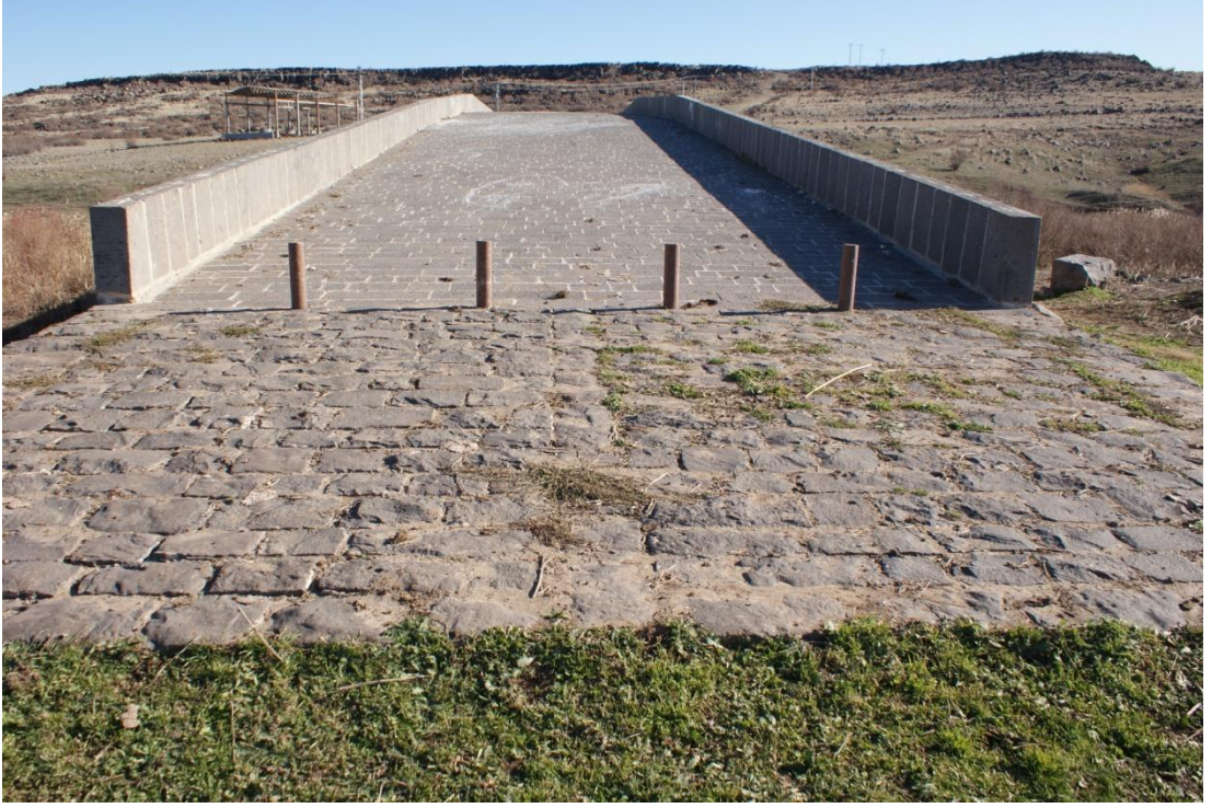
Resim 109: Karasu Köprüsü: Köprü üstü ve yolu (Şafak Kutlay)
