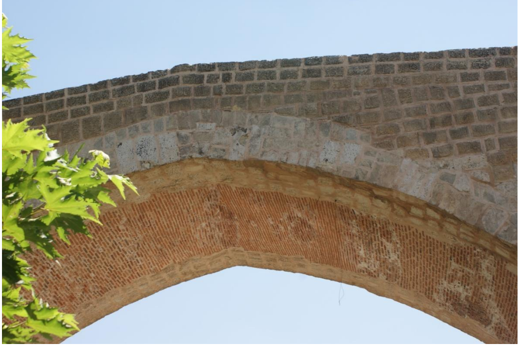
Resim 73: Haburman Köprüsü: Suyun kaynak tarafı ana kemerde tuğla kullanımı (Şafak Kutlay)
