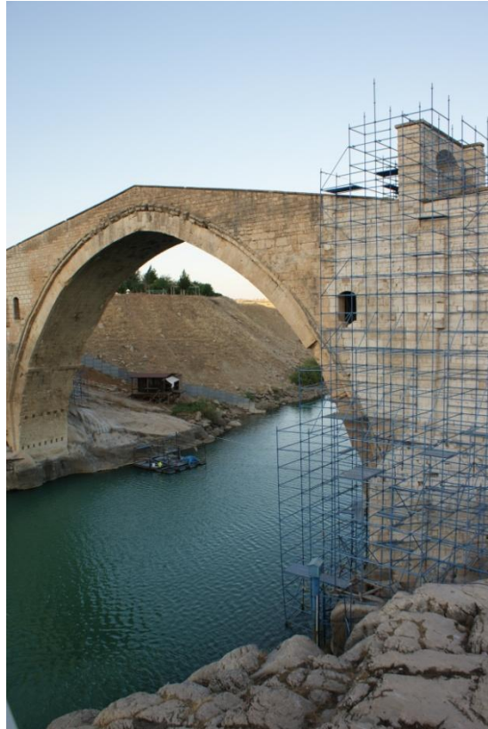
Resim 132: Malabadi(Batmansu) Köprüsü: Suyun kaynak tarafı selyaran(Şafak Kutlay)
