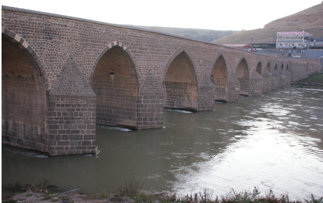
Resim 54: Dicle (Ongözlü Köprü) Köprüsü: Suyun kaynak tarafı selyaranlar (Şafak Kutlay)
