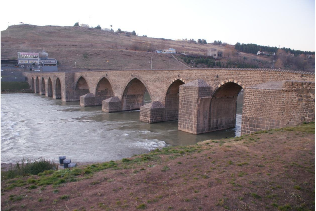
Resim 46: Dicle (Ongözlü Köprü) Köprüsü: Suyun aktığı taraf (Şafak Kutlay)
