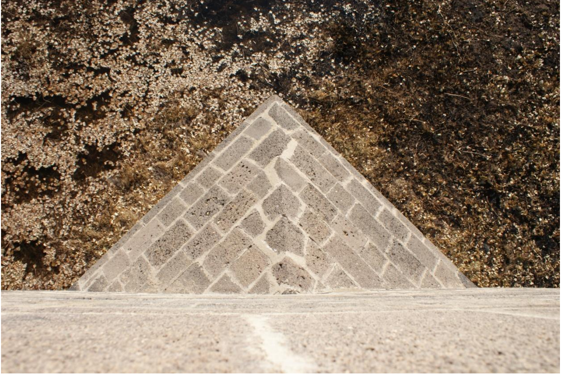
Resim 87: Halilviran (Artukoğulları) Köprüsü: Selyaran ayrıntı (Şafak Kutlay)
