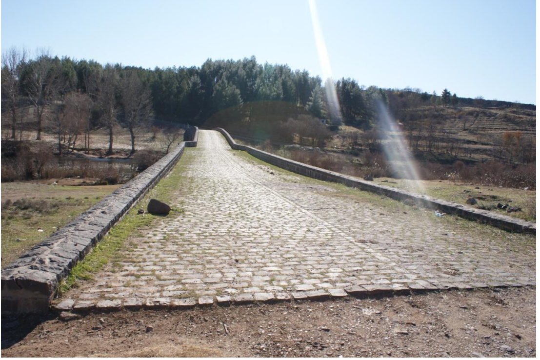
Resim 21: Devegeçidi Köprüsü: Köprünün üstü ve köprü yolu (Şafak Kutlay)
