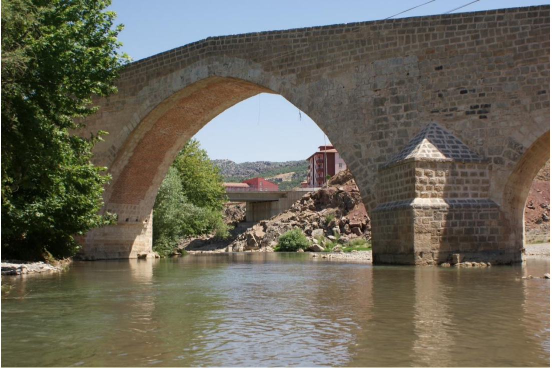
Resim 64: Haburman Köprüsü: Suyun kaynak tarafı soldan ikinci göz (Şafak Kutlay)
