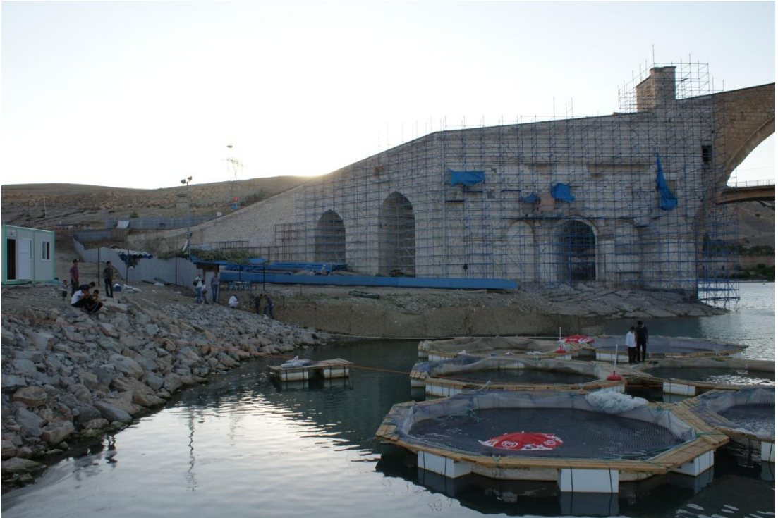
Resim 118: Malabadi(Batmansu) Köprüsü: Suyun aktığı taraf (Şafak Kutlay)
