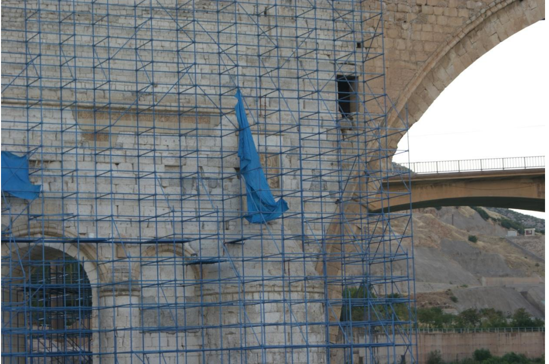
Resim 116: Malabadi(Batmansu) Köprüsü: Kitabe (Şafak Kutlay)
