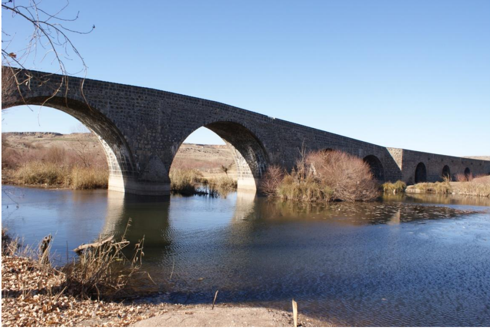
Resim 24: Devegeçidi Köprüsü: Suyun aktığı taraftan soldan sağa doğru gözlerin küçüldüğü görölüyor (Şafak Kutlay)
