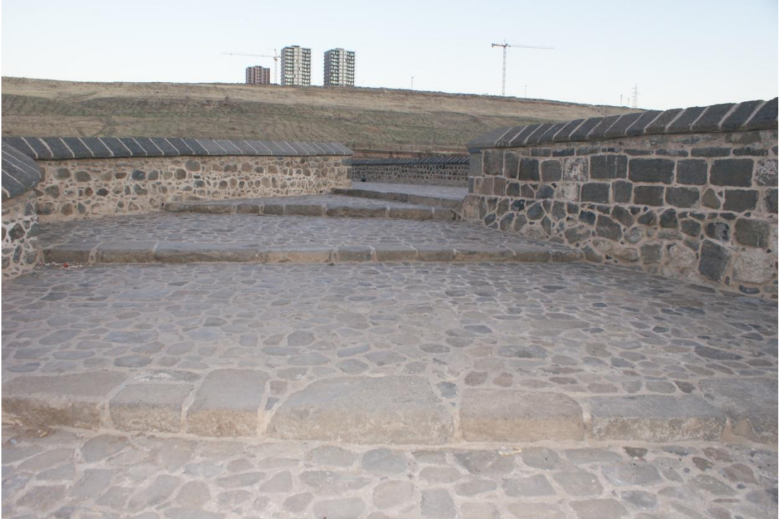
Resim 51: Dicle (Ongözlü Köprü) Köprüsü: Köprü korkuluğu (Şafak Kutlay)
