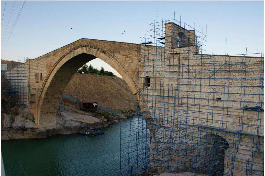
Resim 120: Malabadi(Batmansu) Köprüsü: Suyun kaynak tarafı (Şafak Kutlay)
