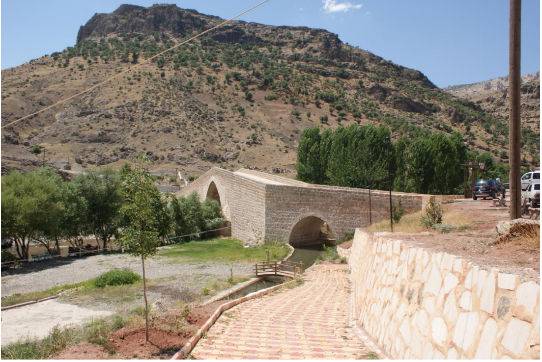
Resim 67: Haburman Köprüsü: Köprü kırılarak ilerliyor (Şafak Kutlay)
