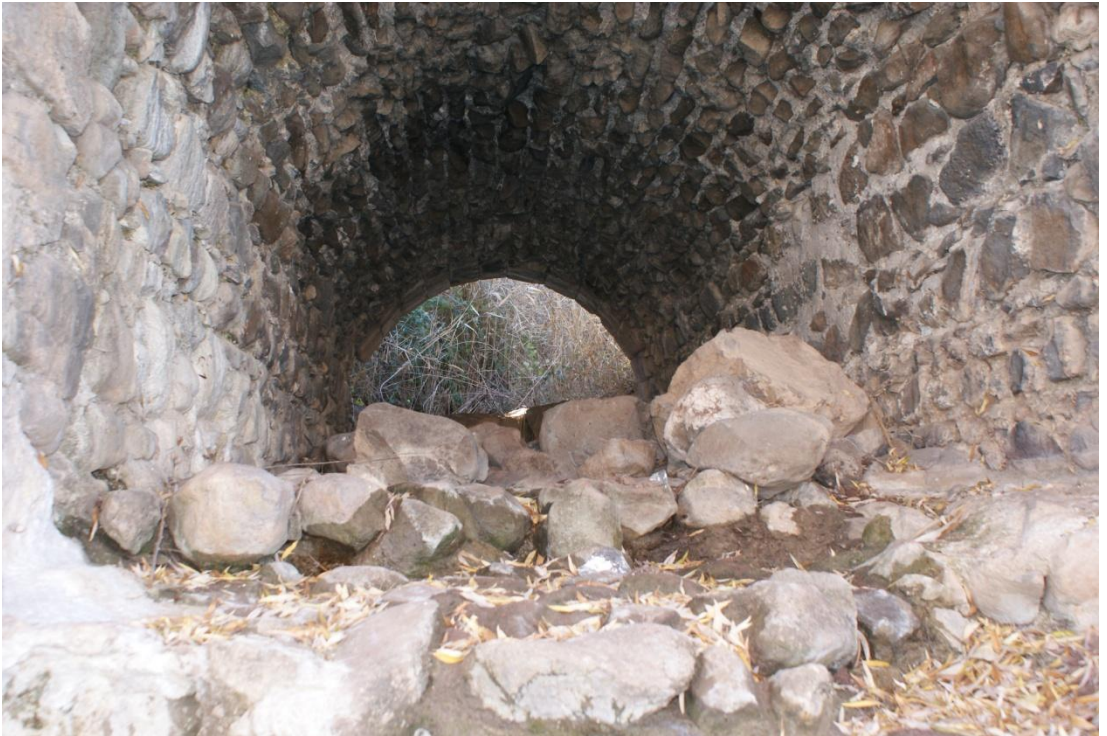
Resim 38: Devedeğidi Menfez Köprüsü: Kemer tonozu moloz taş kullanımı (Şafak Kutlay)
