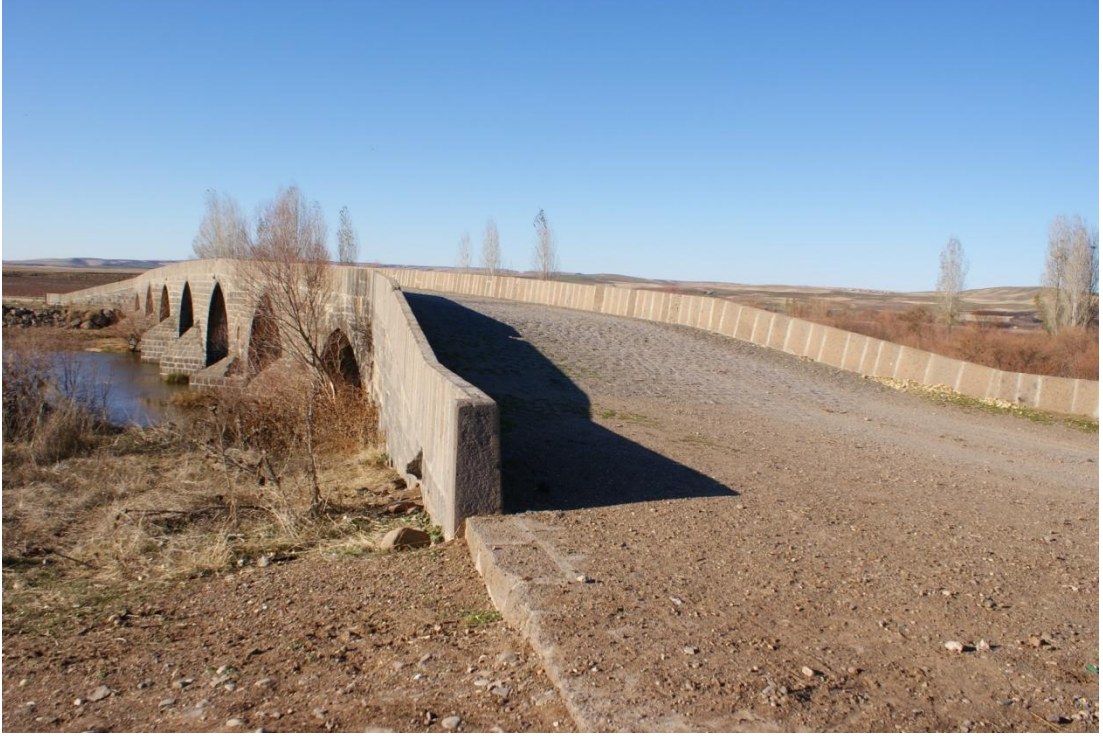
Resim 83: Halilviran (Artukoğulları) Köprüsü: Köprü üstü ve yolu (Şafak Kutlay)
