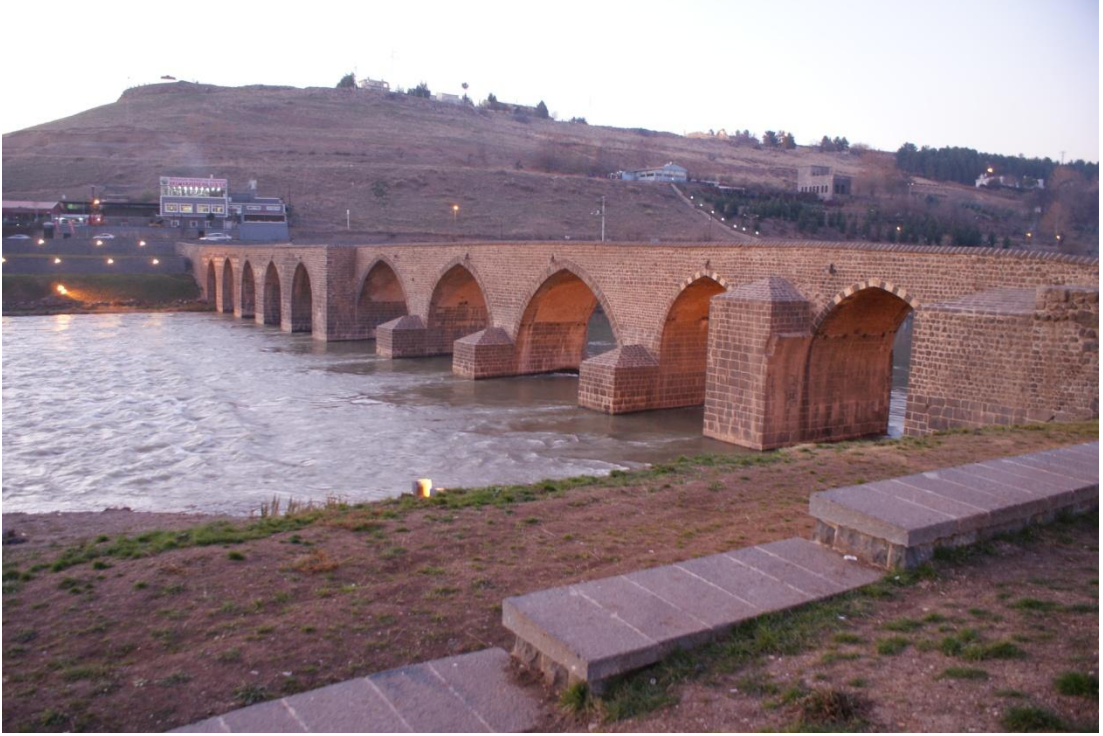
Resim 47: Dicle (Ongözlü Köprü) Köprüsü: Suyun aktığı taraf (Şafak Kutlay)
