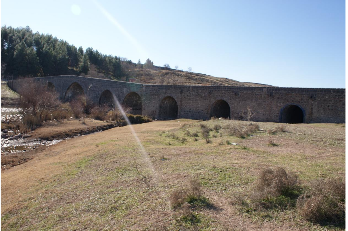
Resim 18: Devegeçidi Köprüsü: Suyun aktığı taraftan köprünün yedi gözü (Şafak Kutlay)
