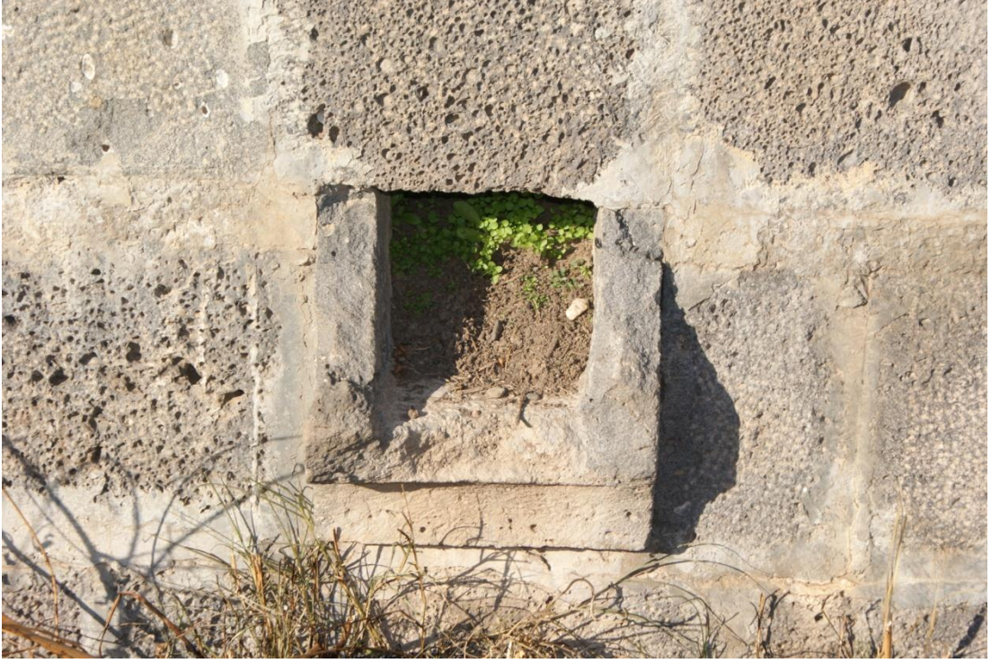
Resim 91: Halilviran (Artukoğulları) Köprüsü: Çörten örneği (Şafak Kutlay)
