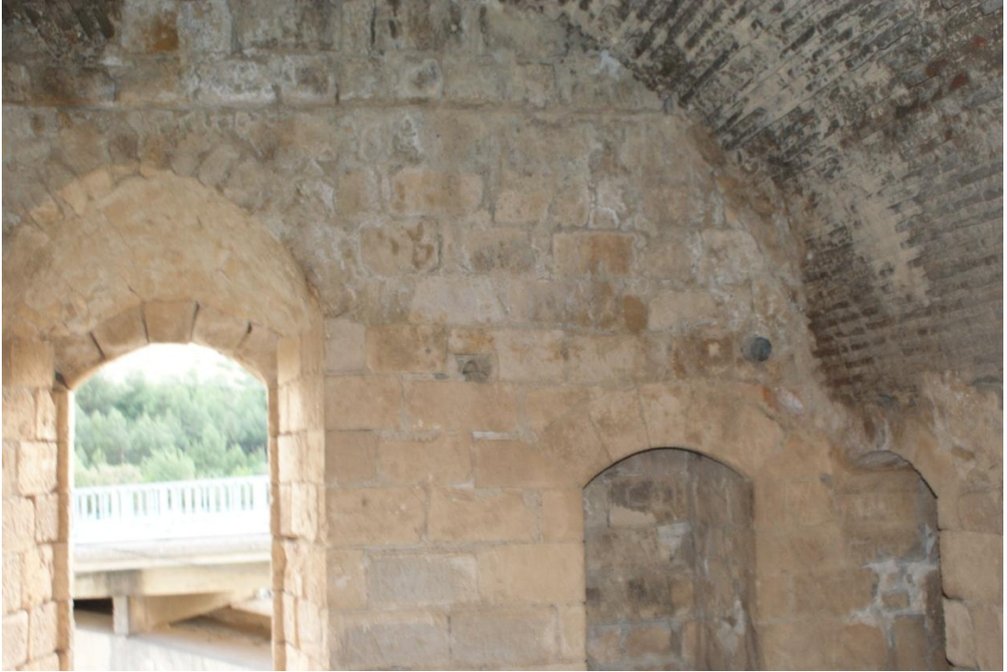
Resim 130: Malabadi(Batmansu) Köprüsü: Alt odalardan ayrıntı pencere ve nişler (Şafak Kutlay)
