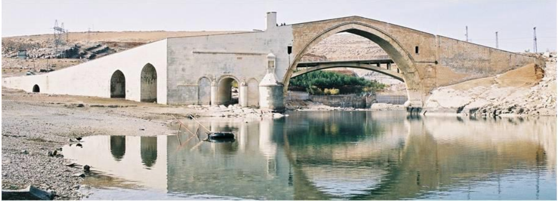
Resim 117: Malabadi(Batmansu) Köprüsü: Köprü gözleri (Dalkılıç, Halifeoğlu)
