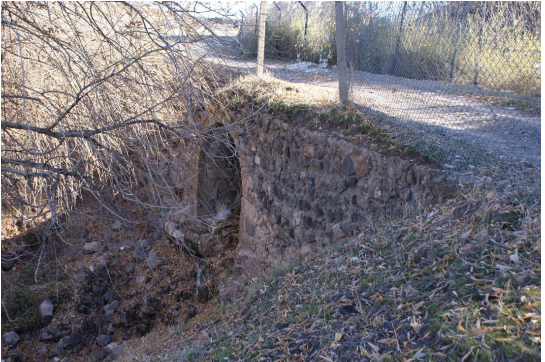
Resim 36: Devegeçidi Menfez Köprü: Üstten Görünüş (Şafak Kutlay)
