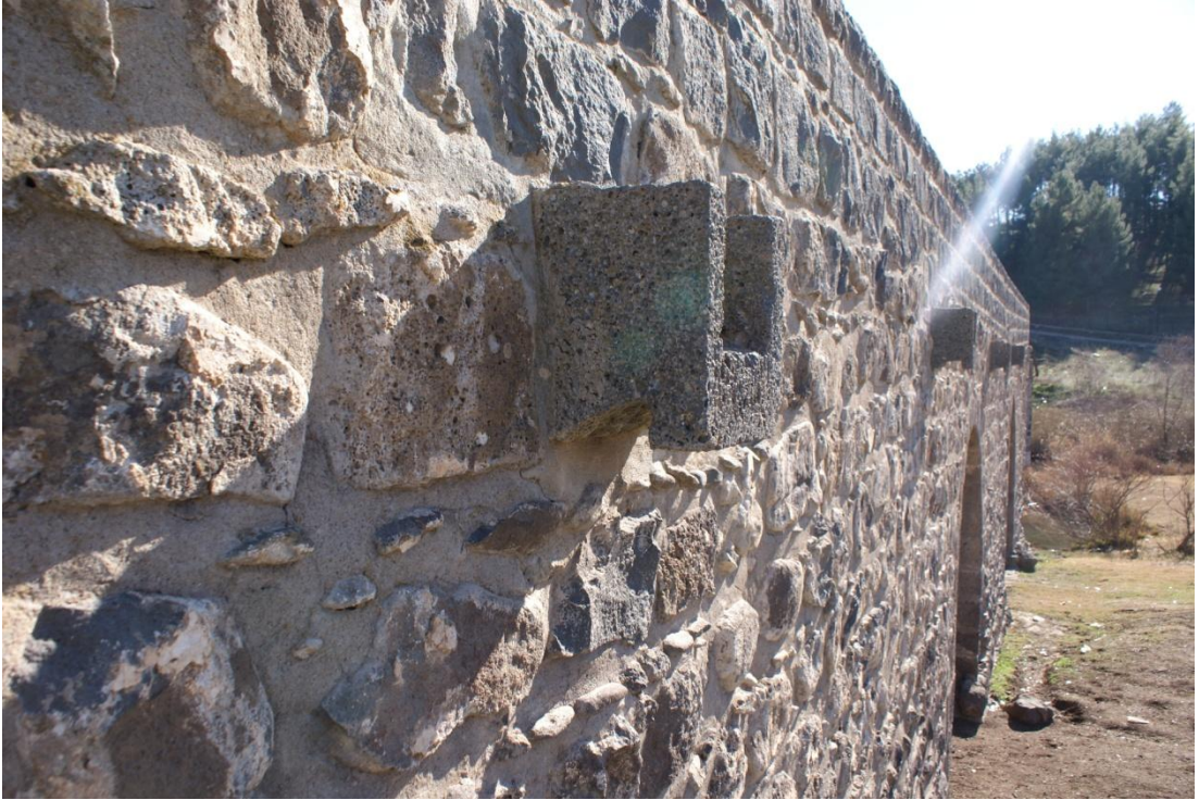
Resim 30: Devedgeçidi Köprüsü: Suyun kaynak tarafından çörteler (Şafak Kutlay)
