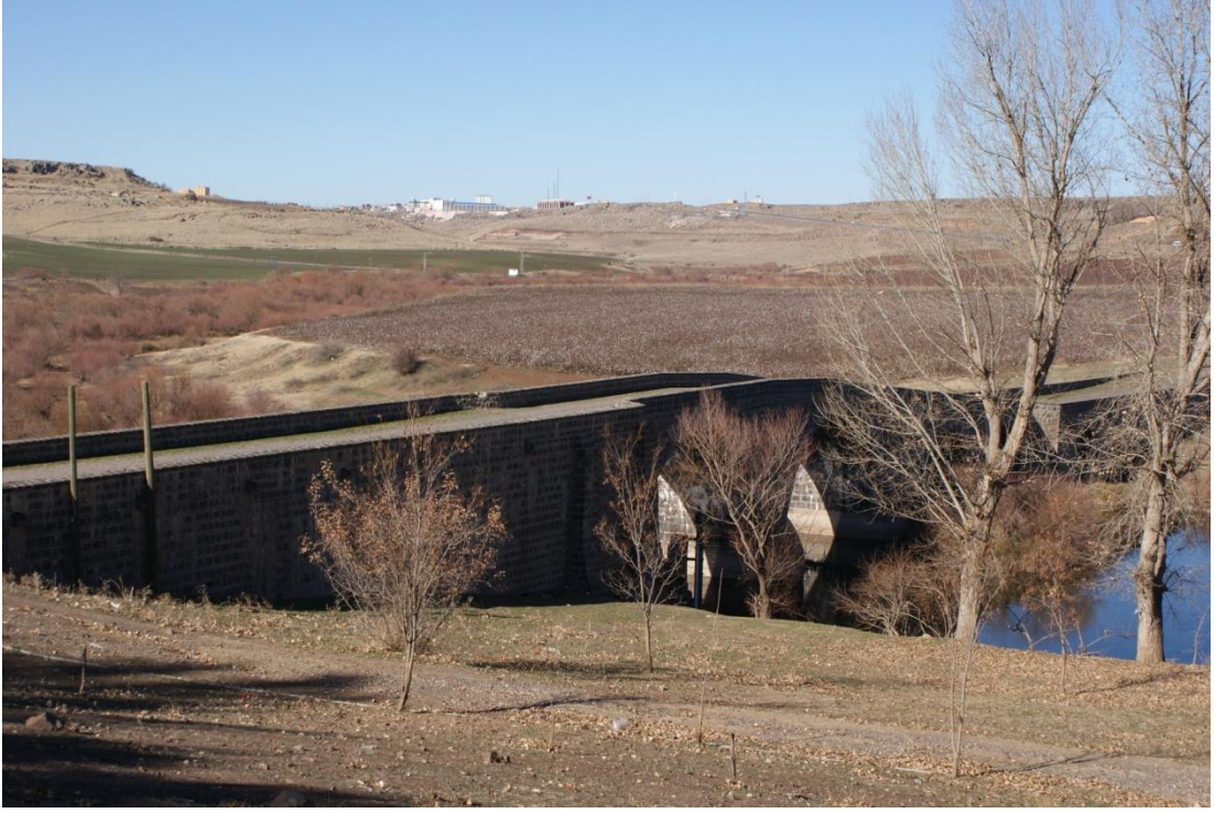
Resim 23: Devegeçidi Köprüsü: Köprü yolunun genişleyip darlaştığı görölüyor (Şafak Kutlay)
