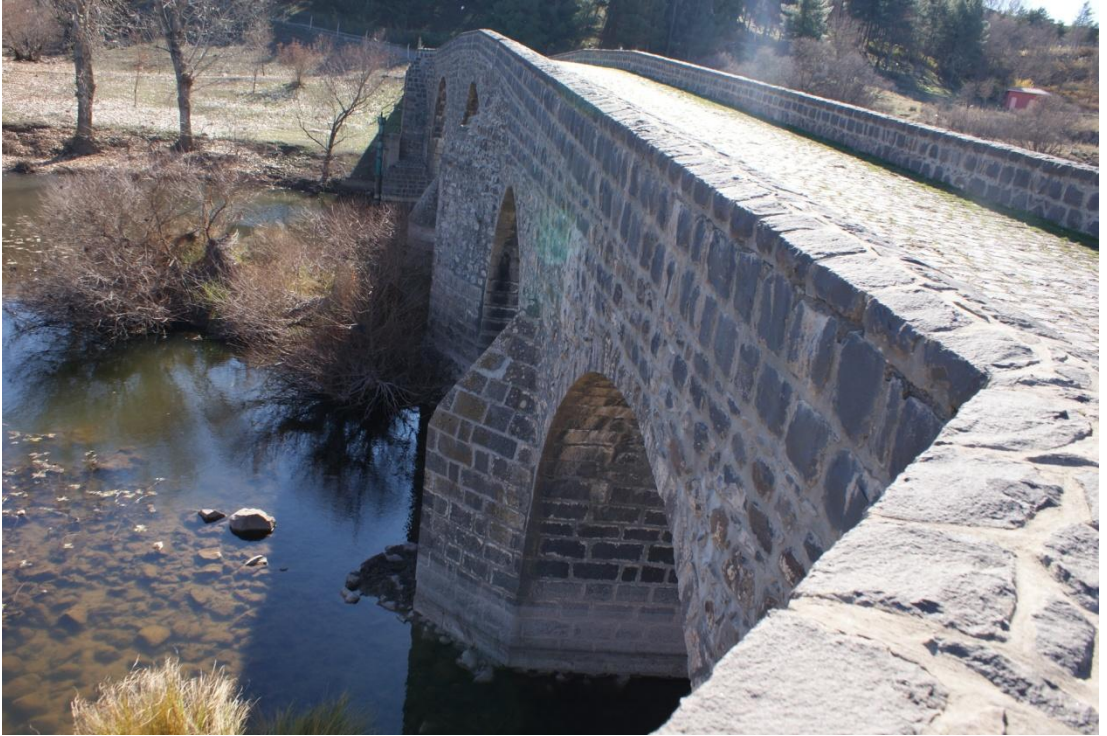
Resim 22: Devegeçidi Köprüsü: Köprünün üstü ve köprü yolu (Şafak Kutlay)
