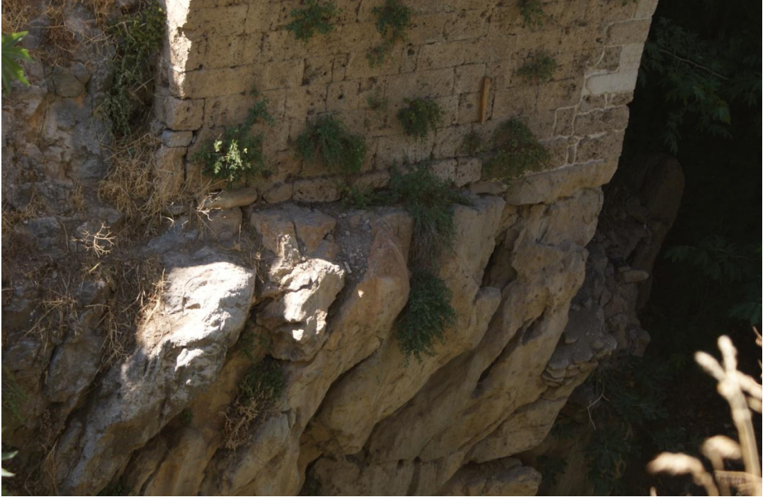
Resim 11: Çüngüş Köprüsü: Köprü ayaklarının oturduğu doğal kaya(Şafak Kutlay)
