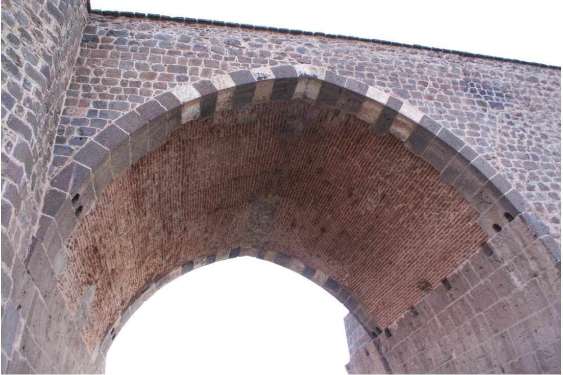
Resim 58: Dicle (Ongözlü Köprü) Köprüsü: Kemer tonozlarında tuğla kullanımı (Şafak Kutlay)
