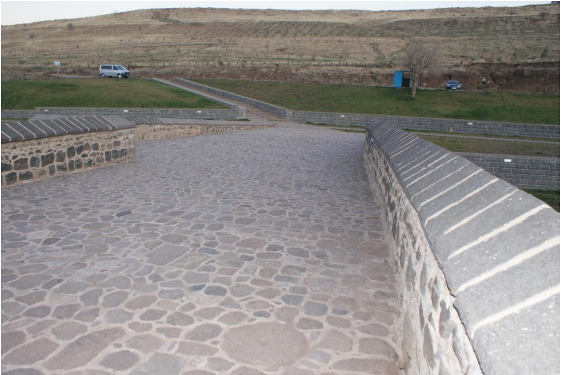
Resim 52: Dicle (Ongözlü Köprü) Köprüsü: Köprü korkuluğu (Şafak Kutlay)
