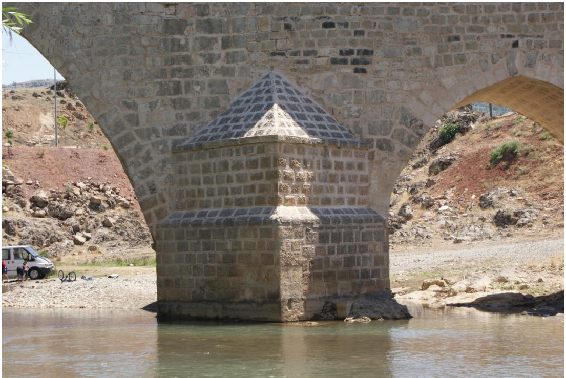
Resim 70: Haburman Köprüsü: Suyun kaynak tarafı selyaranlar (Şafak Kutlay)
