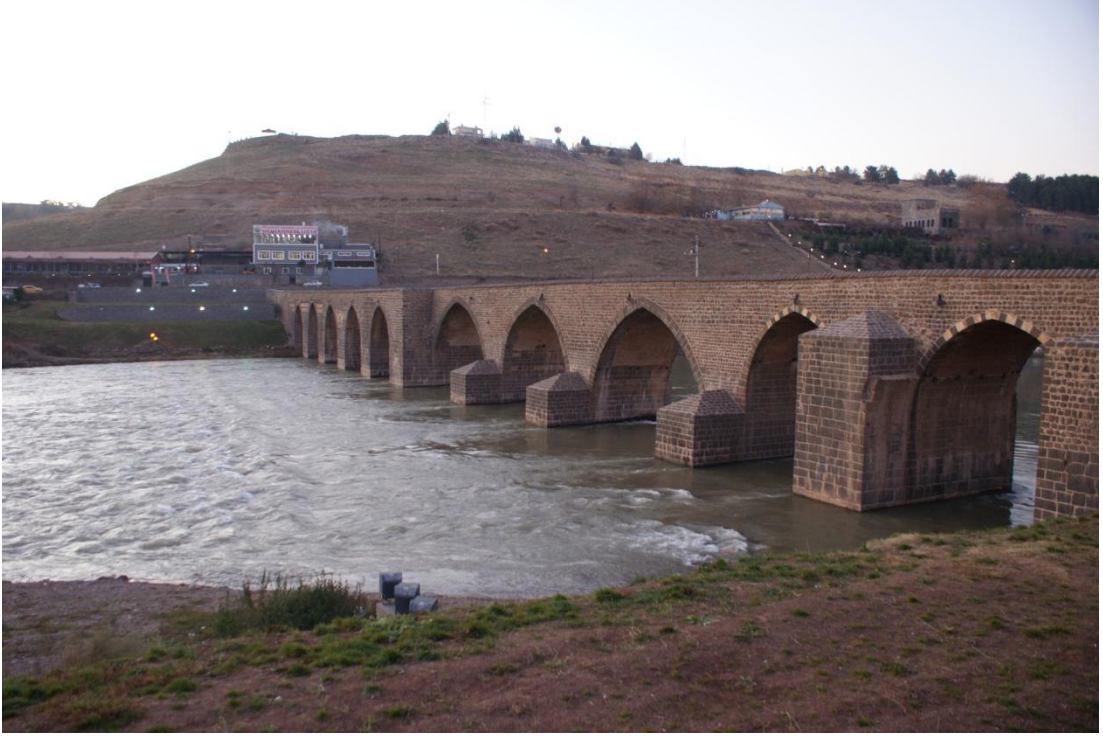
Resim 53: Dicle (Ongözlü Köprü) Köprüsü: Suyun aktığı taraf İstinat Duvarları (Şafak Kutlay)
