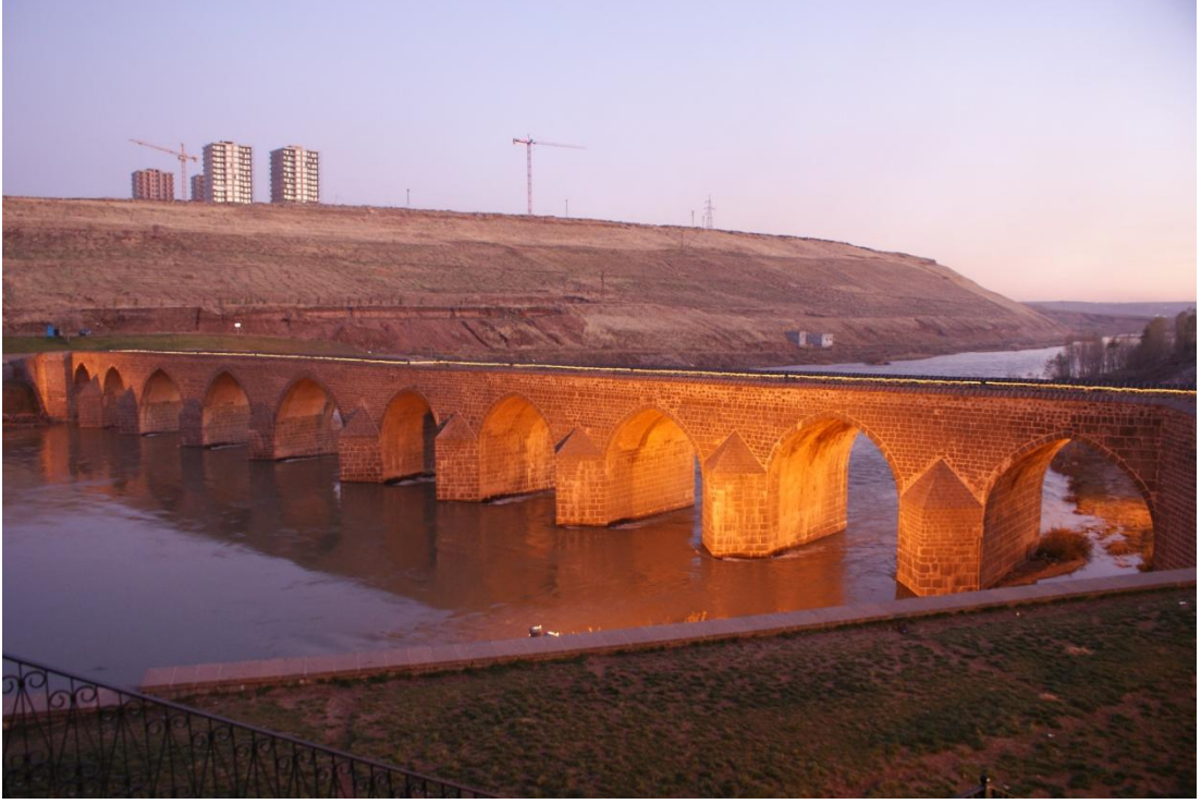
Resim 45: Dicle (Ongözlü Köprü) Köprüsü: Suyun kaynak tarafı (Şafak Kutlay)
