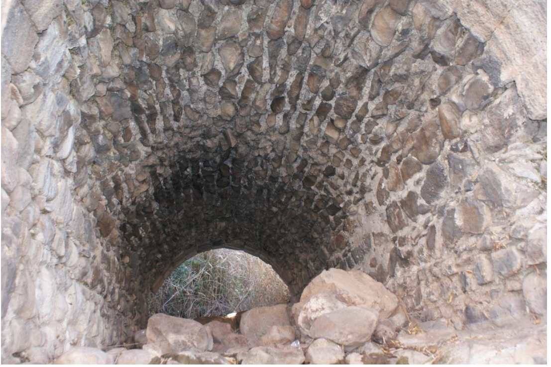
Resim 37: Devedeğidi Menfez Köprüsü: Kemer tonozu (Şafak Kutlay)
