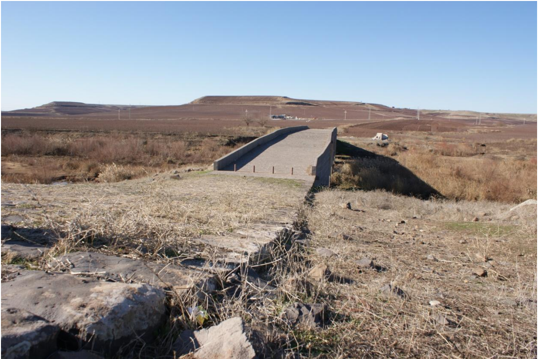
Resim 108: Karasu Köprüsü: Köprü üstü ve yolu (Şafak Kutlay)
