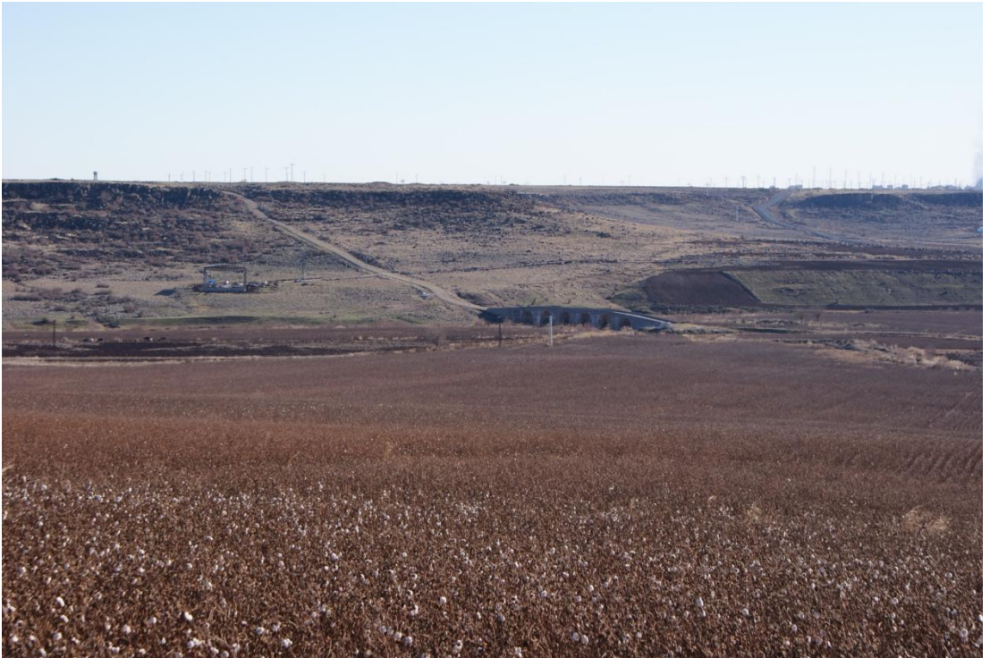
Resim 114: Karasu Köprüsü: Genel görünüş (Şafak Kutlay)
