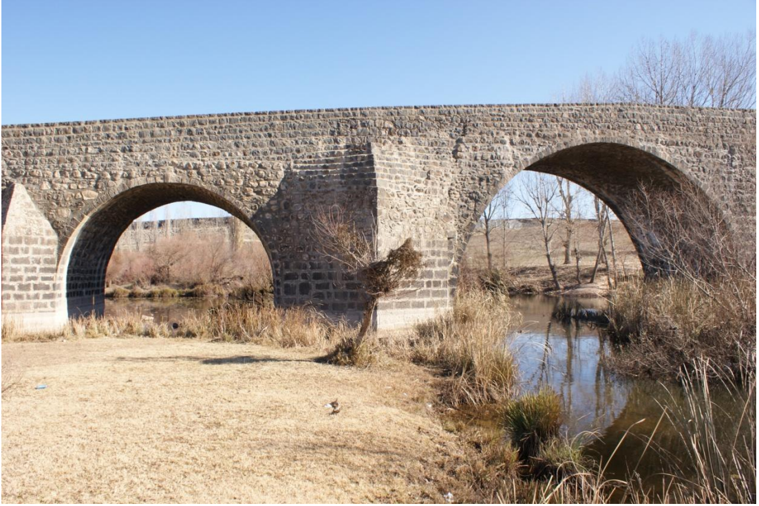
Resim 29: Devedgeçidi Köprüsü: Suyun kaynak tarafından selyaranlar (Şafak Kutlay)
