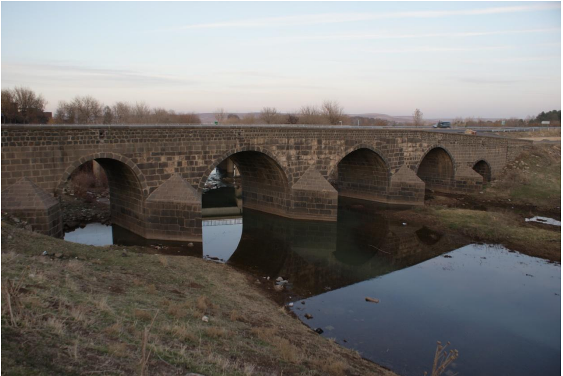
Resim 98: Kara Köprü: Suyun kaynak tarafından soldan ilk iki göz yuvarlak (Şafak Kutlay)
