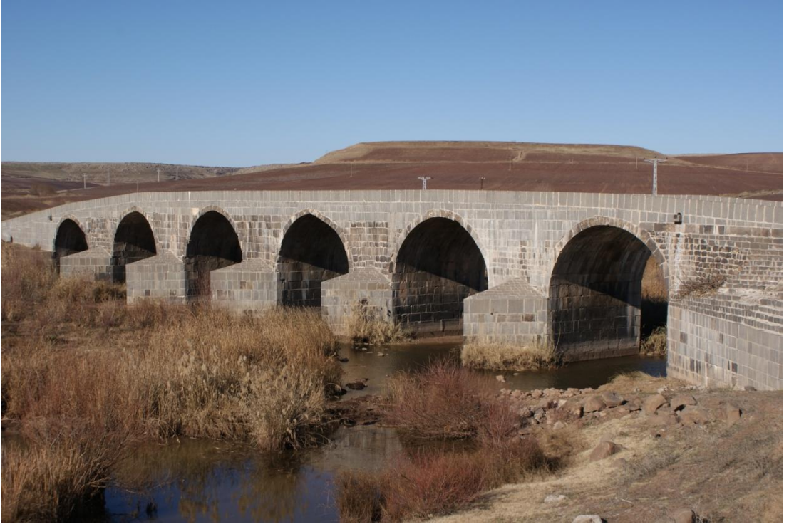
Resim 106: Karasu Köprüsü: Suyun kaynak tarafı (Şafak Kutlay)
