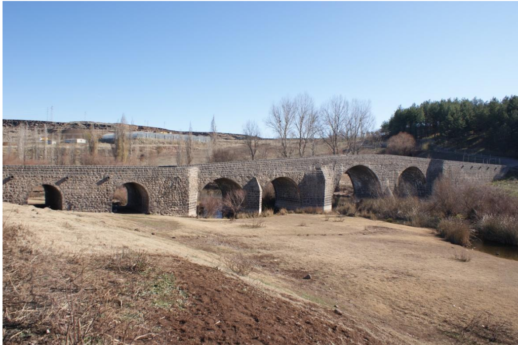
Resim 28: Devedgeçidi Köprüsü: Suyun kaynak tarafından selyaranlar (Şafak Kutlay)
