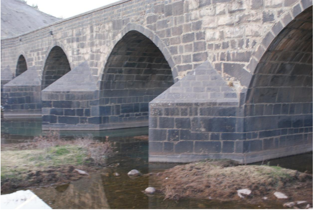
Resim 101: Kara Köprü: Suyun kaynak tarafı selyaranlar (Şafak Kutlay)
