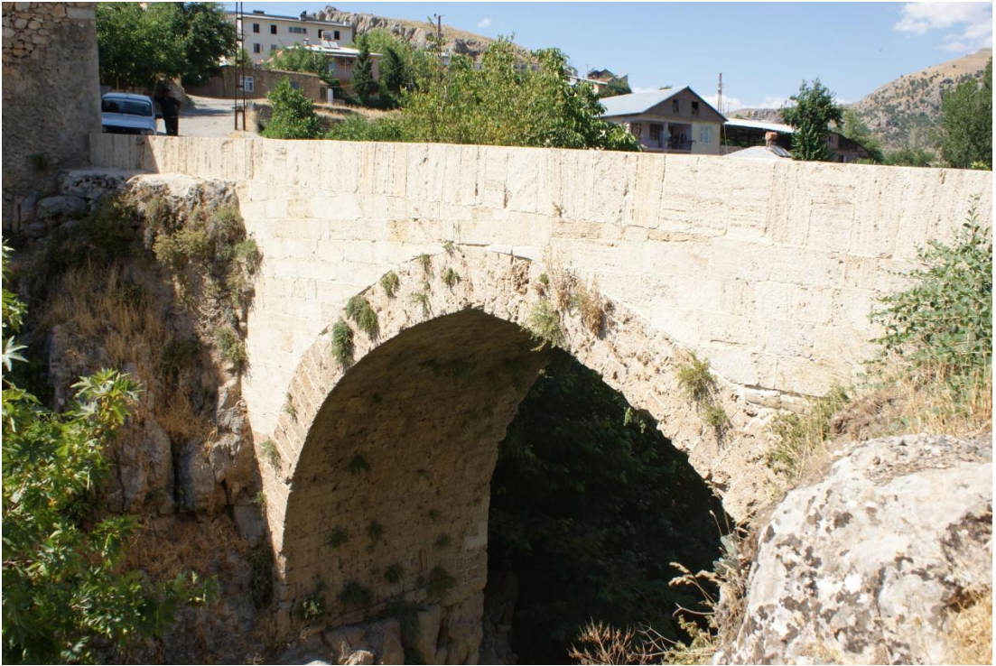
Resim 10: Çüngüş Köprüsü: Suyun aktığı taraf sivri kemer ayrıntısı (Şafak Kutlay)
