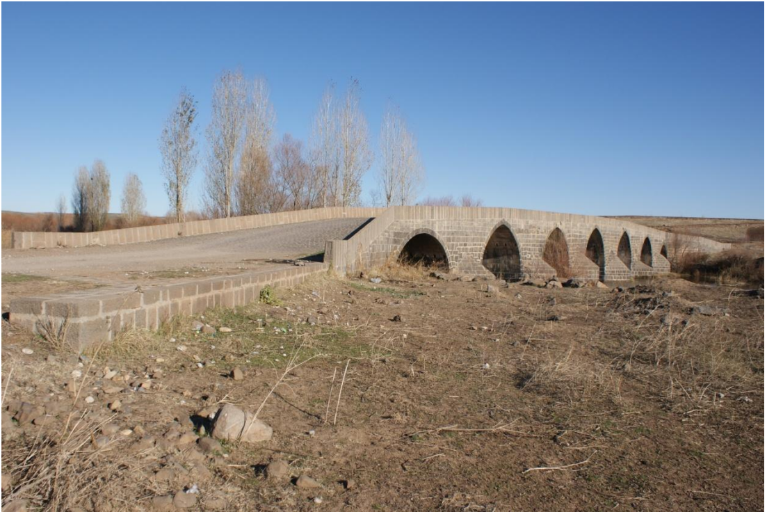
Resim 92: Halilviran (Artukoğulları) Köprüsü: Köprünün bugünkü durumu (Şafak Kutlay)
