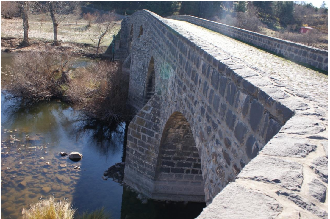
Resim 26: Devegeçidi Köprüsü: Suyun aktığı taraftan selyaranlar (Şafak Kutlay)
