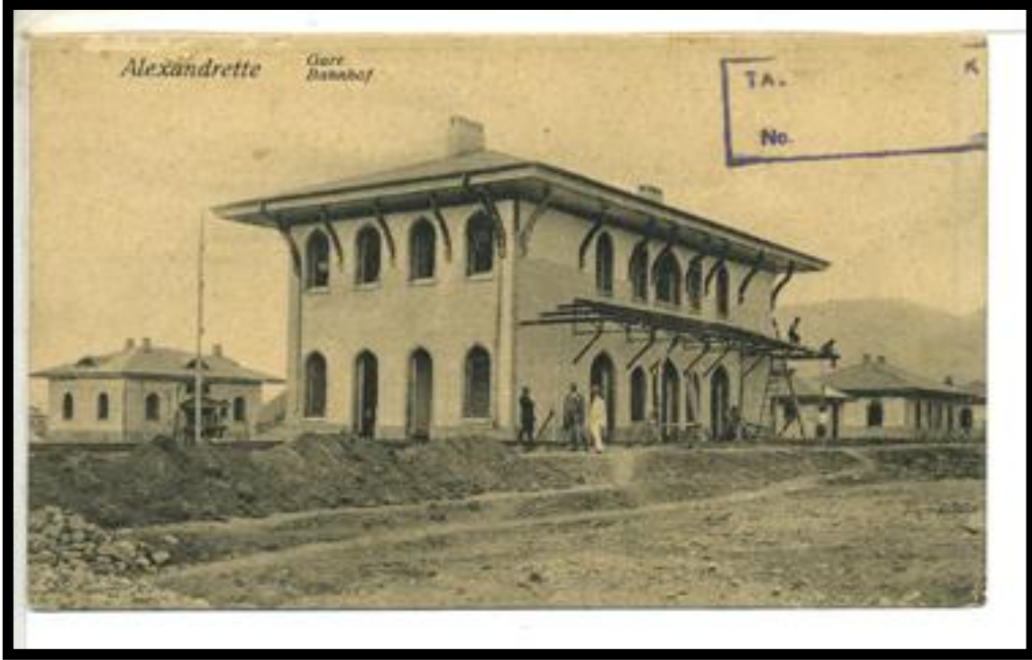
Fotoğraf 5 Toprakkale İskenderun Demir yolu Hattının İskenderun İstasyonu 2056
