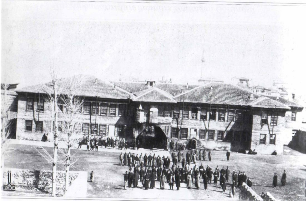
Ek-8: Hükümet Konağı
