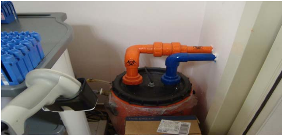
Resim 4.4. Tıbbi Atık Dezenfeksiyon ve Nötralizasyon Sistemi ara toplama tankı
