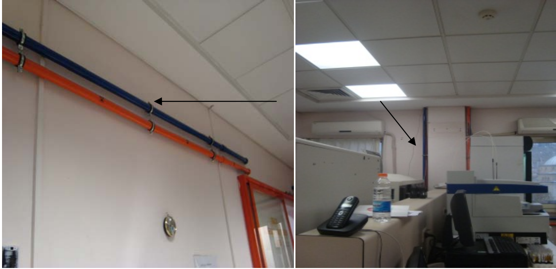
Resim 4.5. Laboratuvar sıvı atıklarını toplayarak sisteme veren giriş boruları
