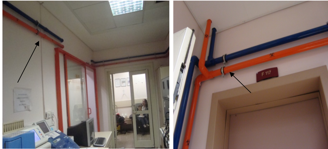
Resim 4.6. Laboratuvar sıvı atıklarını toplayarak sisteme veren çıkış boruları
