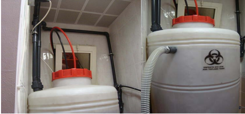
Resim 4.7. Enfekte sıvı atık ana toplama tankı
