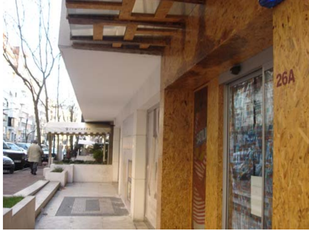
Şekil 4.36 : Mağaza dış cephe görünümü.
