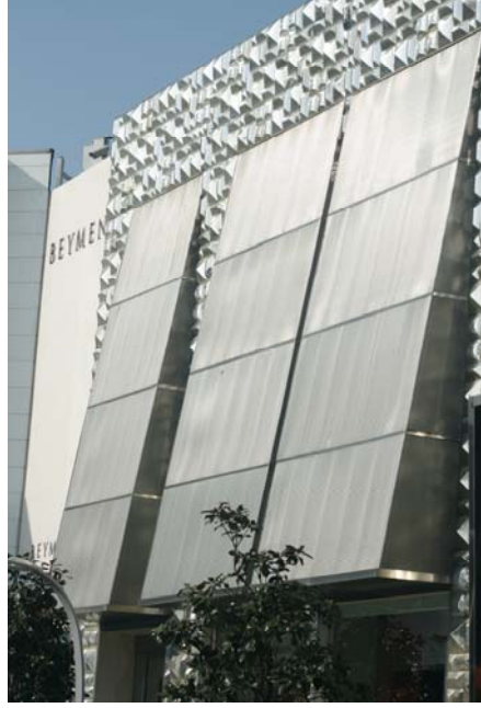
Şekil 4.22 : Paslanmaz çelik örgü malzemede oluşan deformasyon.
