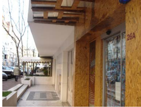
Şekil 4.44 : OSB’ de zamanla oluşan renk değişikliği.
