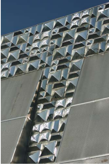
Şekil 4.23 : Paslanmaz çelik örgü, bitiş lama ve köşebentlerinde oluşan korozyon.
