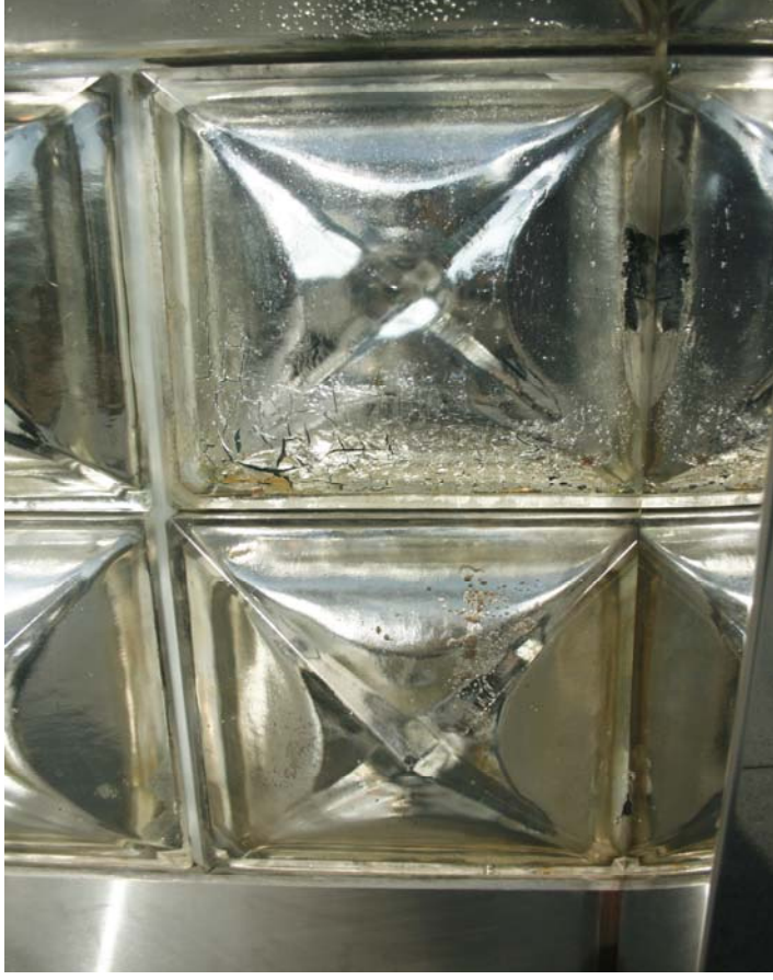
řekil 4.7 : Ayna sırrı bozulması sonucu cam blok grnm.
