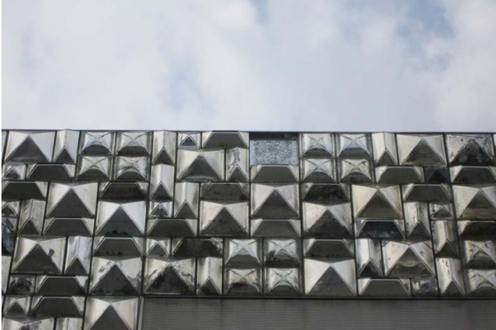
řekil 4.8 : Cam blok kaplamada dřme sonucu ortaya ıkan grnt.
