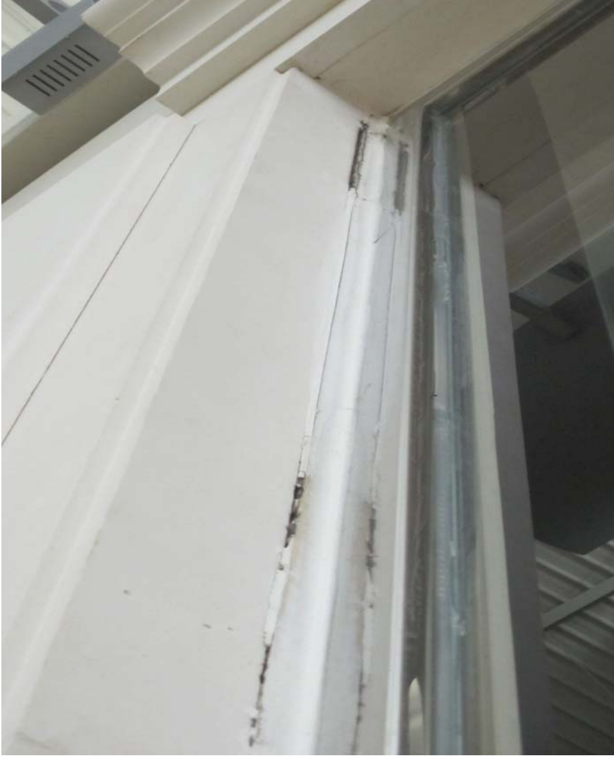
Şekil 4.50 : AVM kolonu-doğrama birleşimi silikon macun uygulanmış görünümü.
