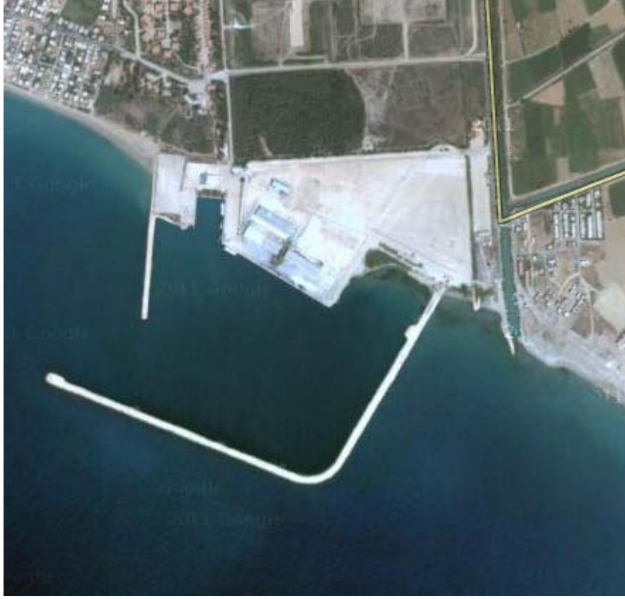
Şekil 7.27 Taşucu SEKA Limanının mevcut durumu
