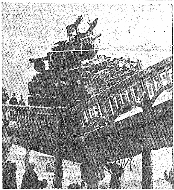
Korede üzerinden bir tank geçerken çöken köprü (Foto: Intercontinentale)
