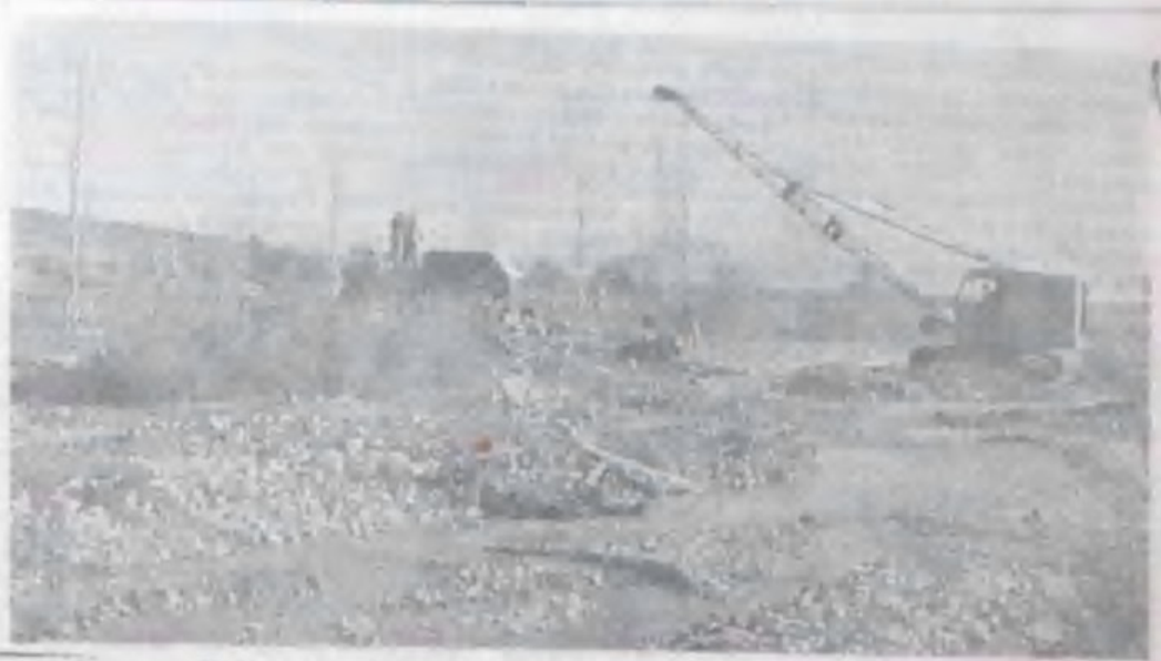
Yurtda yapılacak ta olan yol inşaatı faaliyetlerinden bir görünüşü
