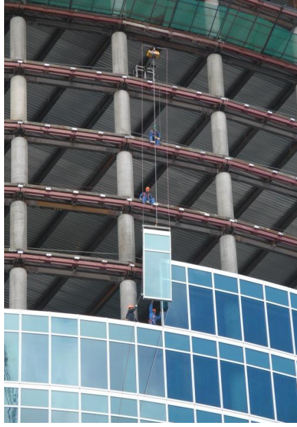
Şekil 3.5. Panel montajı (Panel ebadı : 4300mm x 1512mm, Ağırlığı : 450kg)
