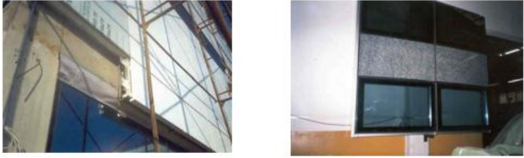
Şekil 3.7. Yarı panel sistem uygulaması (Sezer, 2005)
