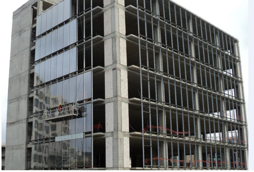
Şekil 3.4. Stick (Çubuk) Sistem uygulaması
