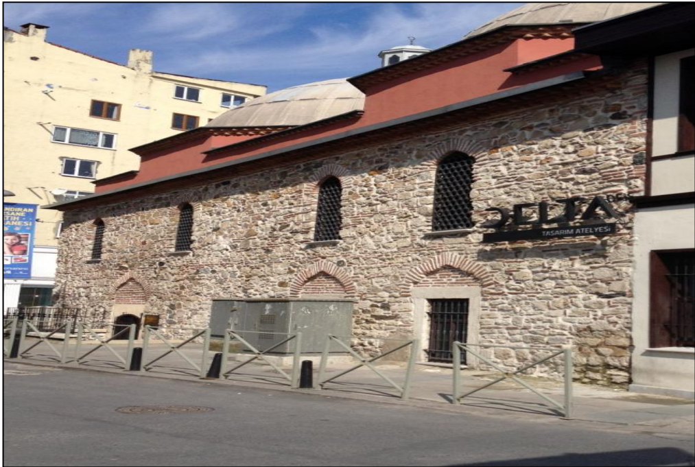
Şekil 3.75. Yapının Doğu Cephesinde Yeniden Açılmış Olan Pencereleler (15.03.2012)
