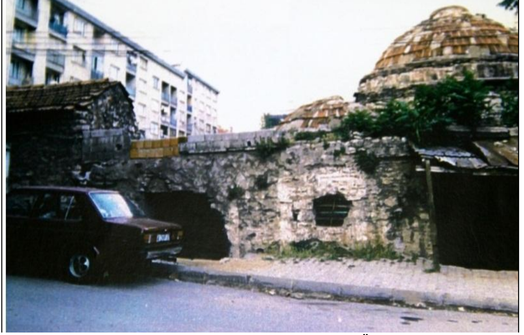
Şekil EK-A.1. Samatya Ağa Hamamı Restorasyon Öncesi Görünümü [ http://agahamam.com/Fotodraflar/fotodraflar.html ] (10.09.2012)
