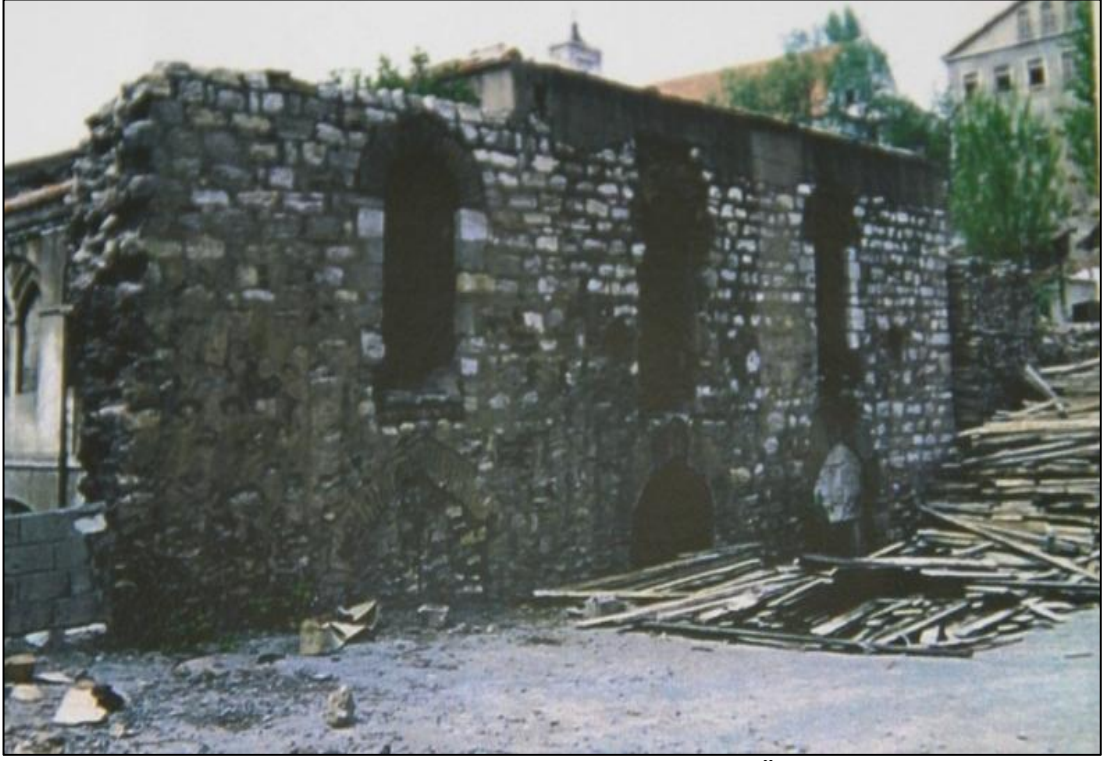
Şekil EK-A.5. Samatya Ağa Hamamı Restorasyon Öncesi Görünümü [ http://agahamam.com/Fotodraflar/fotodraflar.html ](10.09.2012)
