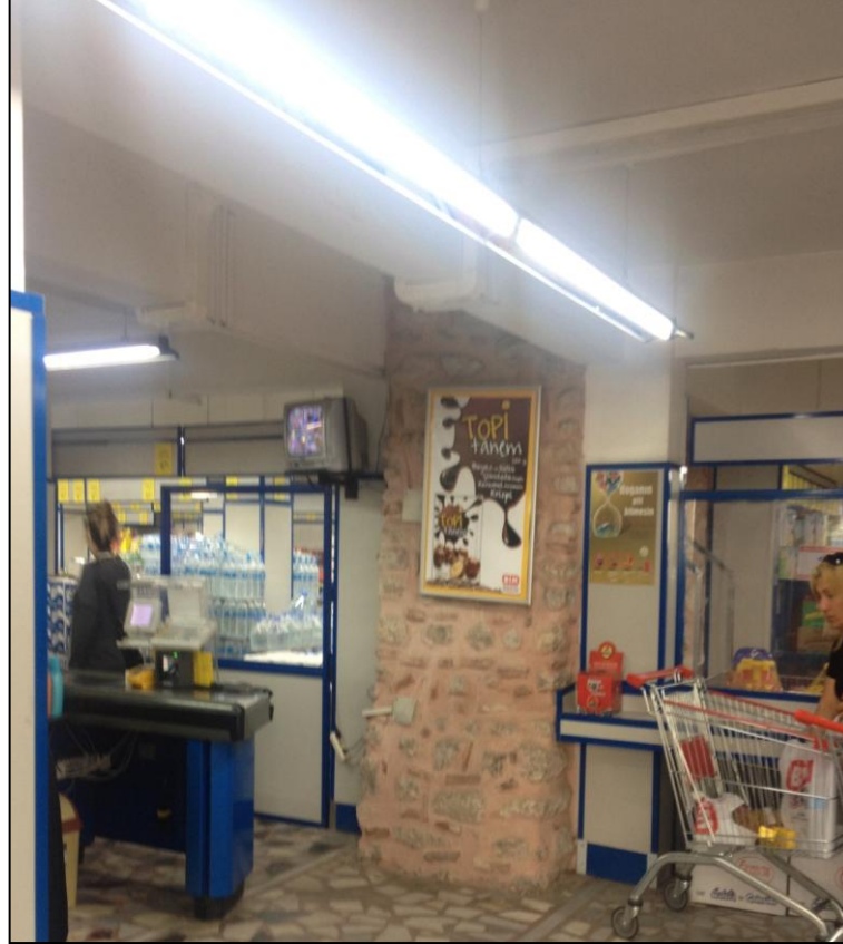
Şekil 3.27. Bodrum Katta Bulunan Pvc Kaplama Panel ve Moloz Taş Ayak (13.05.2012)
