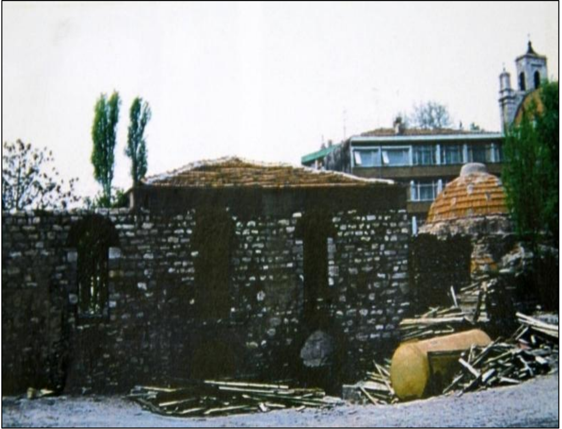
Şekil EK-A.4. Samatya Ağa Hamamı Restorasyon Öncesi Görünümü [ http://agahamam.com/Fotodraflar/fotodraflar.html ] (10.09.2012)
