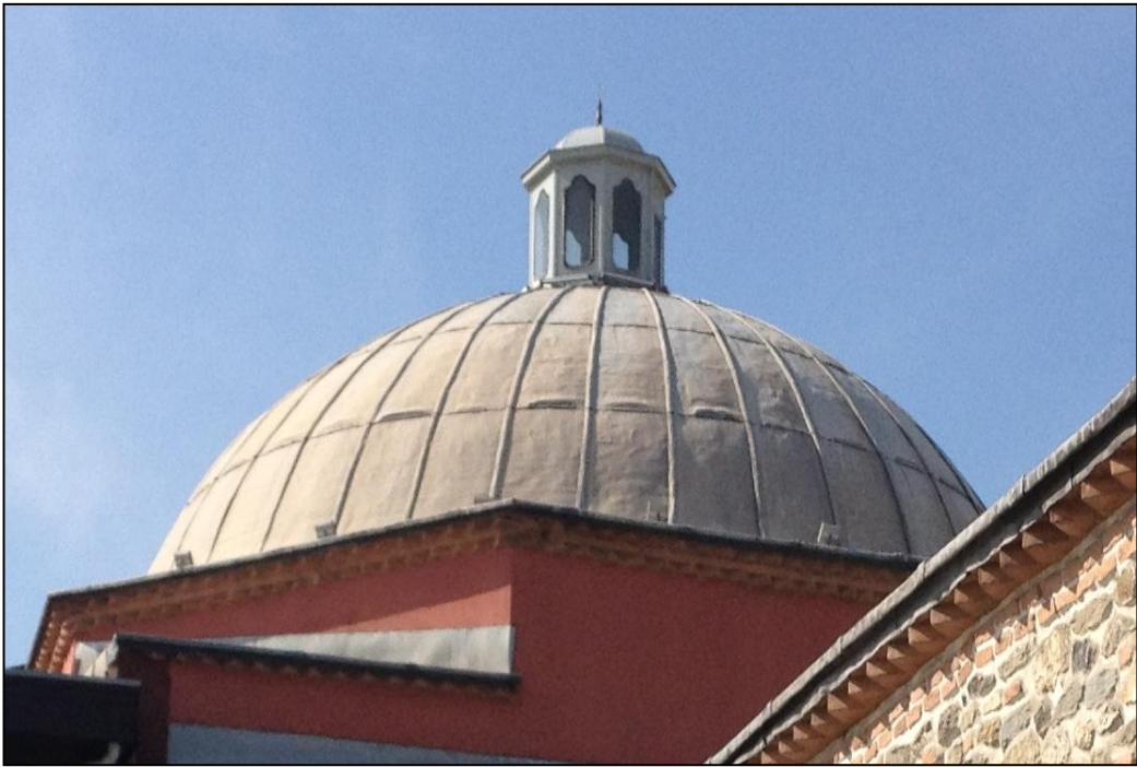
Şekil 3.48. Ortaköy Hamamı'nın Restorasyon Sonrası Aydınlık Feneri (15.03.2012)
