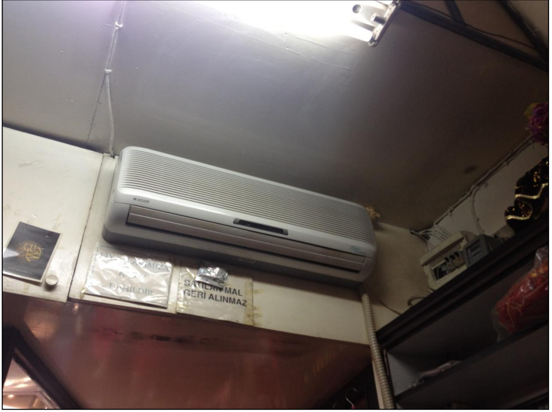
Şekil 3.89. Çarşı Holünde Bulunan Dükkan (Eyvan) (15.03.2012)
