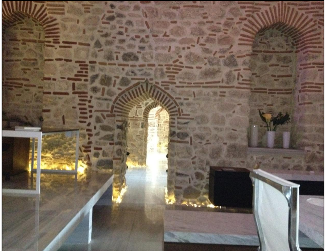
Şekil 3.53. Seminer Salonu (E. Soğukluğu), Doğu Duvarı (15.03.2012)
