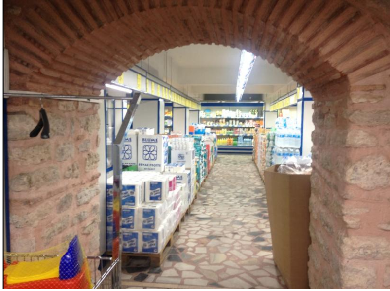
Şekil 3.28. Bodrum Katta Bulunan Kemerli Duvar Boşluğu (13.05.2012)
