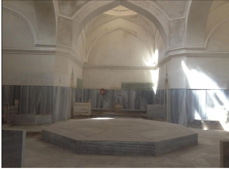
Şekil 2.23. Beyazıt Hamamı, Sıcaklık Bölümü Göbek Taşı (13.05.2012)
