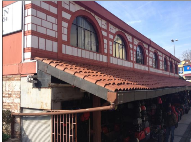
Şekil 3.92. Hamama Sonradan Eklenen Dükkan Yapısı (15.03.2012)
