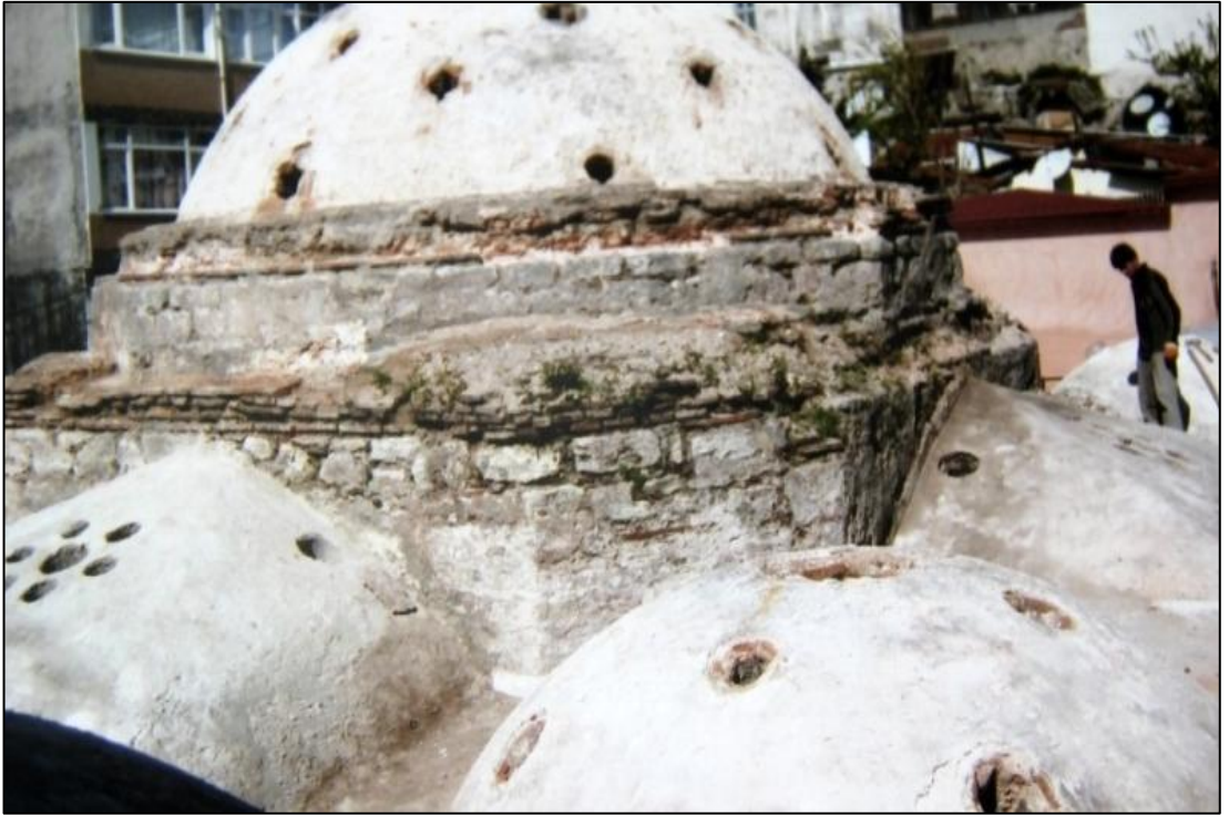
Şekil EK-A.6. Samatya Ağa Hamamı Restorasyon Öncesi Görünümü [ http://agahamam.com/Fotodraflar/fotodraflar.html ] (10.09.2012)
