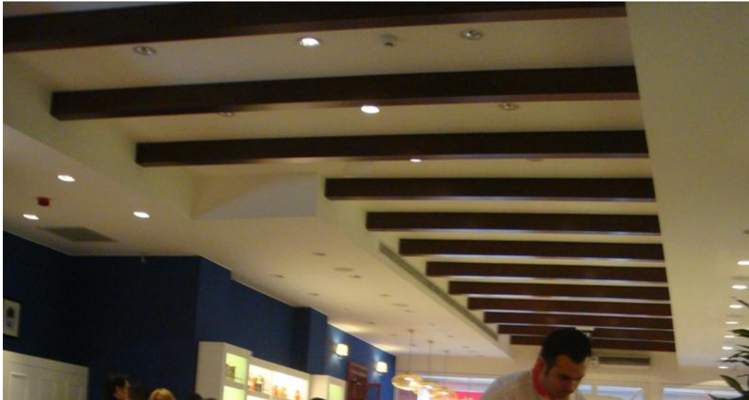
Resim 3.114: Zamane Kahvesi, asma tavan içerisinde aydınlatma elemanları
